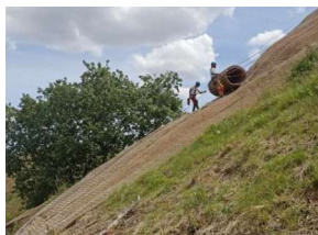
Posa di rete metallica con biostuoia
