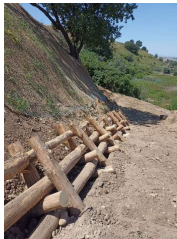
Palificata viva tipo Roma in fase di realizzazione
