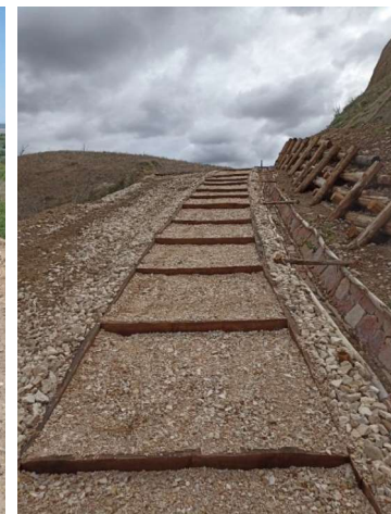
Sentiero ripristinato con canaletta e palificata adiacente
