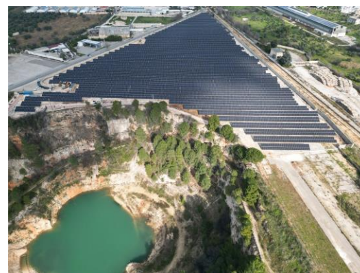
Vista panoramica dell'ex sito produttivo
