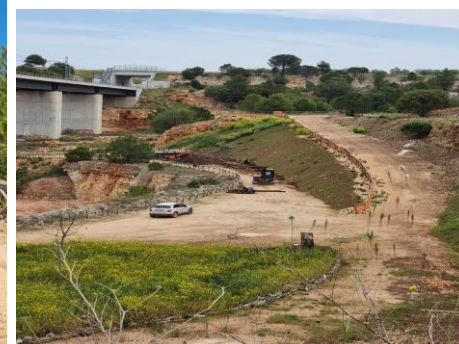
Messa in sicurezza del pendio della rampa di collegamento dei livelli di cava con palificata viva a parete doppia e grata viva
