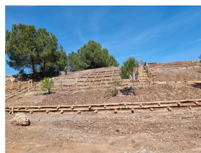
Messa in sicurezza di scarpata mediante palificata viva a parete doppia, grata viva, palizzata viva e graticciata
