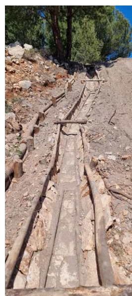
Canaletta in legname e paglia per convogliare le acque provenienti dal pianoro superiore
