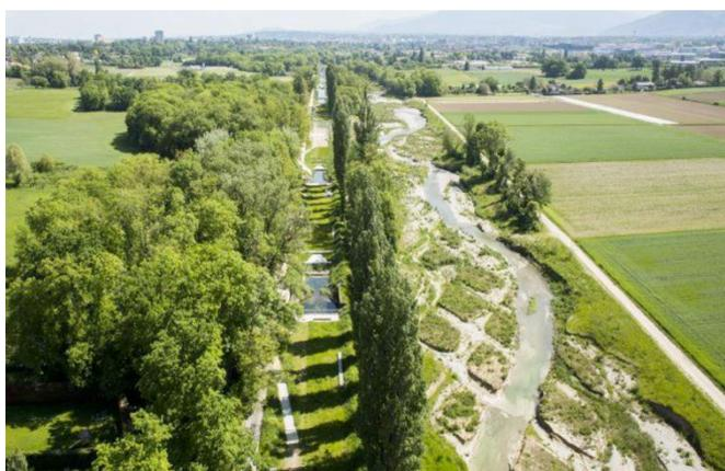
Esempio applicazione criteri di B. Lachat con scavi romboidali di invito alla meandrazione. Fonte B. Lachat
