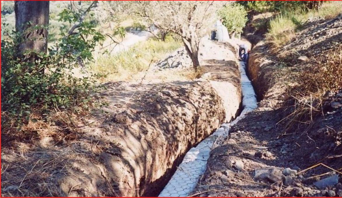
*Alcara Li Fusi (ME), Contrada Timpa Canale - Drenaggio e canalizzazione profonda con gabbionata, 2003 - Foto Doria*
