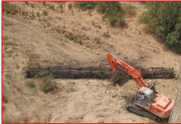
*Oasi Fluviale Valle del Morello: repellente vivo per aree di ristagno costituito da fascine di canne e tamerici da legare con fil di ferro ai pali e successiva intasatura con terra vegetale – Foto Pirrera*
