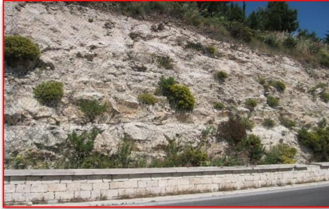
*Scarpata stradale Chiaramonte Gulfi (RG) - L'applicazione non completata da idrosemina, rallenta notevolmente l'inerbimento e la perdita di suolo continua inesorabilmente – Foto Pirrera*
