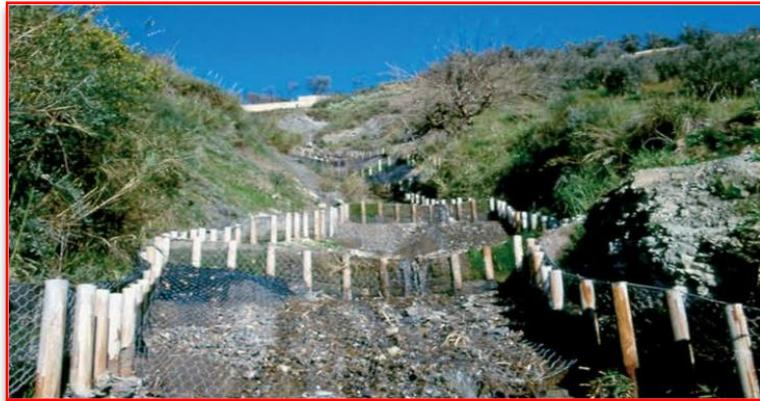
*In foto una variante sul Torrente Giarina (ME) realizzata mediante graticciata in micropali corten, reti metalliche e stuoie tridimensionali - Foto Sauli*
