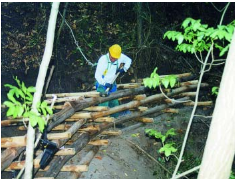
Lavoratori in cantiere
