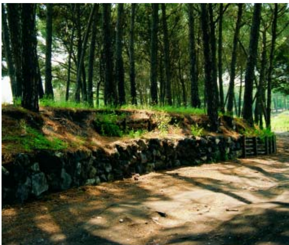
Palizzate e muro a secco
