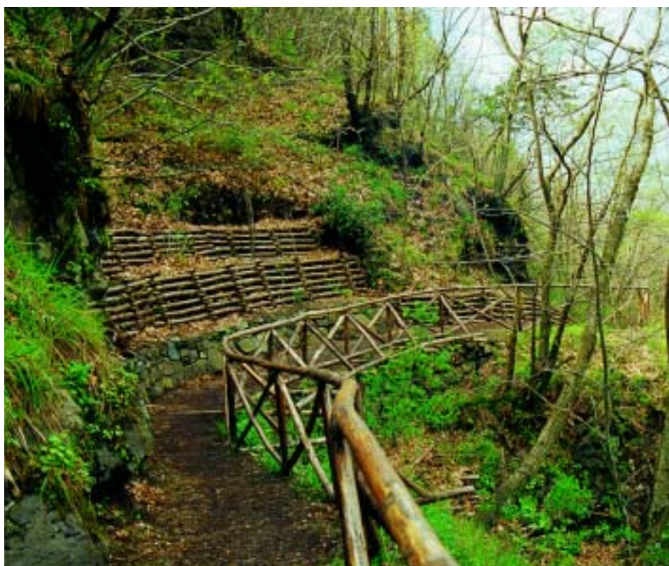
Intervento combinato: muro a secco, palificata viva doppia
