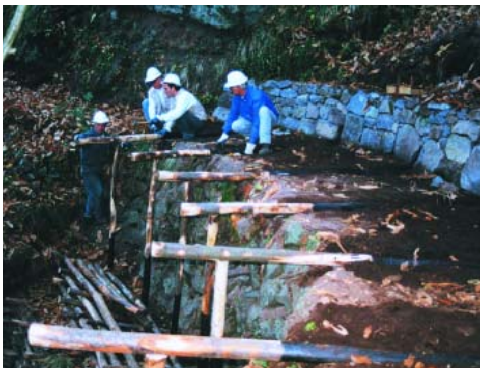
Lavoratori in cantiere
