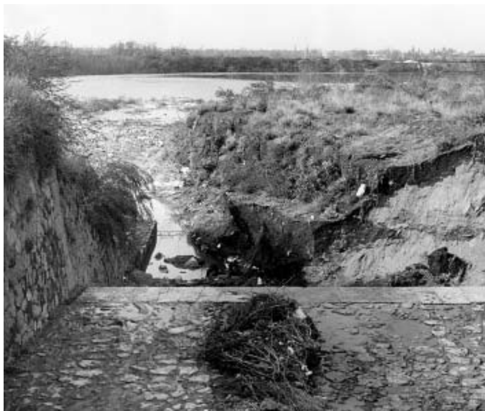
Vasca di laminazione realizzata agli inizi del '900 nella zona pedemontana del Monte Somma. Pomigliano d'Arco, fine anni Settanta foto di G. Doronzo
