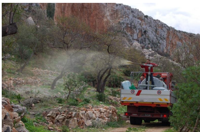
Idrosemina e hydromulching con ammenndante da Posidonia spiaggiata.
