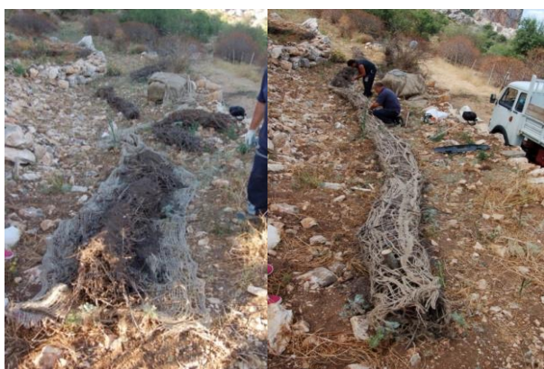
Realizzazione di Biorulli con tecnosuoli e sarmenti, (2014)
