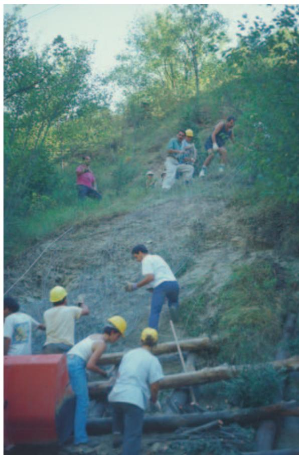
Fig. 4 – Sistemazione di rete metallica zincata a doppia torsione su testa della scarpata (luglio 2001).
