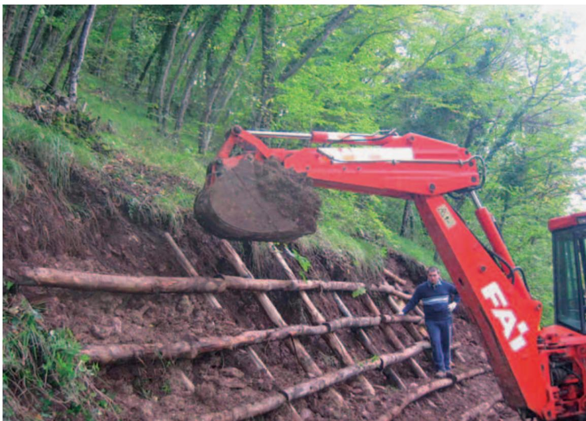
Foto 4 – Realizzazione della grata viva: riempimento con terra (ottobre 2005).
