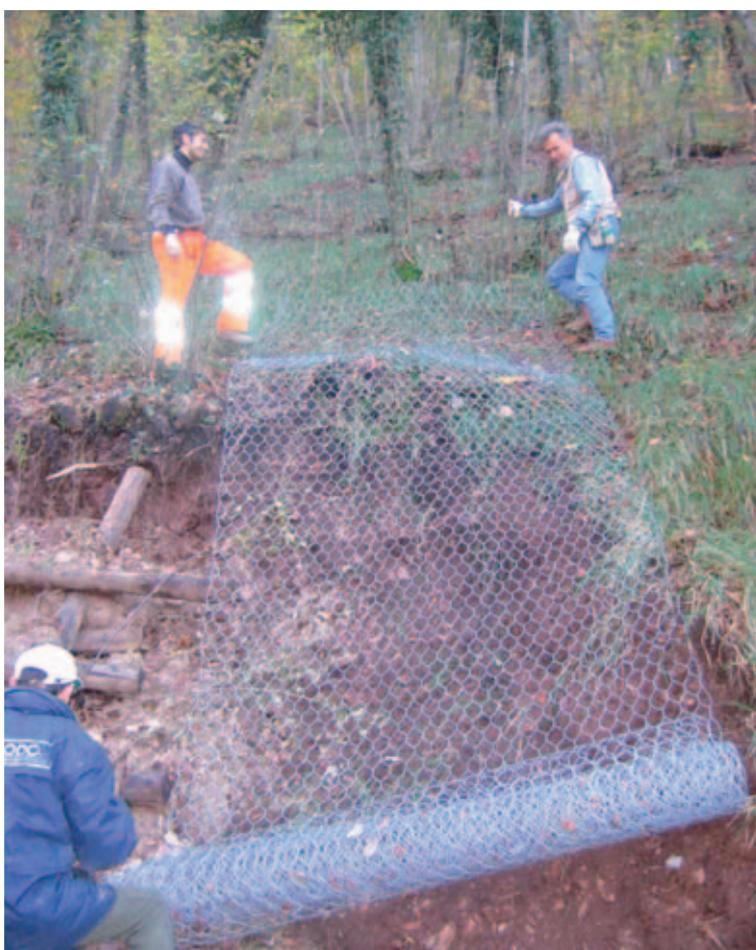
Foto 6 – Completamento dell'intervento con rete zincata a doppia torsione (ottobre 2005).
