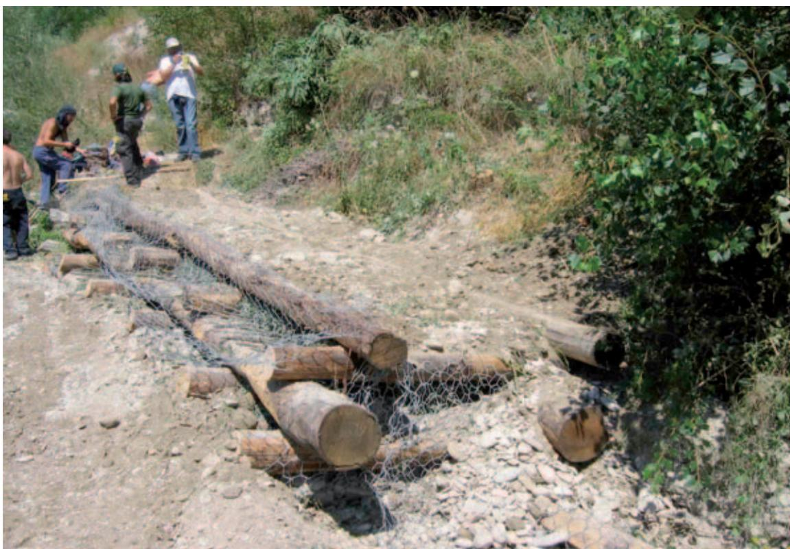
Foto 8 - Palificata spondale: riempimento con materiale inerte, terroso e chiusura della rete metallica (luglio 2004).
