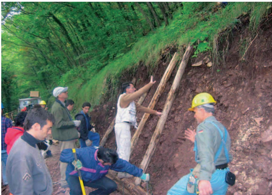
Foto 3 – Realizzazione della grata viva: sistemazione dei pali verticali (ottobre 2005).
