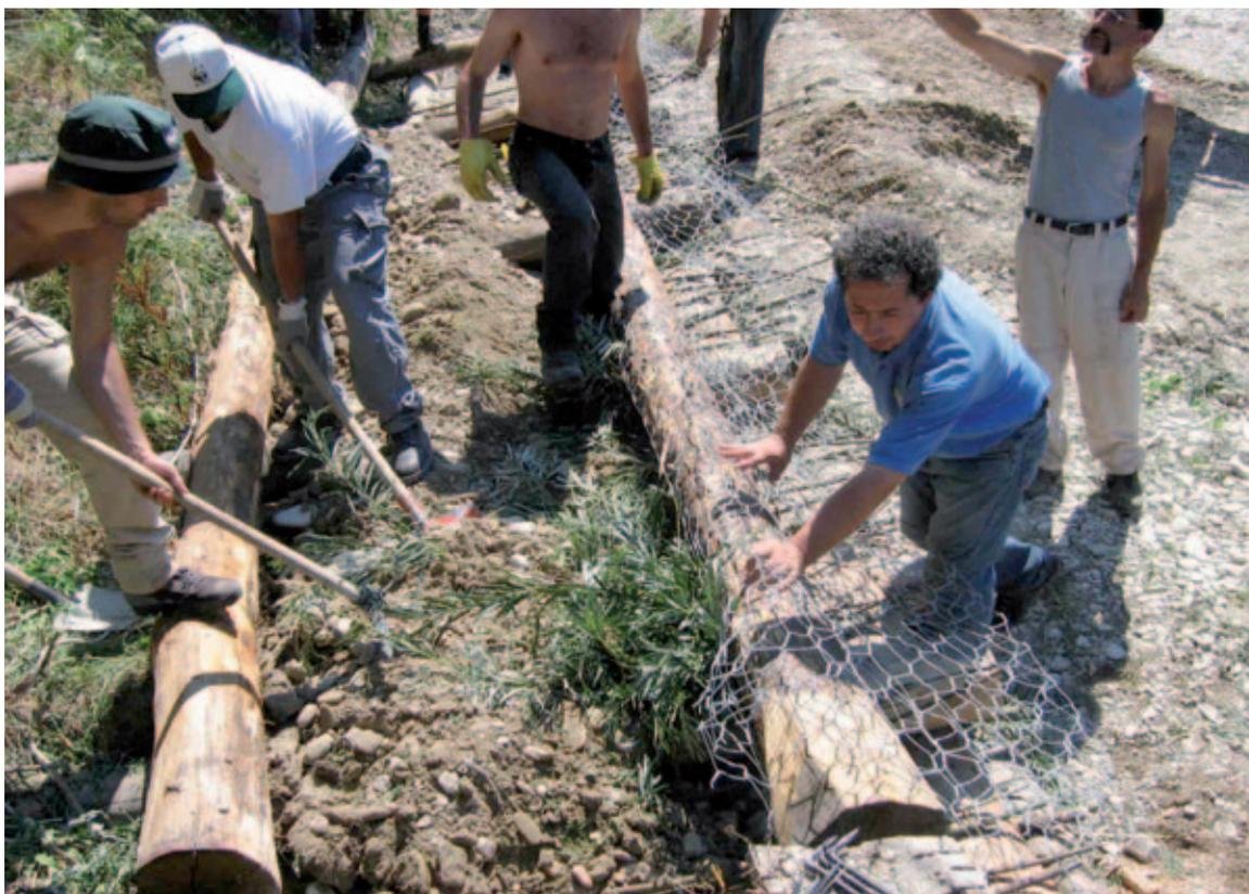
Foto 7 – Palificata spondale: riempimento e intasamento con fascine vive (luglio 2004).
