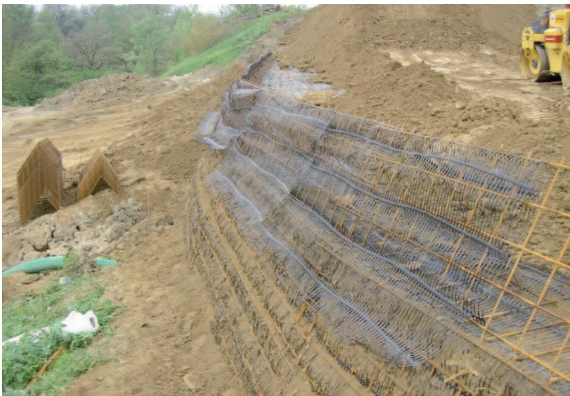
Foto 1 e 2 – Due fasi della preparazione di un nuovo lotto di abbancamento con la realizzazione di un piede in terra armata (foto Francesco Giambartolomei).
