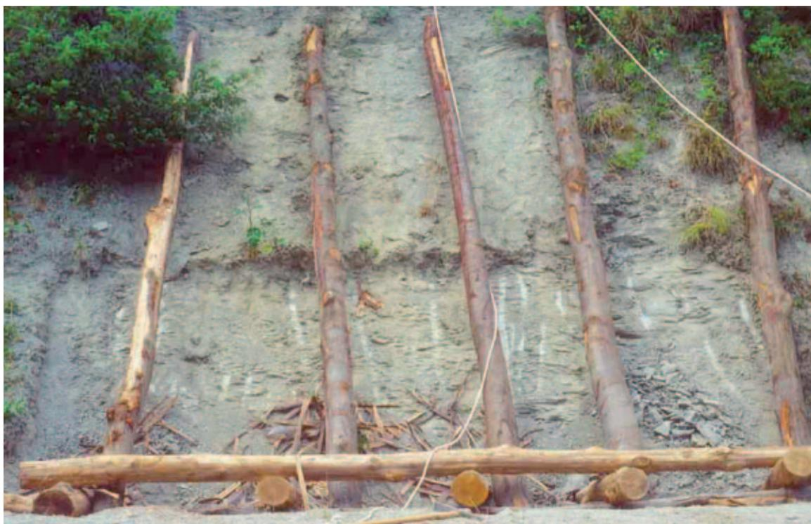
Fig. 2 – Realizzazione di grata viva con posa dei pali verticali su fondazione (luglio 2001).
