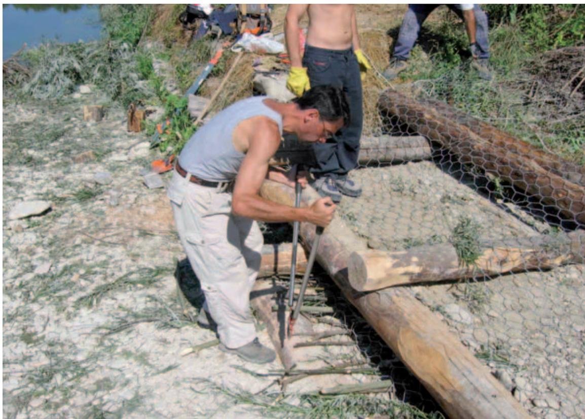
Foto 5 – Palificata spondale: ricopratura del primo ordine di tronchi e taglio delle talee di salice (luglio 2004).
