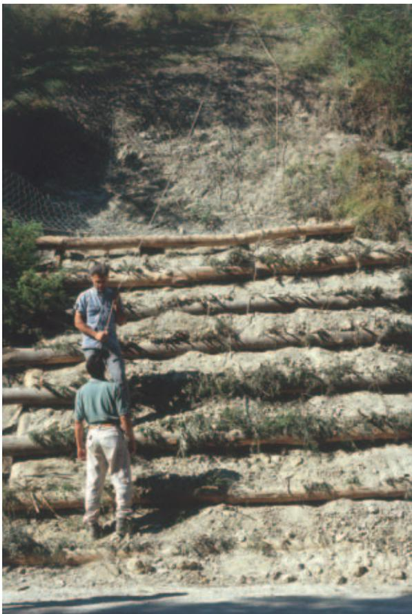
Fig. 3 – Grata viva con messa a dimora di piante arbustive autoctone in fitocella, e rete metallica zincata a doppia torsione in testa (luglio 2001).
