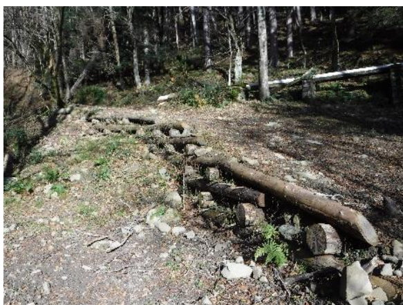
Palificata viva doppia a sostegno della strada
