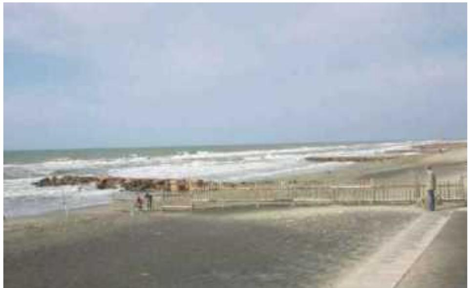
**Figura 4.2.9:** Vista verso mare di un pennello in pietrame. I pennelli in massi naturali agiscono come strutture di intercettazione e deviazione dei flussi litoranei, provocando una netta differenziazione evolutiva tra i due tratti di costa adiacenti ad esso.
