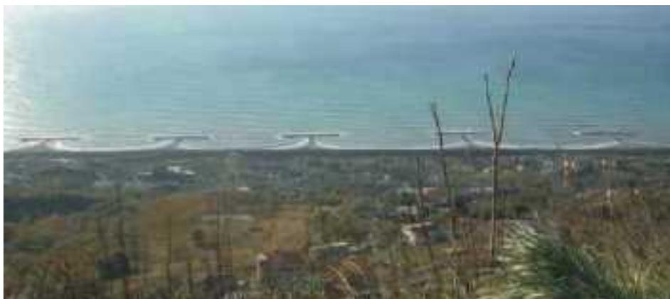
**Figura 4.2.5:** Marina di Massa (MS). Le strutture sono disposte in serie e variano in lunghezza da 30 metri a 100 metri, estendendosi dal retrospiaggia alla prima linea dei frangenti. La spaziatura dei pennelli deve essere abbastanza ampia da evitare lo scalzamento ai fianchi, ma abbastanza ridotta da costituire una trappola per i sedimenti.
