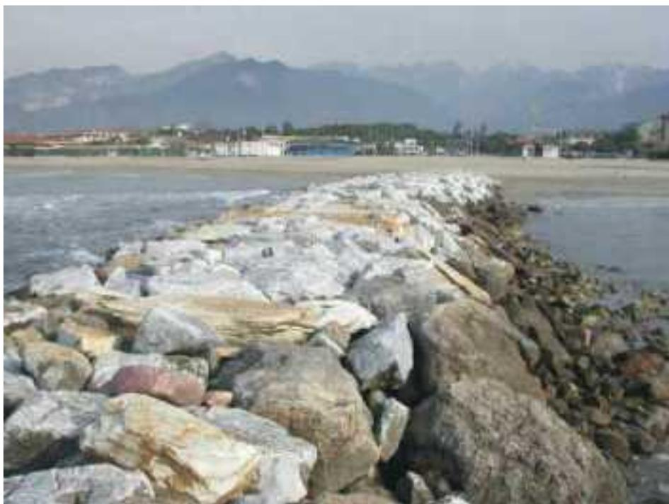
**Figura 4.2.11:** Ladispoli (Roma). Pennello in massi naturali. I pennelli, oltre ad ostacolare il naturale flusso delle correnti litorali, si oppongono direttamente anche, in alcuni paraggi, al moto di onde con fronte incidente obliquo rispetto alla costa.
