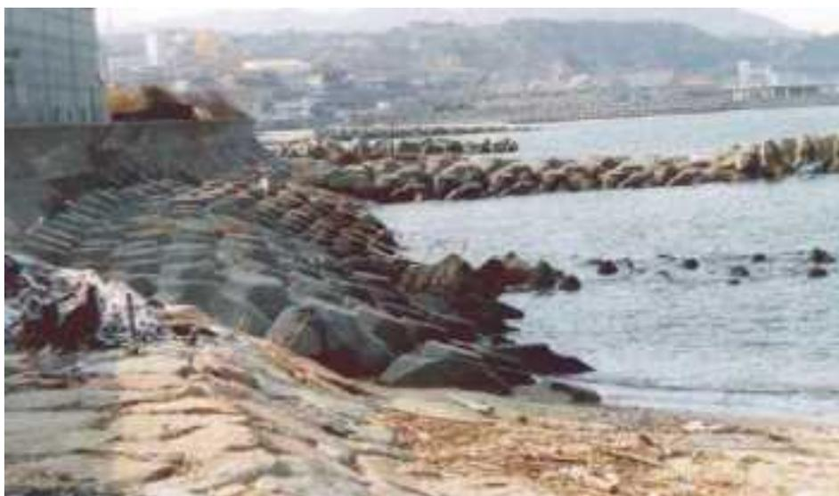
**Figura 4.3.2:** Schema di difesa aderente adatto a coste basse con azione ondosa limitata. Il sistema è costituito da rivestimento in piastre in calcestruzzo prefabbricato mutuamente incastrate tra loro, poggiate su sottofondo dotato di filtro. A completamento dell'opera una protezione al piede per contrastare lo scalzamento costituita da una barriera in massi e da un diaframma di palancole, in sommità un muro paraonde riflette le onde di risalita.
