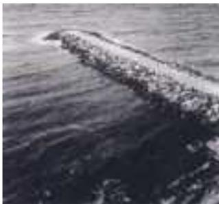
**Figura 4.2.13:** Sanremo. Pennello multistrato in massi naturali. Viene realizzato in paraggi esposti ad onde violente e con correnti di elevata intensità e capacità di trasporto. Tra la mantellata ed il nucleo è presente uno strato filtro intermedio. Tale strato impedisce l'asportazione del materiale fino costituente il nucleo della scogliera.
