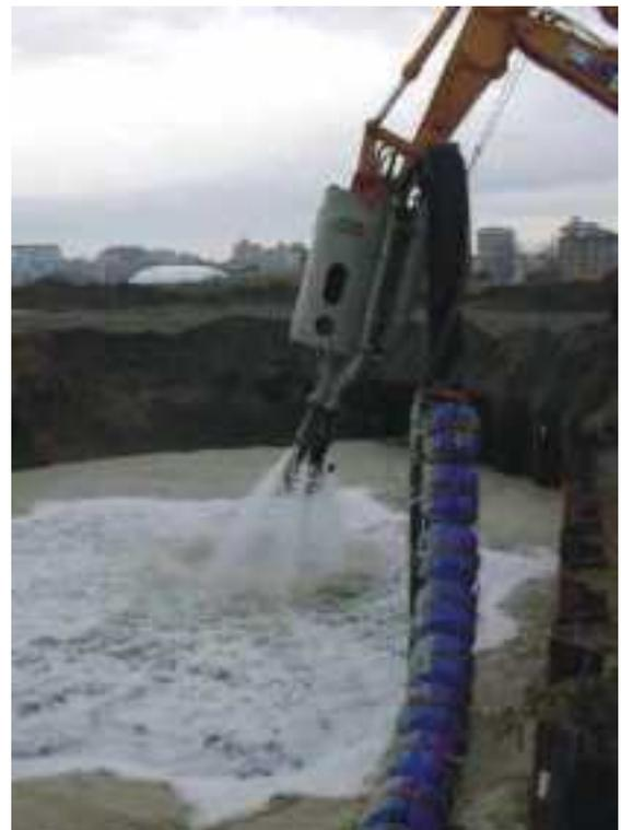
**Figura 4.4.9:** Disgregatore ad acqua utilizzato per mobilizzare il sedimento dall'area di dragaggio (Foto A. Peretti).
