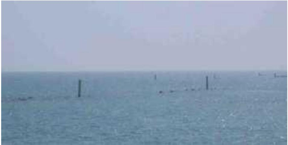
**Figura 4.1.29:** Le barriere sommerse, a differenza di quelle emerse, smorzano le onde solo parzialmente ma consentono un miglior ricambio delle acque. Vengono spesso costruite in combinazione con interventi di ripascimento e sistemi di pennelli, per la creazione di vere e proprie celle rettangolari che contribuiscono ad un miglior trattenimento dei sedimenti in prossimità della linea di riva.
