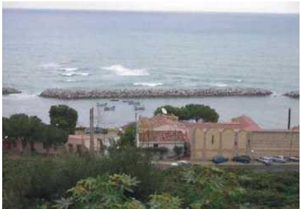
**Figura 4.0.6:** Le opere radenti o aderenti sono manufatti di tipo passivo-rigido, ubicati a terra, che hanno lo scopo di proteggere le infrastrutture presenti in prossimità della linea di riva o di difendere l'entroterra da inondazioni marine conseguenti a mareggiate.
