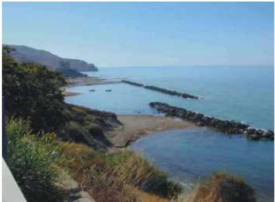
**Figura 4.1.2:** Azione delle barriere distaccate con formazione di tomboli a tergo. La capacità erosiva delle onde muove il materiale lungo i varchi, e successivamente ne favorisce la deposizione nella zona d'ombra, contribuendo alla formazione del tombolo. E' da notare che se i varchi sono troppo larghi i tomboli si formano con difficoltà, mentre se sono troppo stretti possono aversi problemi di ricambio delle acque e ritardi nella formazione dei tomboli.
