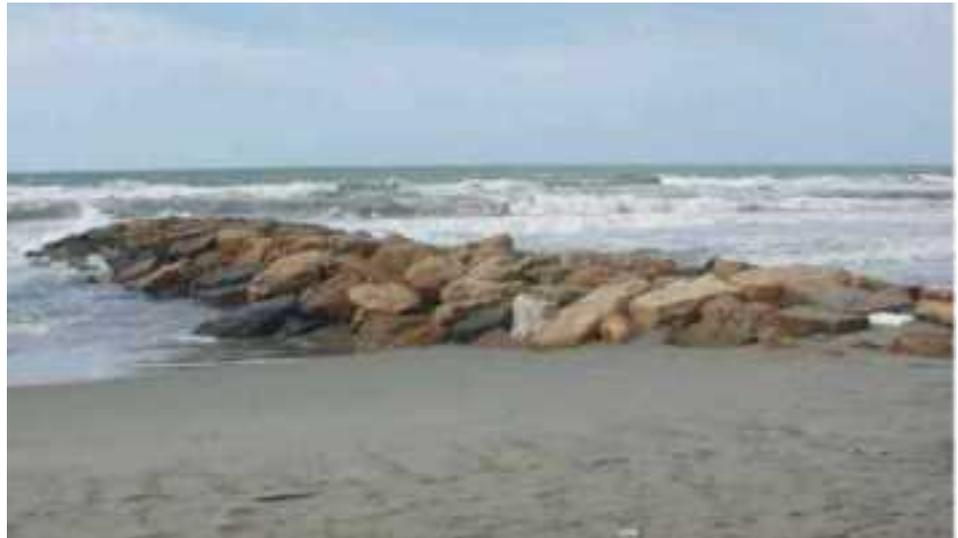
**Figura 4.2.12:** Pennello con mantellata in massi naturali. La disposizione degli elementi costituenti lo strato più esterno deve avvenire secondo una configurazione che sia più omogenea possibile. Dimensioni e dettagli devono essere determinati in base alle condizioni del sito, in particolare in base alle condizioni ondose incidenti.
