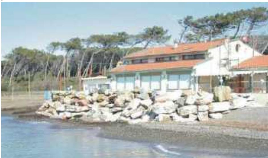
**Figura 4.3.29:** Scogliere radenti. Queste opere, essendo permeabili, consentono alla massa d'acqua di dissipare la gran parte dell'energia penetrando al loro interno e danno luogo ad un limitato approfondimento dei fondali antistanti. Esse sono indicate nei casi in cui gli apporti litoranei sono scarsi e la spiaggia è in forte arretramento.
