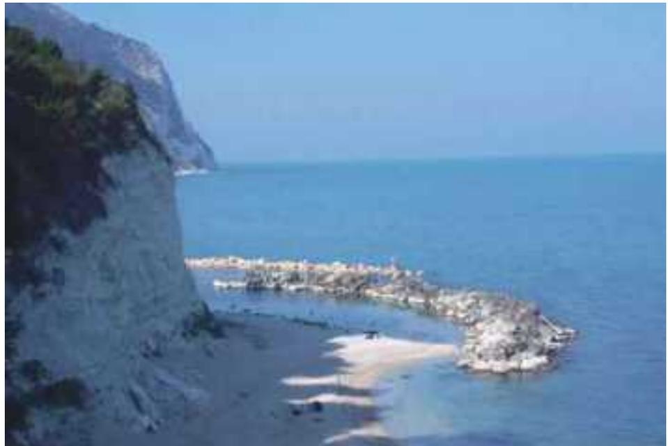
**Figura 4.1.8:** Spiaggia di Porto S. Giorgio (AP). Barriere frangiflutti emergenti, in massi naturali, disposte in modo lievemente obliquo rispetto alla linea di riva e perpendicolari alla direzione principale del fronte d'onda incidente. Si nota, fra le scogliere e la costa, la presenza di un tombolo in formazione, ancora sommerso.
