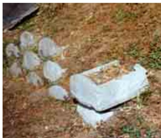
Per piccole scarpate esistono manufatti leggeri (Industria prefabbricati italiani) che consentono di costruire una parete di sostegno rinverdibile. In caso di necessità e per altezze superiori a 2-3 metri, gli elementi possono essere dotati di corti tiranti.
