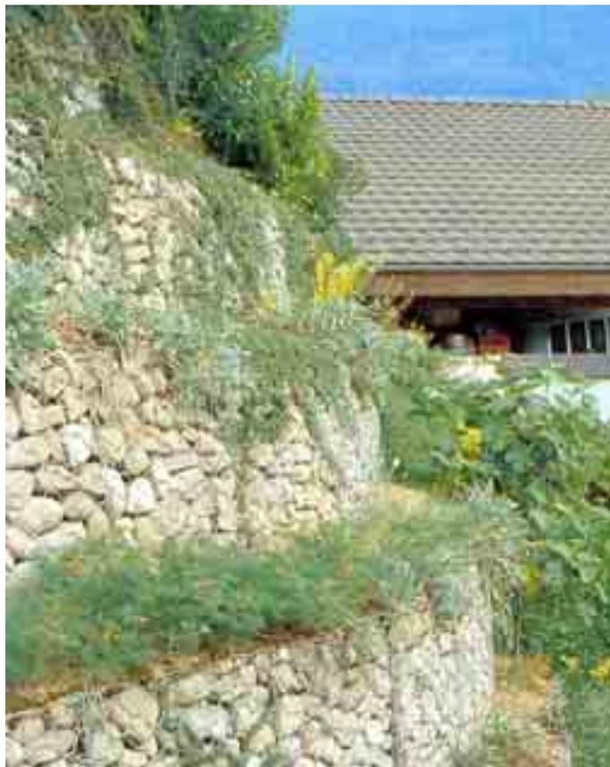
Sistemazione superficiale e consolidamento di un versante in frana mediante terrazzamenti con muri di sostegno e drenaggio in gabbioni.
