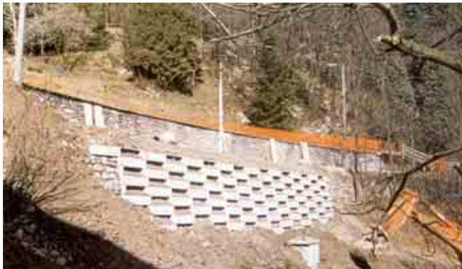
Impiego di muri cellulari come opere di protezione delle sponde dall'erosione fluviale nell'ambito degli interventi per la sistemazione idrogeologica dei versanti dissestati. In questi casi il paramento esterno è formato da elementi antiurto particolarmente rinforzati.
