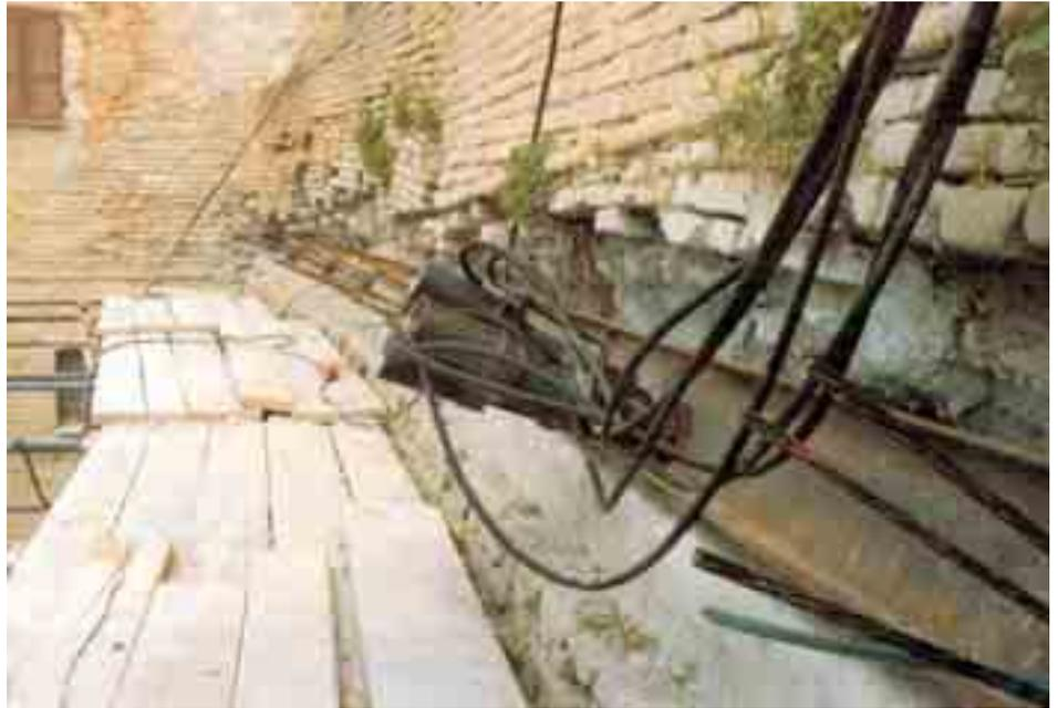
Consolidamento dei muri di sostegno all'imbocco di una galleria. L'intervento è stato realizzato con tiranti d'ancoraggio pretesi. In primo piano è mostrata la fase di installazione degli ancoraggi mediante speciali attrezzature meccaniche.
