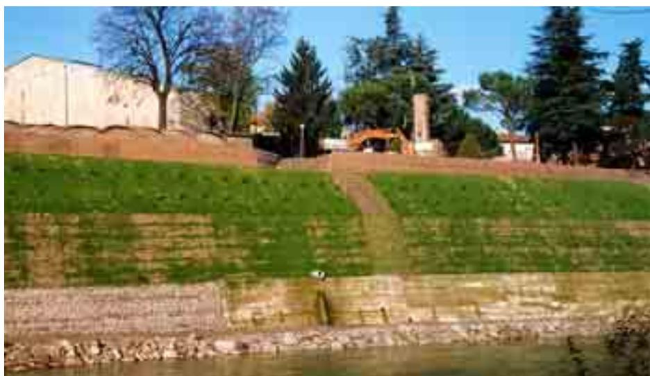
Gabbionata rinverdita realizzata come muro di contenimento. Per ottenere un miglior inserimento ambientale e favorire la rinaturalizzazione dei siti, nella struttura dei gabbioni viene inserita terra, ramaglie vive e talee di piante adatte al clima e al luogo.
