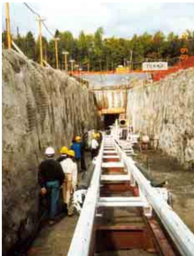
Attrezzatura per la messa in opera dello “spritz beton”
