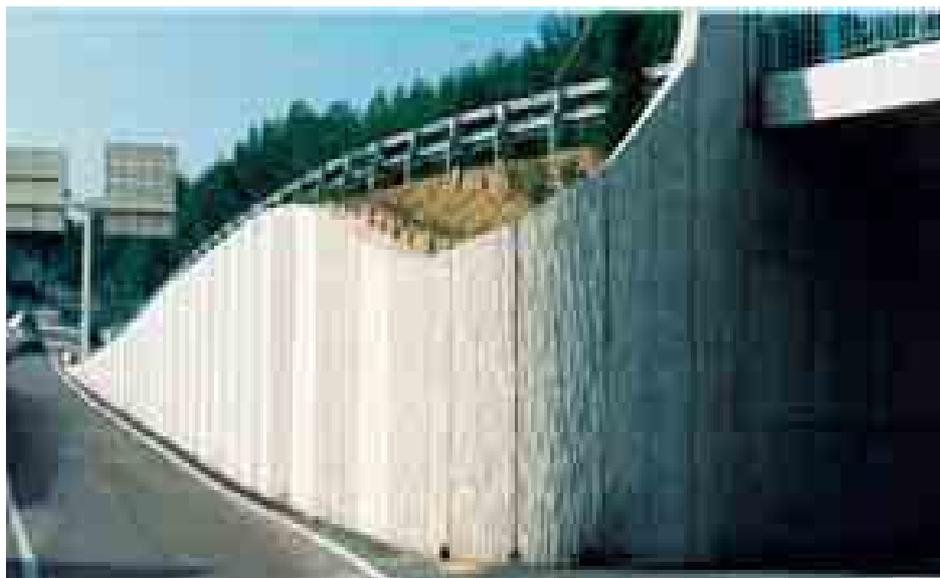
Muro di sostegno in c.a. in cui il paramento esterno in pietra sbazzata viene utilizzato come cassera di contenimento per il getto in c.l.s.
