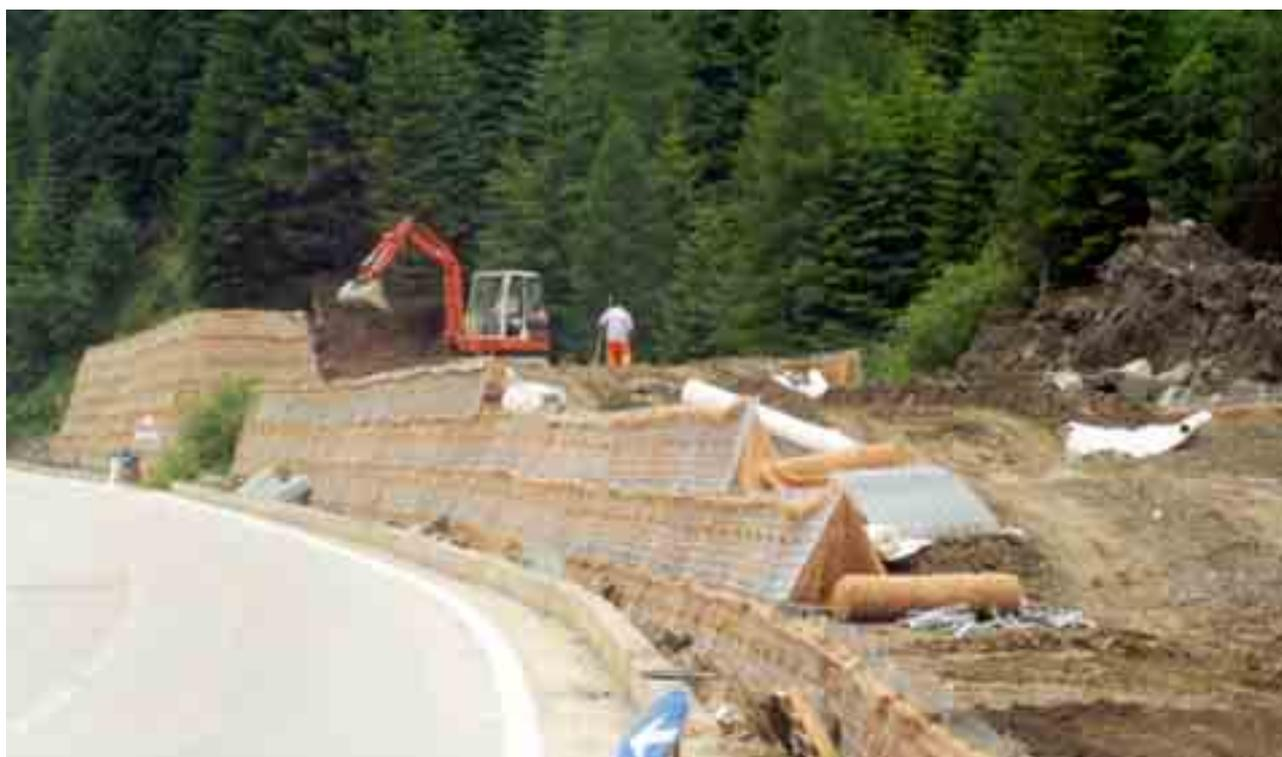
Tutti questi sistemi si basano sul principio di migliorare le caratteristiche meccaniche del terreno conferendogli resistenza a trazione. I terreni sono caratterizzati da una resistenza a compressione significativa, che dipende dalle loro caratteristiche intrinseche ed dalla loro storia tensionale, ma non possiedono resistenza a trazione.
