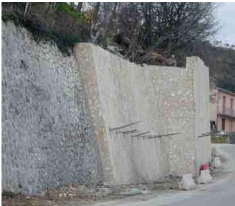
Stabilizzazione di una scarpata mediante delle piastre in cemento armato ancorate con tiranti nella parte stabile dell'ammasso roccioso.
