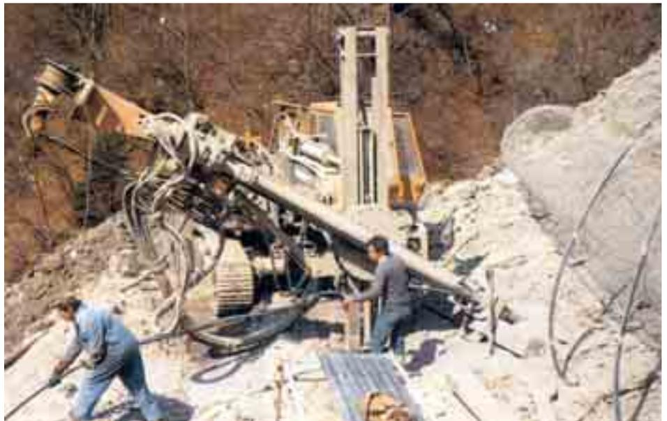
Esempio tipico di ancoraggio con cementazione del bulbo e possibilità di tesare il tirante agendo sul bullone autocentrante su piastra di ripartizione.
