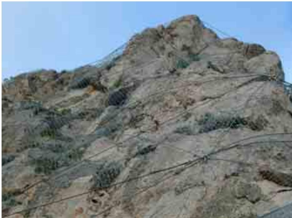
Particolare della rete metallica a maglia esagonale e delle funi d'acciaio di rinforzo.
