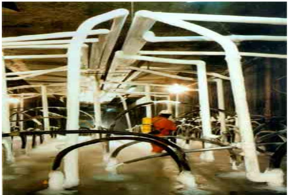
Particolare dell'impianto di congelamento utilizzato per il consolidamento preliminare dei terreni interessati dallo scavo della metropolitana di Parigi. L'impianto per la produzione del freddo è costituito da:
