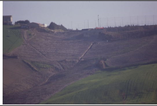
Foto fine lavori DATA Febbraio 2001
