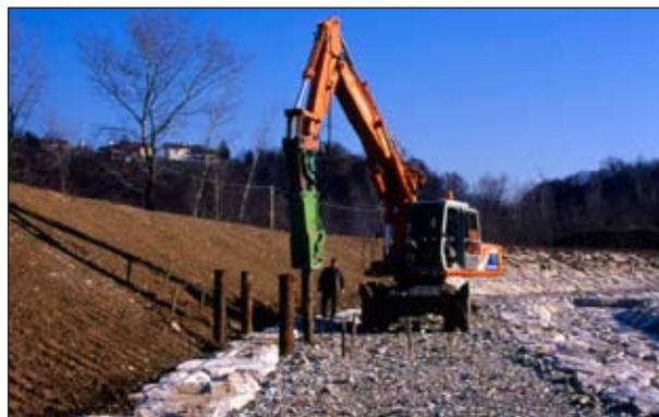
Testa battipalo applicata a scavatore meccanico gommato adibito ad infissione di tondame di grosso diametro in Repellente vivo di ramaglia a strati su sponda di canale (Foto R.Ferrari).
