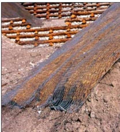
Mancata esecuzione di un adeguato raccordo tra opera e substrato e scarsa aderenza dei materiali utilizzati alla superficie morfologica: l'erosione è già in atto (Rivestimento vegetativo in rete metallica zincata e biostuoia s.l., post operam) (Foto R.Ferrari).
