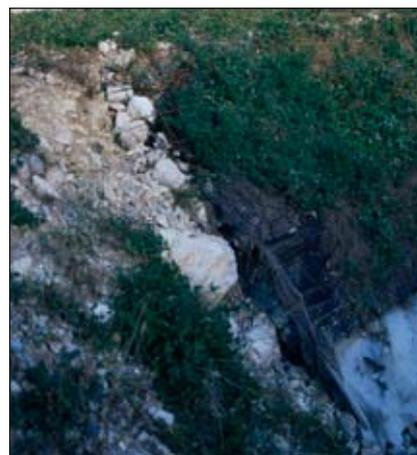
Mancata esecuzione di un adeguato raccordo tra opera e substrato: l'erosione crea scorrimenti preferenziali che tendono a svuotare la struttura (Terra rinforzata rinverditata di versante, post operam) (Foto R.Ferrari).
