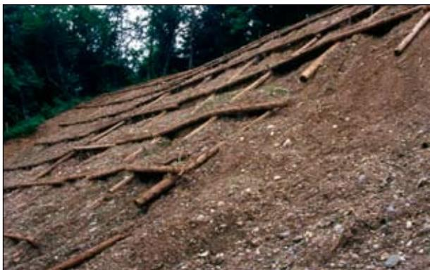
Effetti dovuti a riempimento con materiale inerte di riporto con caratteristiche geotecniche non rispondenti alla necessità, nonché fondamentale errore di sovrastima nella scelta del materiale vegetale vivo utilizzato (idrosemina) (Grata viva doppia di versante, post operam) (Foto R.Ferrari).
