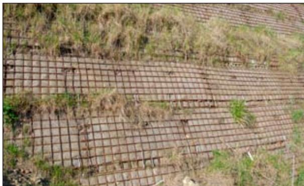
Griglia metallica in tondino di ferro ad aderenza migliorata quale elemento strutturale principale in Terra rinforzata rinverdita (Foto R.Ferrari).
