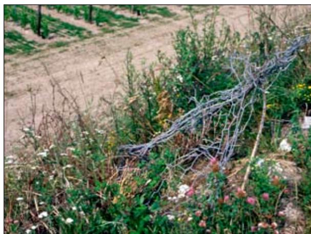
Inadeguato intervento manutentorio di sfalcatura effettuato con mezzi meccanici non idonei che rischia di compromettere l'efficacia strutturale dell'intervento (Rivestimento vegetativo in rete metallica zincata e biostuoia s.l., post operam) (Foto R.Ferrari).
