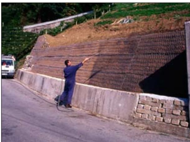
Idrosemina a completamento di un intervento su scarpata (Terra rinforzata rinverdata di versante, in opera) (Foto R.Ferrari).
