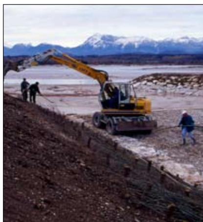
Scavatore meccanico gommato adibito a ricoprimento di Copertura diffusa con terreno vegetale (Foto R.Ferrari).
