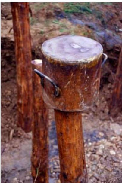
Calotta metallica di protezione testa palo posizionata su tronco di grande diametro (Foto R.Ferrari).
