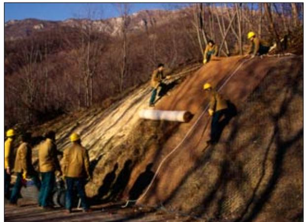
Posa di Rete metallica (Rivestimento vegetativo in rete metallica a doppia torsione zincata e biofeltro di cocco, in opera) (Foto R.Ferrari)..
