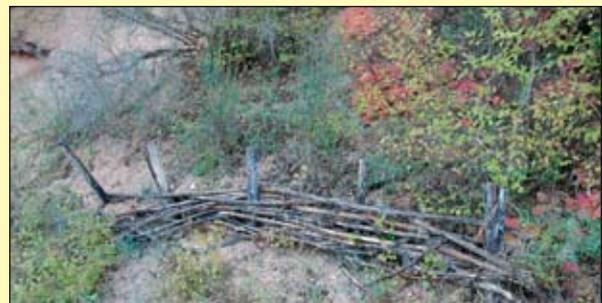
**Realizzazione con materiale vegetale morto e comunque senza gli accorgimenti particolari propri della versione "viva", Ottobre 2007: la struttura è in completo stato di degrado (Viminata s.l., post operam) (Foto R.Ferrari).**
