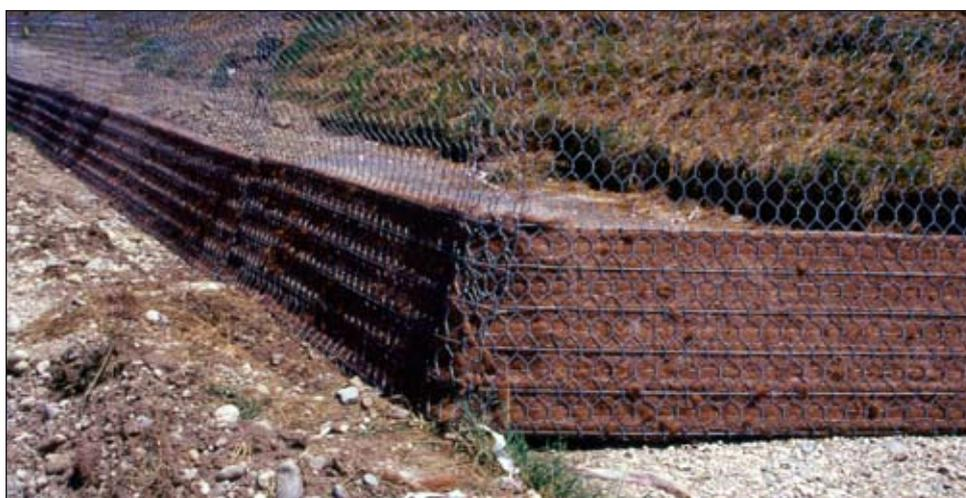
Come si presenta la tipologia durante la fase realizzativa di cantiere (Terra rinforzata rinverdata in rete metallica a doppia torsione, in opera) (Foto R.Ferrari).
