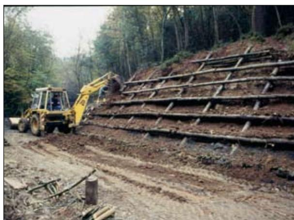
Riempimento con materiale inerte di riporto di una struttura a maglia rettangolare (Grata viva semplice di versante, in opera) (Foto R.Ferrari).
