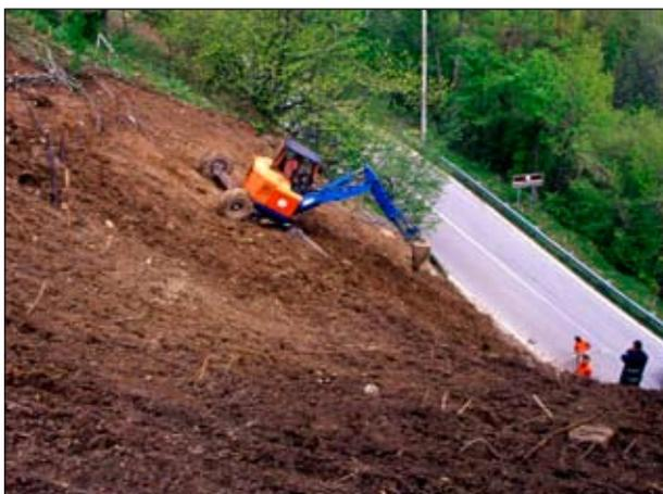
Ragno meccanico adibito a preparazione della sede di posa di Palizzata viva (Foto R.Ferrari).
