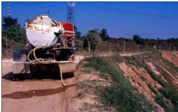
Botte per acqua montata su autocarro pesante adibita ad irrigazione in intervento di manutenzione (Foto R.Ferrari).
