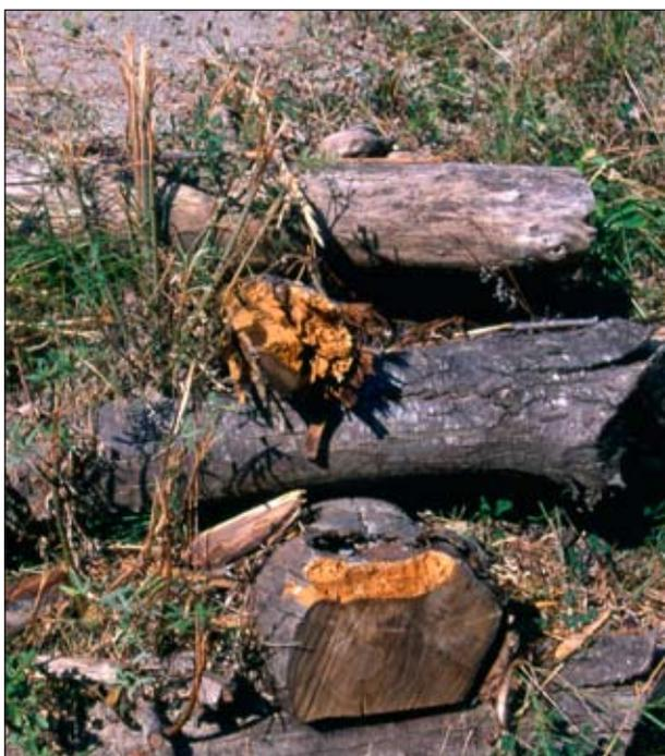
Inadeguato intervento manutentorio di potatura effettuato con mezzi meccanici non idonei che ha intaccato la struttura lignea e danneggiato irreparabilmente la componente vegetale viva (Palificata viva doppia di versante, post operam) (Foto R.Ferrari).
