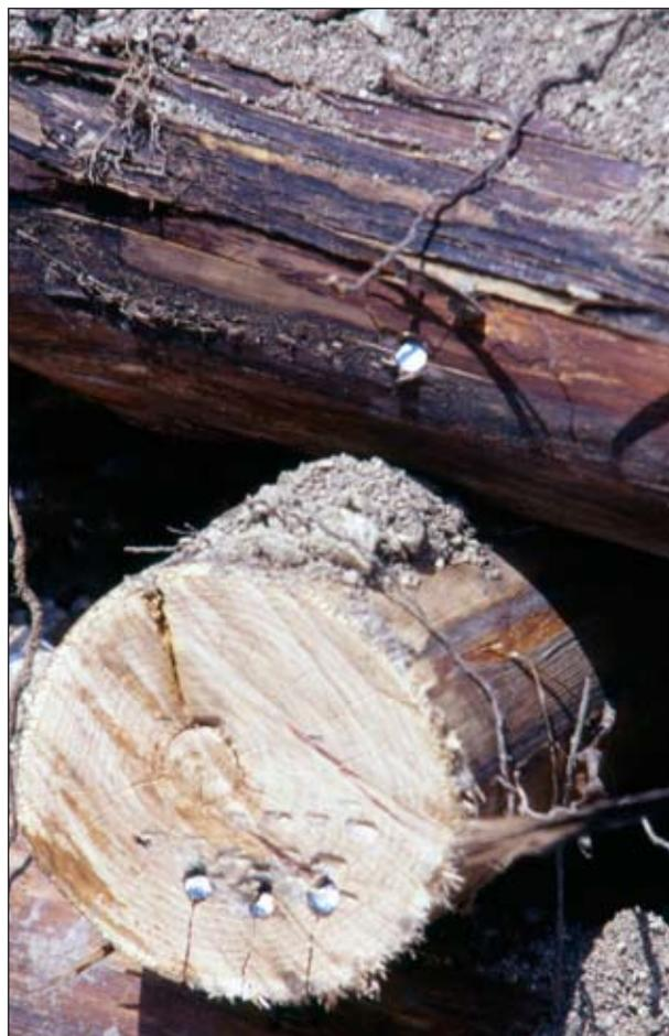
Chiodatura assolutamente inadeguata sia tipologicamente sia dimensionalmente (Palificata viva doppia, post operam) (Foto R.Ferrari).
