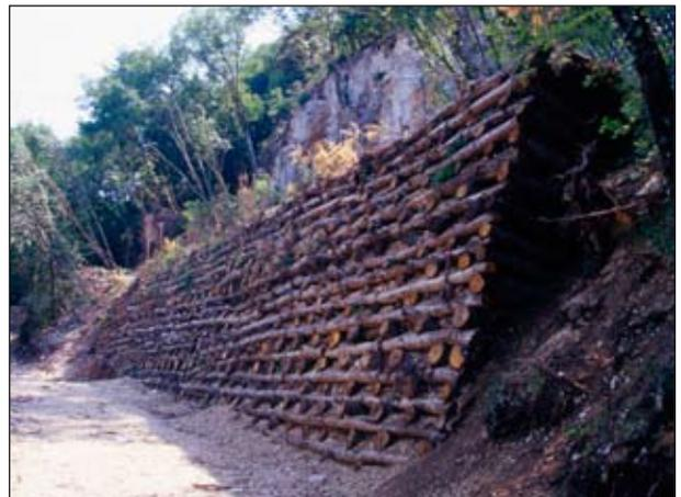
Inclinazione e rapporto altezza/profondità molto superiori agli standard della tipologia, mancato adeguato raccordo tra struttura e substrato, totale mancanza della componente vegetale viva: a rischio la stabilità totale dell'intervento a monte (Palificata ?viva doppia, post operam) (Foto R.Ferrari).
