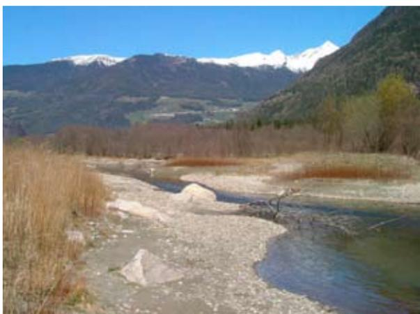
Realizzazione di aree inondabili in corrispondenza dell'alveo, ampliando le sezioni idrauliche con la creazione di un alveo di magra con portata idraulica ed uno di piena allagato periodicamente.
