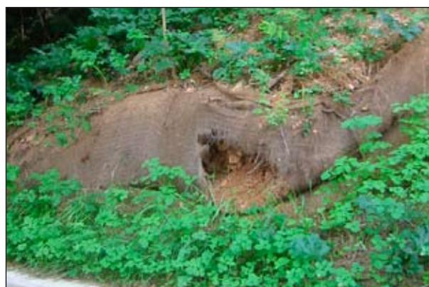
**Errore tecnico:** uso di biostuoie biodegradabili ove era necessaria un'opera di sostegno viva in legno (Foto P.Cornelini)
