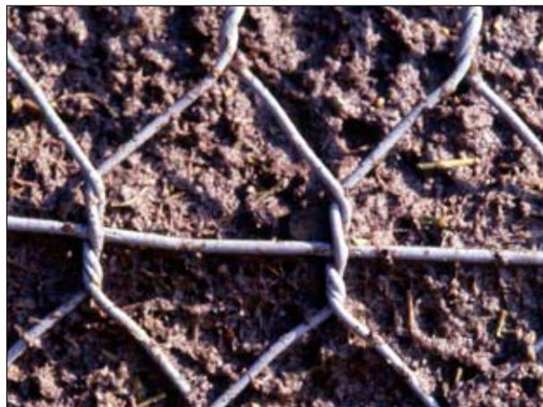
Idrosemina a spessore, particolare (Terra rinforzata di versante, in opera) (Foto R.Ferrari).
