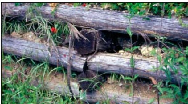
Errata sovrapposizione di tronchi trasversali e relative chiodature nella zona di contatto tra due tronchi longitudinali (correnti), peraltro privi di incastro, e relative chiodature; inoltre errata sovrapposizione di tronchi trasversali senza sfalsatura rispetto a quelli degli ordini precedenti ed inadeguata inclinazione (prossima alla verticale) della parete esterna (Palificata viva doppia, post operam) (Foto R.Ferrari).
