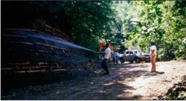
Irrigazione dell'area di intervento ultimata la fase realizzativa, mediante pompaggio da botte (Palificata viva doppia di versante e Grata viva semplice di versante, in opera) (Foto R.Ferrari).
