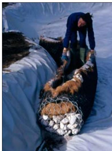
Un'occasione per sperimentare materiali nuovi o insoliti (Rullo spondale in rete metallica zincata e plastificata con georete e biofeltro in cocco, in opera) (Foto R.Ferrari).
