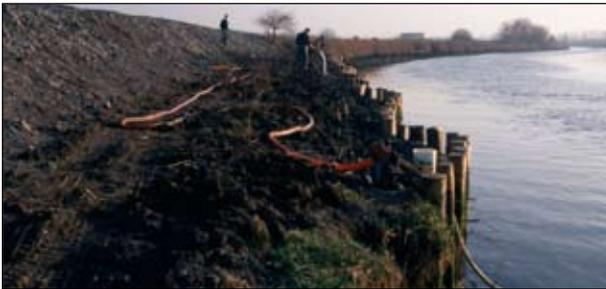
Irrigazione dell'area di intervento ultimata la fase realizzativa, mediante pompaggio diretto dal corso d'acqua (Rullo spondale in fibra di cocco, in opera) (Foto R.Ferrari).
