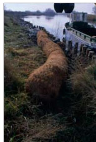
Rullo in fibre di cocco contenuto da georete (Foto R.Ferrari).
