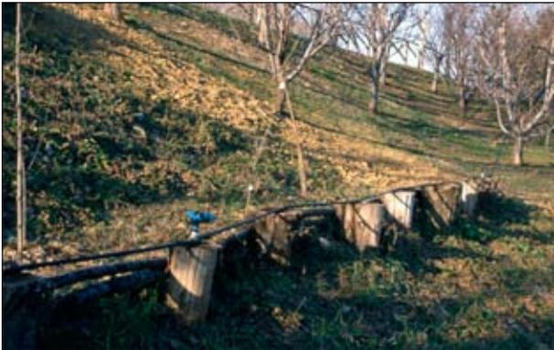
Impianto di irrigazione di soccorso preinstallato (Palizzata viva, post operam) (Foto R.Ferrari).
