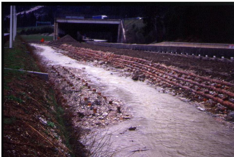
Repellente vivo con funzione di meandrizzazione in alveo di magra. Rinaturalizzazione tratto precedentemente canalizzato e cementato, Fiume Fella (UD) - Foto G. Sauli
