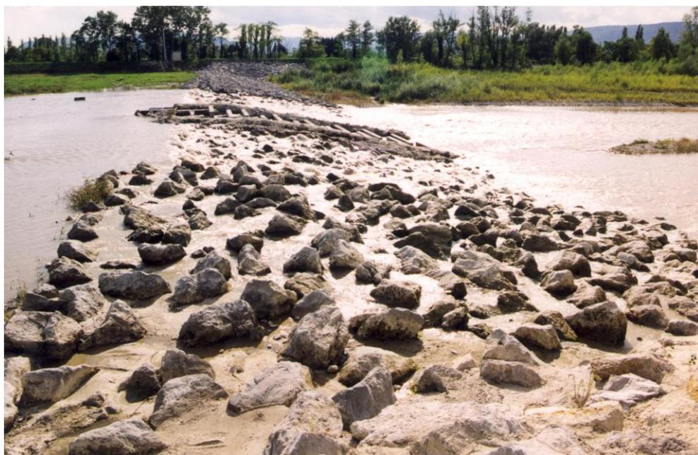
Rampa a blocchi in massi cementati e scale di rimonta per ittiofauna, affluente F. Rodano (Francia) - Foto G. Sauli
