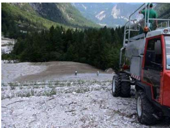
Foto 573: distribuzione di fiorume e messa a dimora di arbusti autoctoni al piede della scarpata (Foto Snamretegas 2005)
