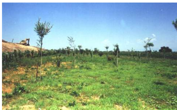
Foto 534 – Fascia boscata tampone perimetrale alla discarica di RSU di Trivignano (UD) - Foto: G. Sauli, 2003
