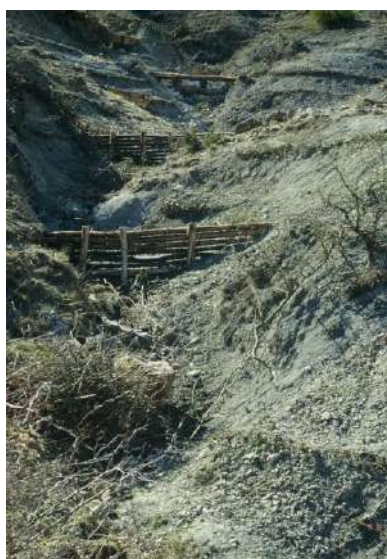
Foto 2 e 3: Opere trasversali sui fossi in erosione : palizzate in legno con ramaglia a fine lavori e dopo 3 anni - D. Dallari
