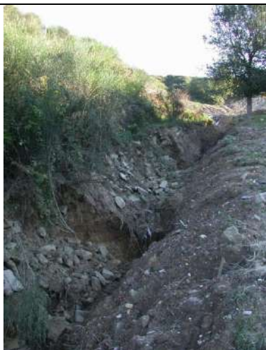
FOTO 5 e 6: Fenomeni distruttivi delle opere in via di realizzazione in conseguenza di eventi meteorici eccezionali - D. Dallari
