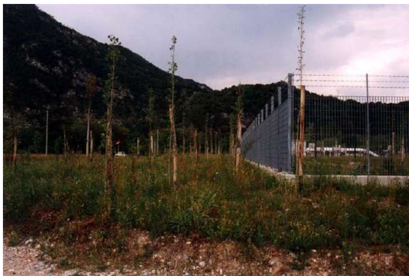
Foto 617: Fascia boscata perimetrale Stazione pompaggio Bordano (UD) - Foto G. Sauli, 2003
