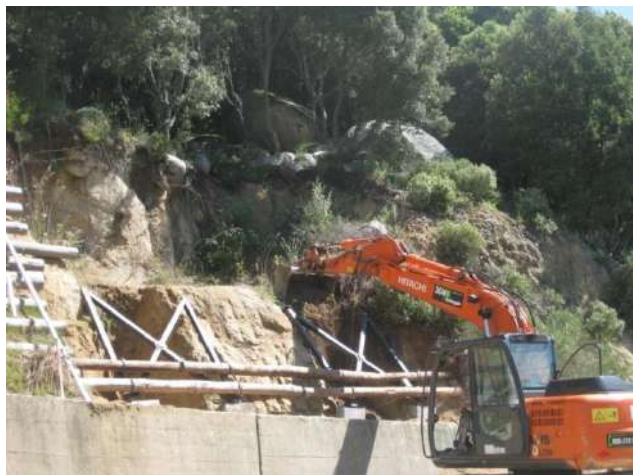
Foto 700: Palificata loricata Nuoro2010 durante i lavori Foto M. Di Pietro
