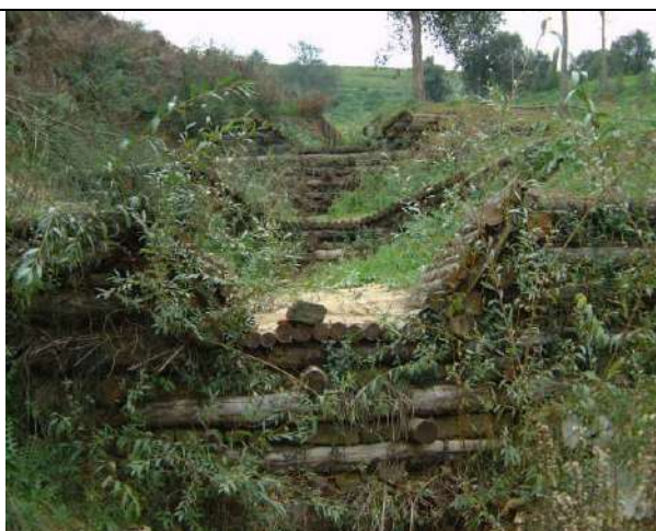
Foto 11: Briglie in legno e pietrame, con inserimento di salici e piantine radicate subito dopo la realizzazione e dopo 8 mesi - D. Dallari
