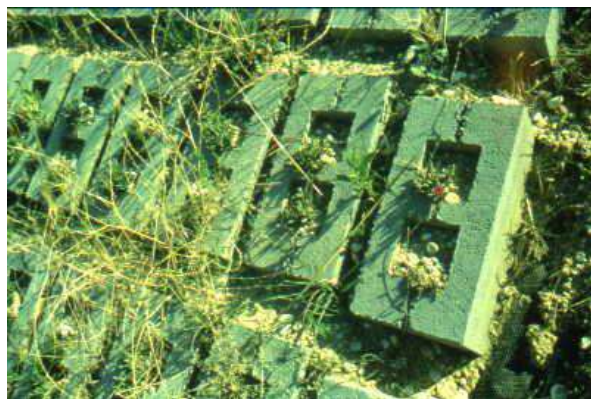
Foto 459 - Scarpate in scavo su substrato sabbioso stabilizzate con mattonelle in cls poggiate su geotessili e rivegetate con piantine di Mesembrianthemum. Dopo quasi 20 anni non c'è traccia di queste piante mentre si è affermata Inula viscosa cresciuta spontaneamente (3° corsia Fiano-Orte c/o svincolo di Orte – Foto G. Sauli)
