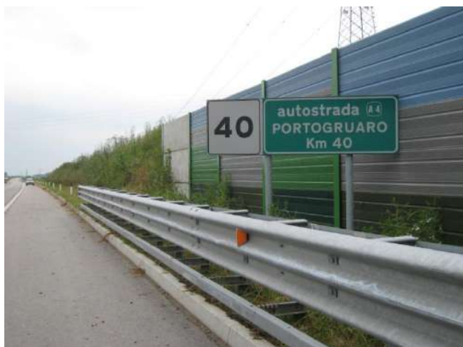
Foto 486 – Terrapieno vegetato antirumore (Autostrada A28 - 2010). Foto G. Sauli
