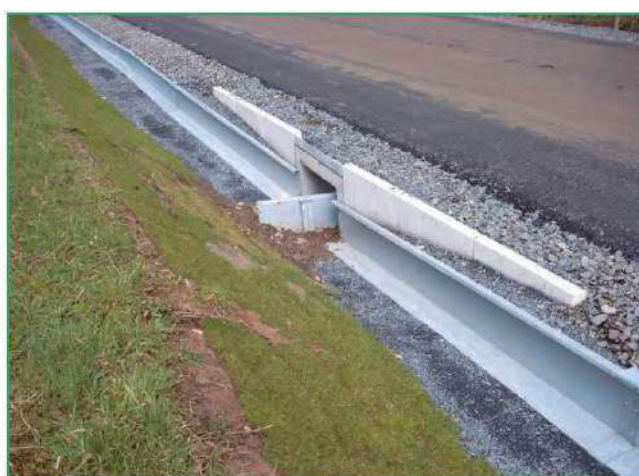
Foto 520 - Strutture metalliche di svio per anfibii collegate con diaframmi direzionali e sottopassi (Germania). Foto G. Sauli
