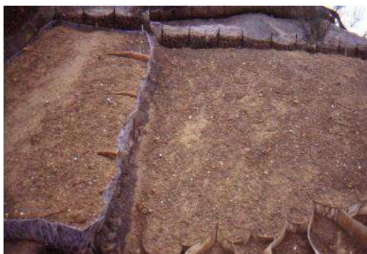
Foto 405: Rivegetazione versanti rocciosi, diga di Ridracoli, geocelle a nido d'ape – fase di riempimento con terra vegetale Foto: G. Sauli
