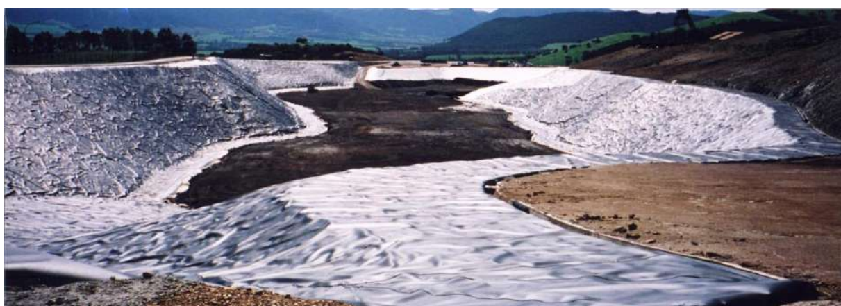
Foto 540 - Preparazione della sigillatura di fondo della discarica di fanghi industriali di Gennaluas (CA), su un rimodellamento morfologico della vecchia miniera di pirite. Foto: G. Sauli
