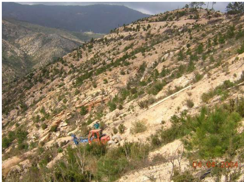
Foto 352: Situazione della copertura vegetazionale, a 6 anni dall'evento Loc. Voze, bacino Rio Crovetto, Noli (SV) - U. Bruschini
