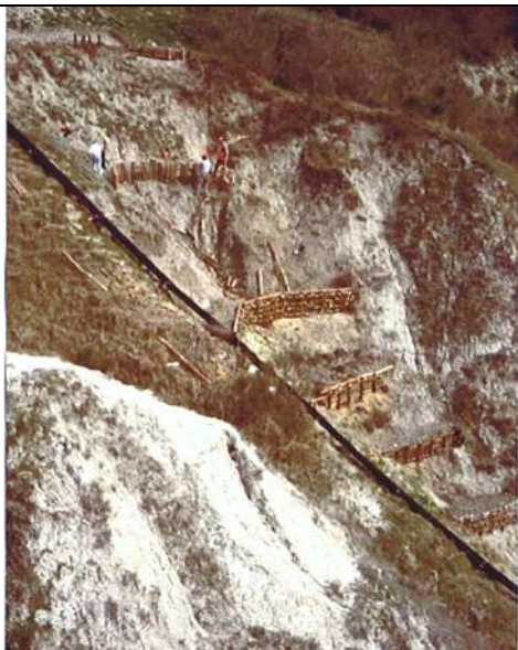
Foto 3: Impluvio secondario. Interventi di rialzamento del fondo, Febbraio 1999. - Bernabei, Mazzoni, Pei
