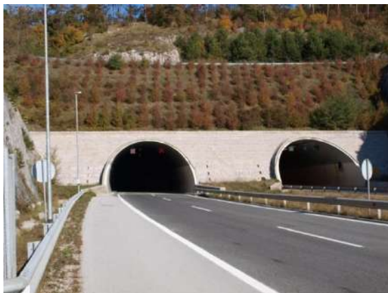
Foto 4212 - Soluzioni intermedie sono talvolta necessarie per morfologie locali (autostrada in Slovenia loc. Sezana – Foto G. Sauli)
