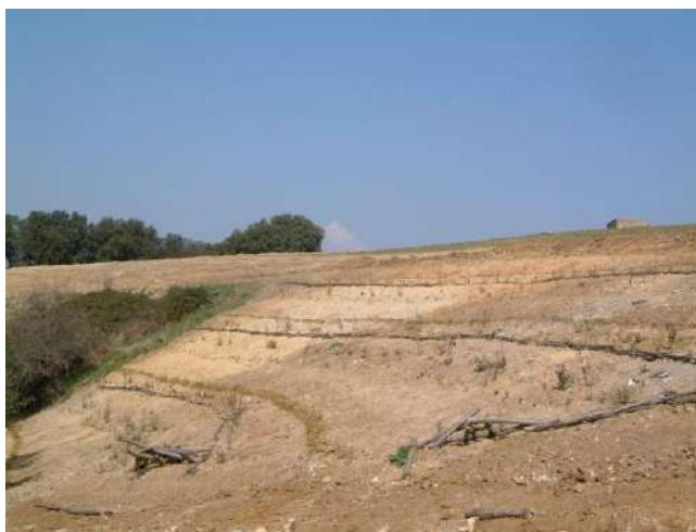
FOTO 7: Interventi alternati con gradonata, viminata e fascinata a protezione del pendio - D. Dallari
