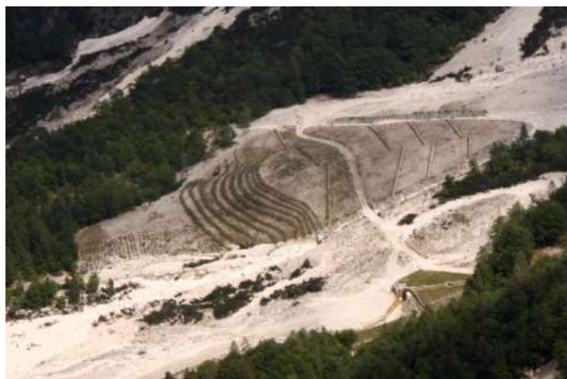
Foto 575: Metanodotto Malborghetto – Bordano (UD) Loc. Val di Gleris , Cordonate vive – Foto G. Sauli 2006 Foto 576: Situazione a giugno 2014
