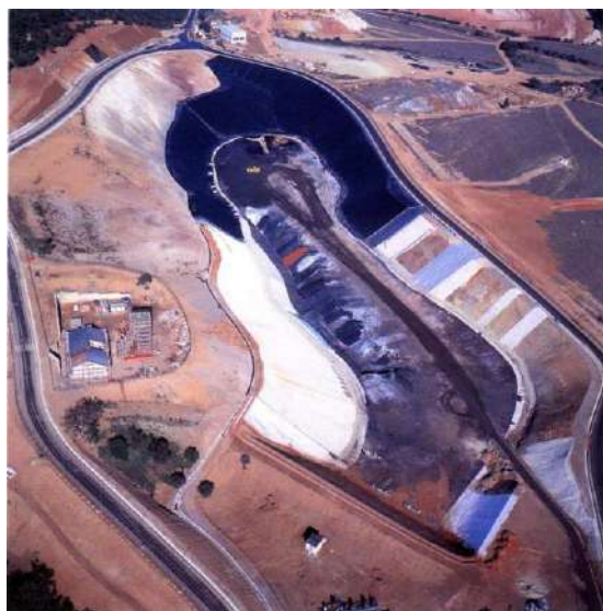
Foto 539 - Preparazione della sigillatura di fondo della discarica di fanghi industriali di Gennaluas (CA), su un rimodellamento morfologico della vecchia miniera di pirite. Foto Ecos
