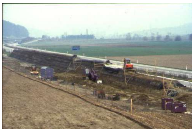
Foto 487 – Barriera antirumore in terra rinforzata verde in rete sintetica con talee di salice (Svizzera anni '80). Foto G. Sauli
