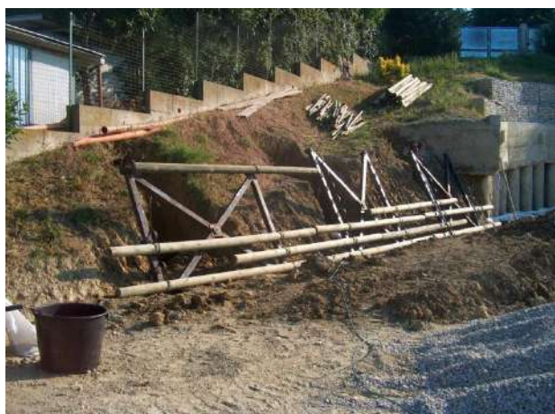
Foto 698: Palificata loricata Roseto degli Abruzzi 2010 durante i lavori Foto C. Crocetti
