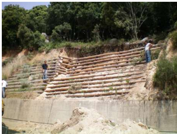
Foto 701: Palificata loricata Nuoro2010 a fine lavori prima della piantagione arbusti Foto M. Di Pietro
