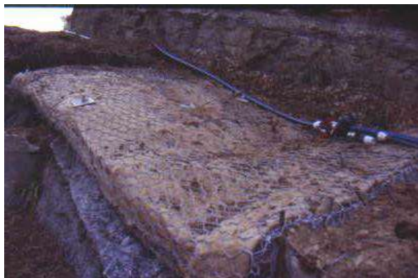
Foto 407: Rivegetazione versanti rocciosi, diga di Ridracoli, materasso verde, Foto: G. Sauli
