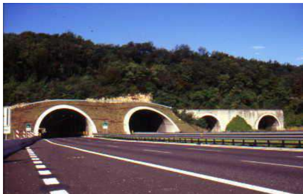
Foto 420 - a destra vecchio portale in cls, a sin nuova tipologia rivegetabile con semine e viminate. (Foto G. Sauli)
