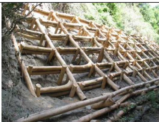
Foto 2: Palificata doppia con grata Vesuvio sec. Menegazzi con arbusti radicati; fase di costruzione (luglio 2003) - G. Menegazzi
