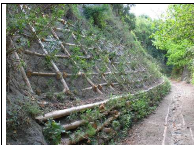
Foto 3: Palificata doppia con grata Vesuvio sec. Menegazzi con arbusti radicati; fine lavori settembre 2003 Monte Somma - G. Menegazzi
