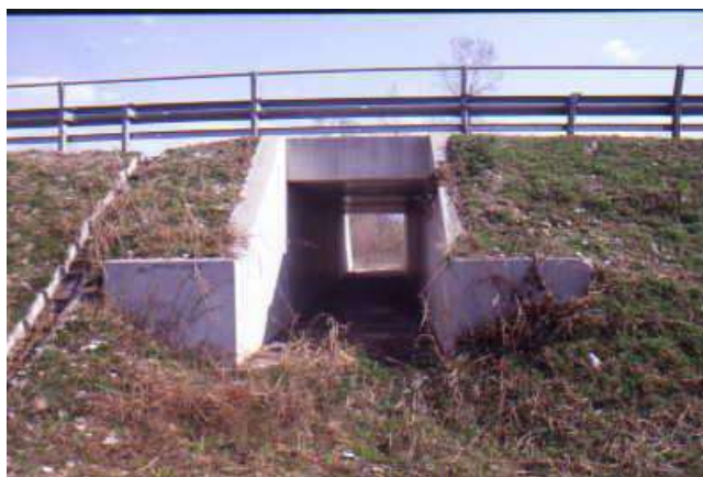
Foto 515 – Sottopasso scatolare per fauna minore (Collegamento Cimpello – Sequals – PN – Foto G. Sauli)
