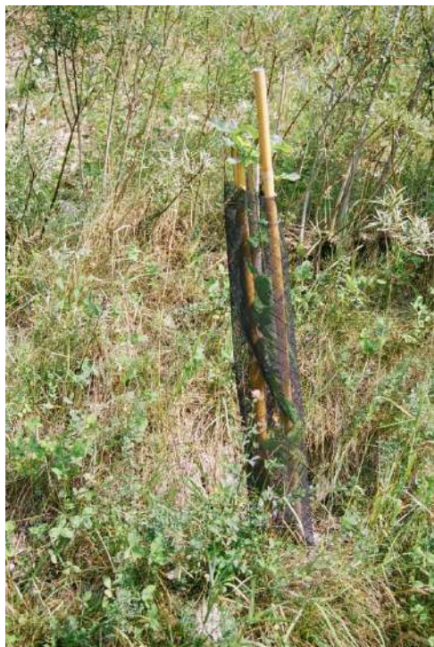
Foto 586: Metanodotto Malborghetto – Bordano (UD) Loc. Pontebba. messa a dimora di arbusti tra le file di gradonate – Foto G. Sauli Agosto 2006
