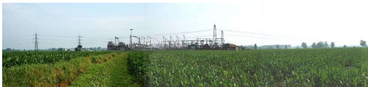
Foto 622: SE di Maleo (LO) Simulazione fotografica della costruzione della sola stazione
