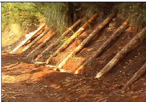
Foto 2: Posa in opera dei tronchi verticali
