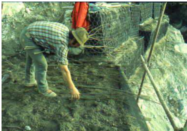
Foto 394: Rivegetazione e consolidamento al piede dei rilevati mediante gabbionate e terre rinforzate verdi su scavi e gradoni, Miniera di Giustino (TN) Foto: G. Sauli
