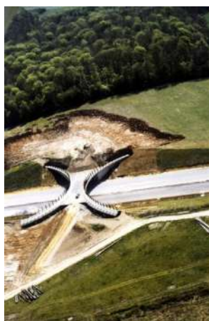
Foto 513 – Ponte per ungulati con strutture di invito ad imbuto (Lussemburgo anni '80). Foto G. Sauli
