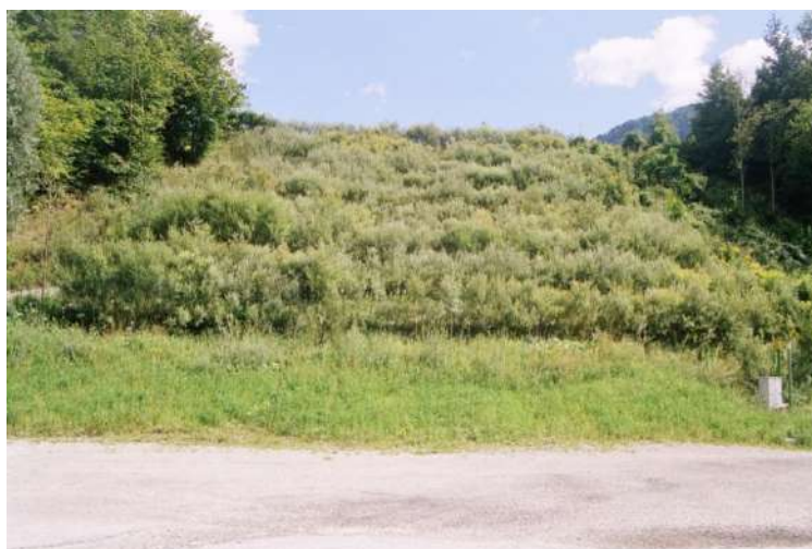
Foto 587: Metanodotto Malborghetto – Bordano (UD) Loc. Pontebba. Gradonate vive con canaletta e messa a dimora di arbusti. Ottime risultanze funzionali e naturalistiche, agosto 2006 – Foto G. Sauli
