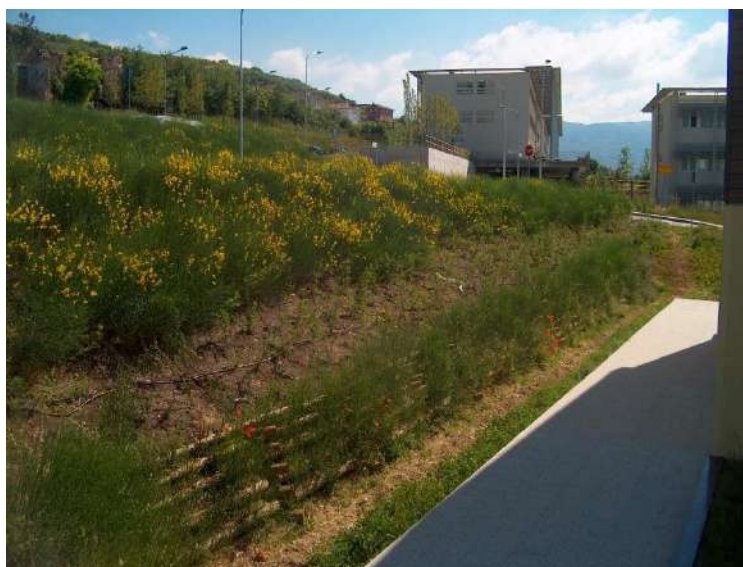
Foto 685: Palificata latina L'Aquila dopo un anno Foto C. Crocetti 2010
