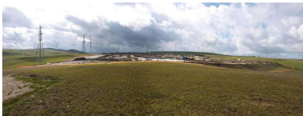
Foto 637: SE di Bisaccia (AV) in costruzione. Panoramica da nord con ampie scarpate in rilevato a valle. (Foto G. Sauli, febbraio 2010)
