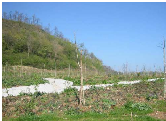
Foto 448 - Rivegetazione area boscata rilevato galleria Pileggi (3ª corsia Autostrada Orte-Fiano fine anni '90). Visibile un fosso di guardia realizzato in cls. (Foto P. Cornellini)
