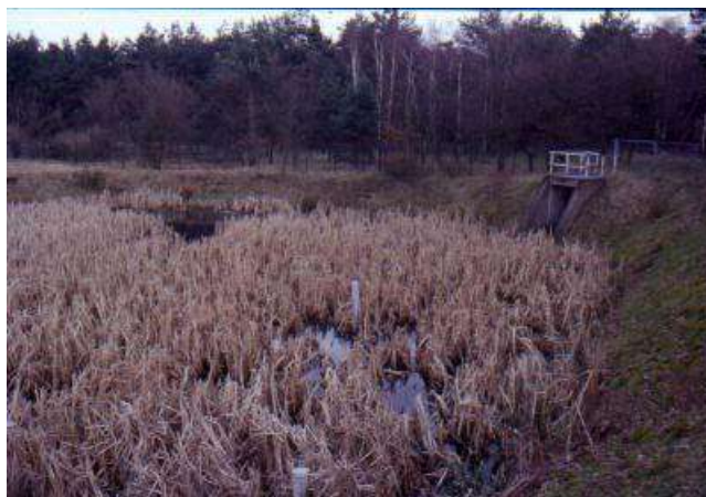
Foto 506 – Vasca di prima pioggia con funzione di habitat umido e fitodepurazione (Germania – Foto G. Sauli)
