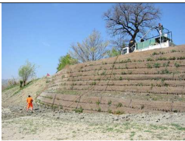
Foto 4: Idrosemina potenziata sulle terra rinforzata rinverdita (marzo 2002) - P. Cornellini
