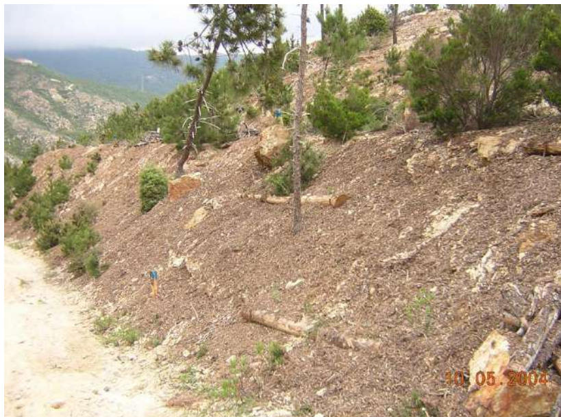
Foto 354: Copertura di terreno percorso dal fuoco con chips legnosi e compost, abbinato a palizzate vive in legname – loc. Voze, Noli (SV) - Foto U.Bruschini
