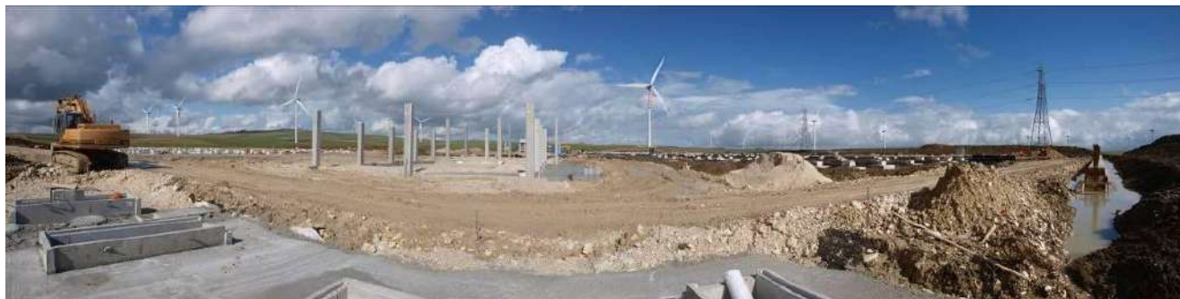
Foto 638: SE di Bisaccia (AV) in costruzione. Panoramica dell'intera area di cantiere. (Foto G. Sauli, febbraio 2010)
