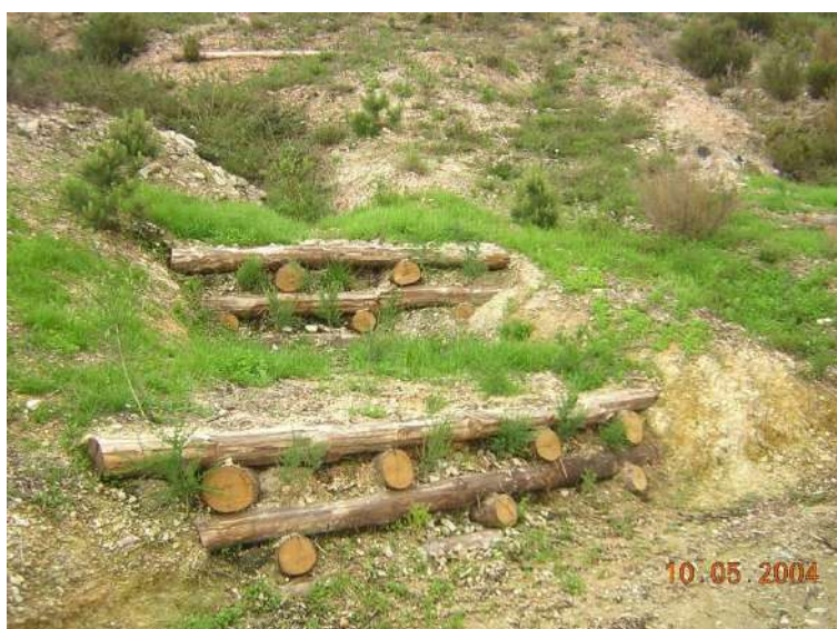
Foto 355: Avvio dei processi di ricostituzione della vegetazione, a 30 giorni dalla semina e dalla ripresa vegetativa degli arbusti posti a dimora nelle palificate in legname loc. Tosse, Spotorno (SV) - Foto U. Bruschini
