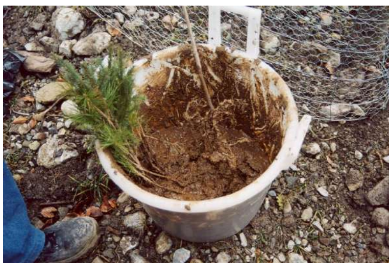
Foto 583: Metanodotto Malborghetto – Bordano (UD) Loc. canale Cialatta. Inzaffardatura piante a radice nuda. 21.11.’03 – Foto G. Sauli
