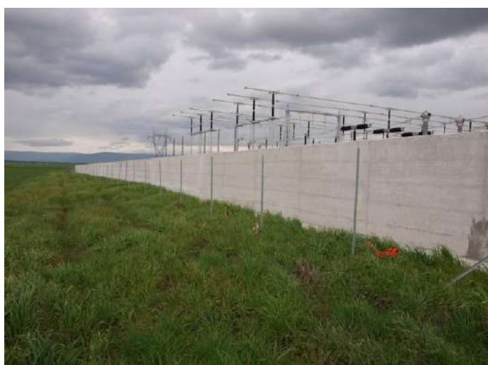
Foto 620: SE di S. Severo (FG) a servizio della Centrale a turbogas in costruzione, muro recinzione in cls, antincendio ed antiintrusione, febbraio 2010. (Foto G. Sauli)
