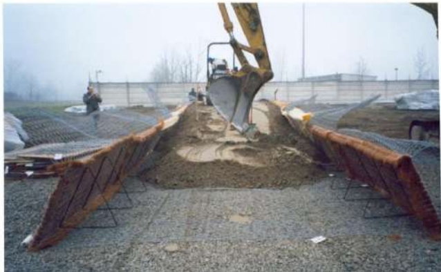
Foto 497 – Barriera antisvio in doppia terra rinforzata verde in fase di costruzione (Foto F. Ferraiolo)
