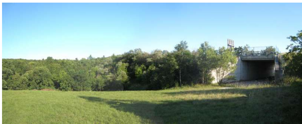
Foto 514 – Sottopasso per uso faunistico (GVT loc. Slivia – Foto G. Sauli 2009)
