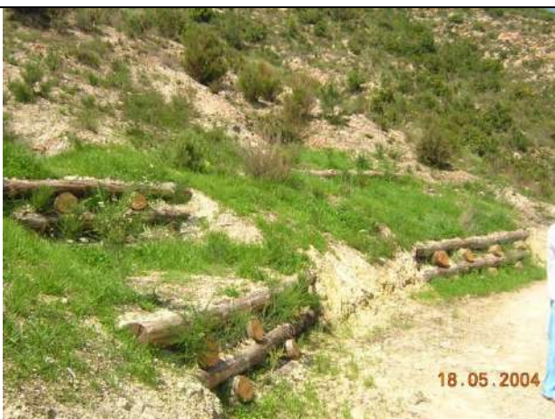
Foto 6: Sistemazione di piccoli solchi di erosione con brevi tratti di palificate a doppia parete, a circa 30-40 giorni dalla ripresa vegetativa – maggio 2004 - U. Bruschini
