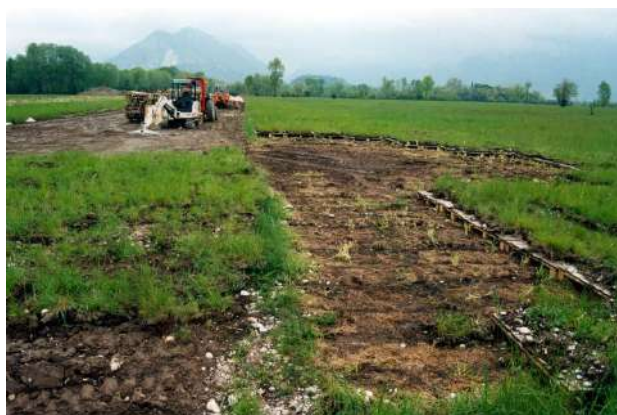
Foto 593: Metanodotto Bordano – Flaibano Loc. Piani di Osoppo; trapianti in zolla, rimessa in pristino delle zolle – Foto G. Sauli 2004
