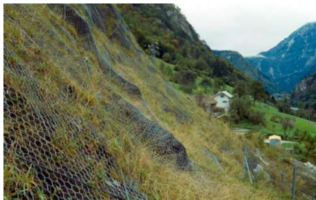
Foto 465 - Rivestimento vegetativo in geostuoia tridimensionale e rete zincata inerbata su scarpate in scavo in litologia sciolta su detrito di falda (Autostrada Carnia -Tarvisio – Foto G. Sauli ottobre 1987)
