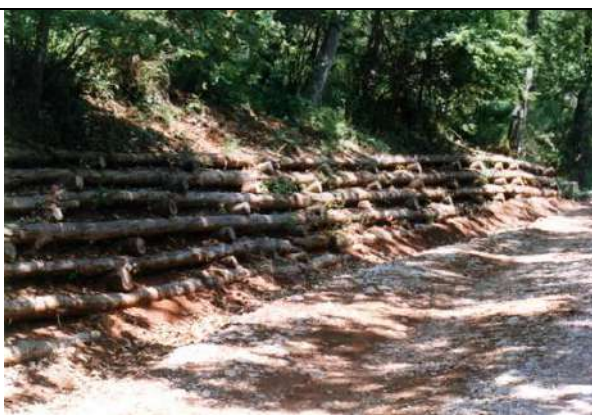
Foto 6: Palificata viva semplice a 3 mesi dalla realizzazione, Spigno Saturnia (LT) - giugno 2003
