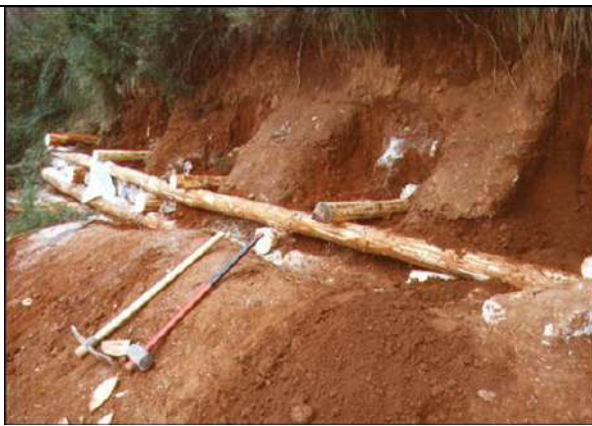
Foto 2: Posa in opera dei primi tronchi
