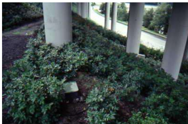
Foto 502 – Impiego delle acque di sgrondo mediante tubi diffusori per rivegetazione ad edera (Grande Viabilità di Trieste – Via Caboto) gennaio 2010. Foto G. Sauli
