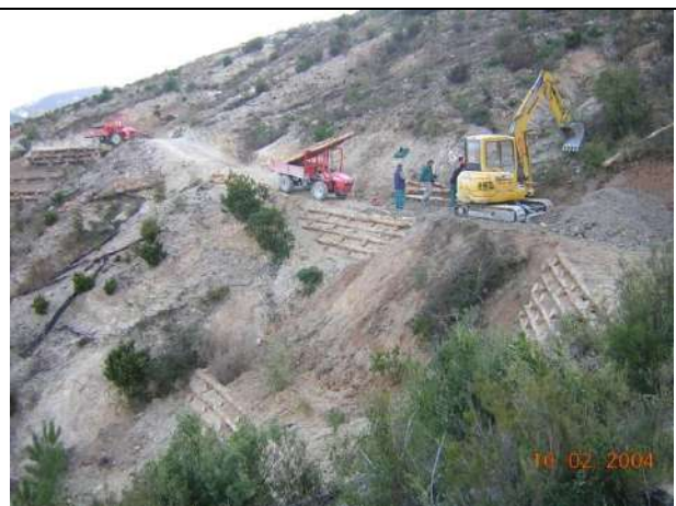
Foto 5: Impiego di mezzi meccanici leggeri per la realizzazione di opere di I.N., a margine di viabilità di servizio – febbraio 2004 - U. Bruschini
