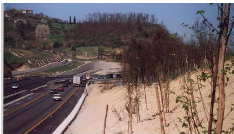
Foto 438 - Autostrada Fiano –Orte – Scarpate in trincea in argilla minerale – Piantazione di arbusti ed alberi (Foto G. Sauli 1998)
