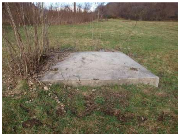
Foto 669: Operazioni di demolizione di tralicci in aree a prato; Borgomanero (NO). (Foto G. Sauli, dicembre 2009)
