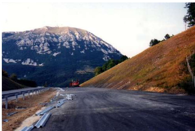
Foto 416 - Scarpata in trincea in roccia lavorata a bassa pendenza e a tirata unica senza berme intermedie. Autostrada Capodistria-Lubiana, Località Razdrto (Slovenia). Foto G. Sauli
