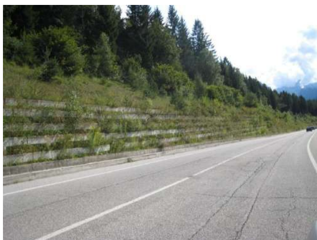
Foto 481 - Muro cellulare in cls con arbusti autoctoni (Strada per la nuova Stazione di Tarvisio Bosco Verde – Foto G. Sauli 2009)
