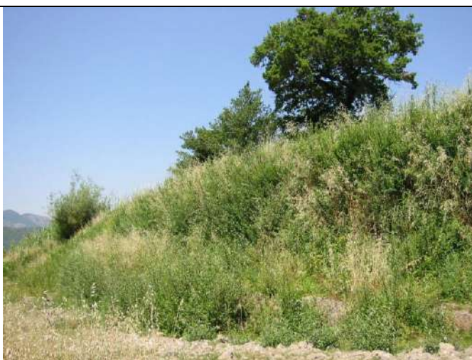
Foto 5: La terra rinforzata rinverdita a giugno 2003 - P. Cornellini
