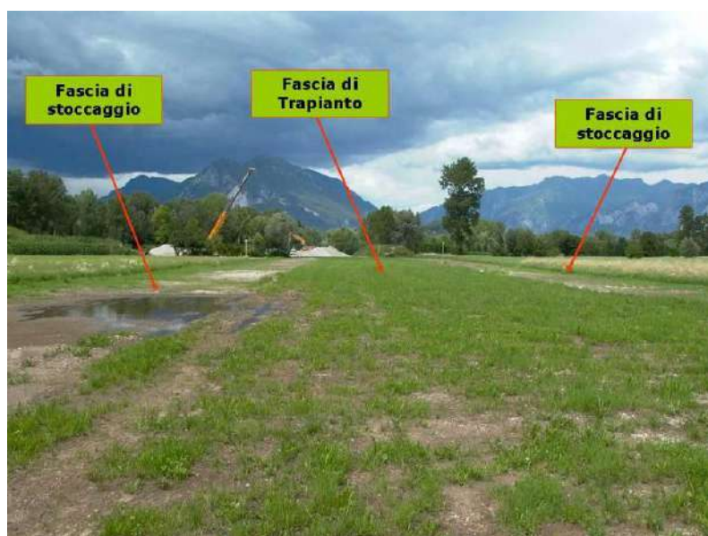
597: Pista di lavoro ripristinata dopo 3 mesi (luglio 2004) – Foto Snamretegas
