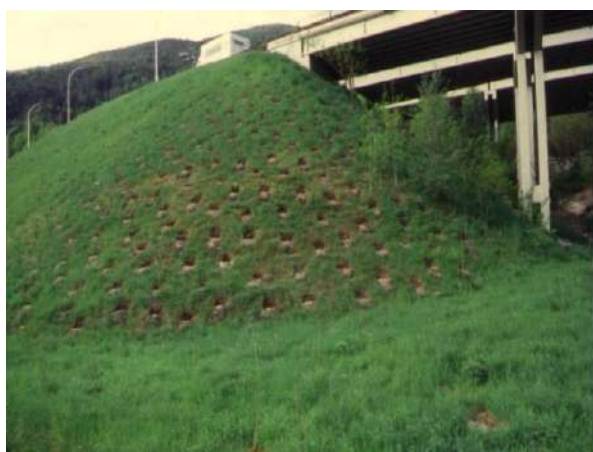
Foto 418 -Rivegetazione ad arbusti di un rilevato spalla di viadotto (Autobrennero – Bolzano nord – Foto G. Sauli)
