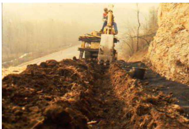
Foto 441 - Fosso di guardia in geostuoia tridimensionale sintetica seminata, intasata di ghiaino e bitumata in loco (27 ÷ 30) Autostrada dei Trafori anni '80 – Foto G. Sauli)
