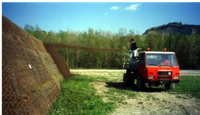
Foto 497 – Barriera antisvio in doppia terra rinforzata verde in fase di costruzione (Foto F. Ferraiolo)
