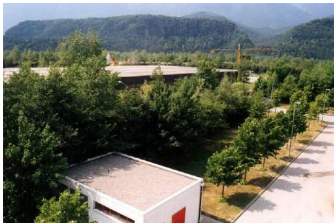
Foto 631: Effetto di mascheramento di impianto industriale mediante terrapieno vegetato in località Tolmezzo UD. (Foto G. Sauli, giugno 2003)
