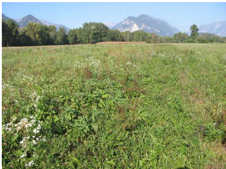
Foto 600: Metanodotto Bordano – Flaibano (UD) Pista ripristinata mediante trapianto zolle erbose. Presenza di infestanti sul vecchio tracciato. Foto G. Sauli, 2004
