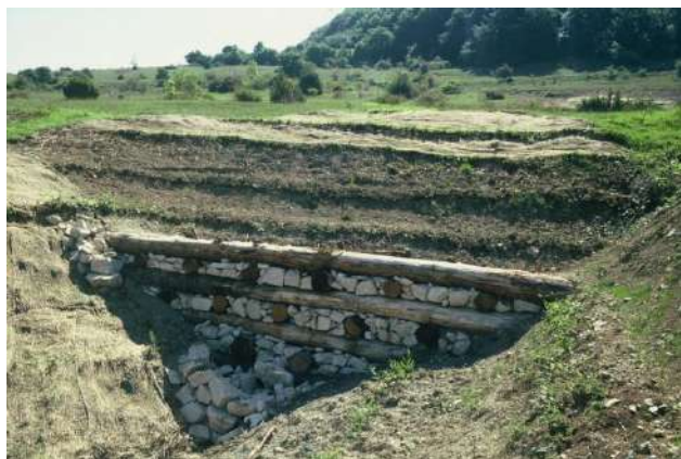
Foto 6 e 7: Opere combinate di consolidamento tipo palificate doppie in legno e pietrame con gradonate rinforzate protette con semina su coltre di paglia tenuta con juta: a fine lavori e dopo 4 anni – D. Dallari
