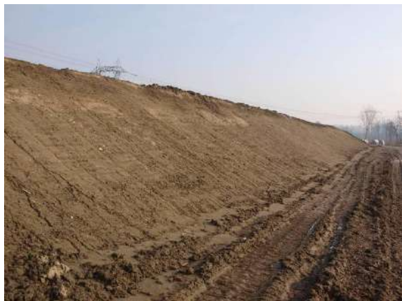
Foto 624: Nuova S.E. di Maleo (LO). Formazione di rilevati di mascheramento con utilizzo dei materiali di scotico misti a inerte di cava. (Foto G. Sauli, inverno 2011)
