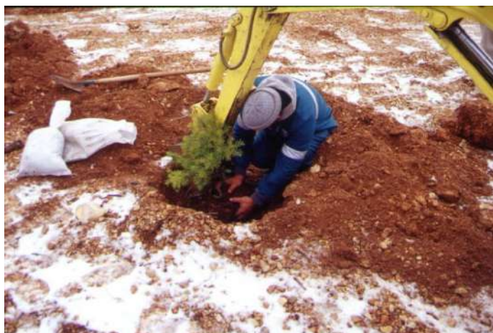
Foto 606: Metanodotto Bernalda – Brindisi, Loc. Massafra, lavori di trapianto di arbusti di gariga mediterranea (dicembre 2001) – Foto G. Sauli
