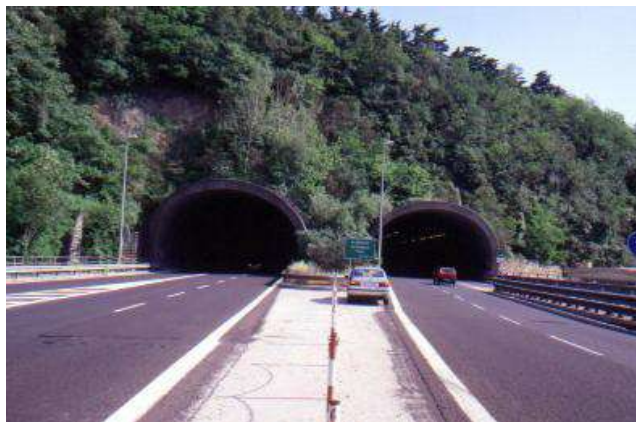
Foto 425 - GVT Galleria di Servola (TS) – dopo 10 anni (Foto G. Sauli)
