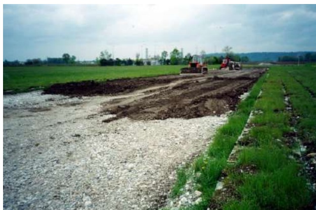
Foto 591: Metanodotto Bordano – Flaibano Loc. Piani di Osoppo; trapianti in zolla con zolle poste a strato singolo su pallet con foglio di polietilene; spessore medio zolle 10 cm, preparazione fondo con stesura terreno rimosso in precedenza – Foto G. Sauli 2004
