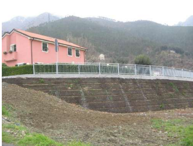
Foto 476 - TRV in reti sintetiche rinverdate (Foto G.P. Pinzani 2009)
