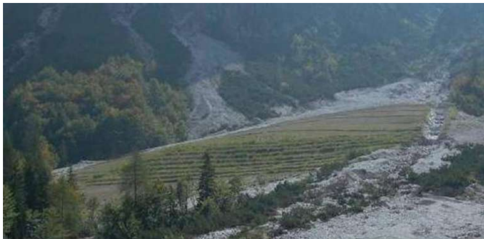
Foto 577: Interventi con cordonate vive sulle scarpate del deposito dopo quattro anni (Foto Snamretegas 2009)
