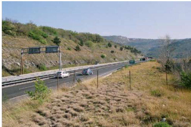
Foto 463 - Scarpate in rocce marnoso-arenacee rivestite con sola rete metallica. Lo sviluppo spontaneo della vegetazione è legato alla presenza di piccole berme su cui si è accumulato materiale terroso fine. (GVT svincolo Grandi motori – TS – Foto G. Sauli 2010).
