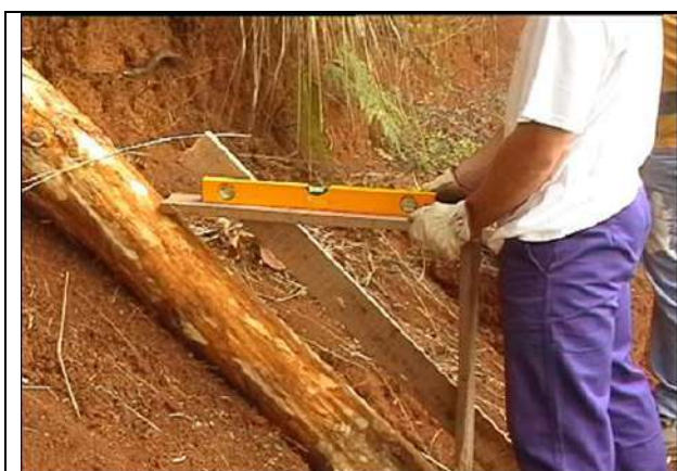
Foto 3: Verifica del corretto posizionamento dei tronchi verticali
