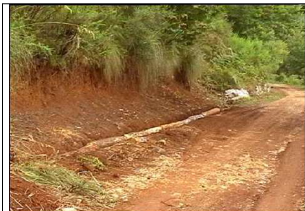
Foto 1: Inizio dei lavori (scavo della fondazione)
