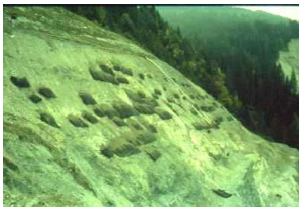
Foto 388: Miniera di Giustino, durante i lavori. Foto: G. Sauli
