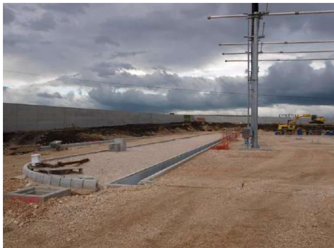
Foto 618: SE di S. Severo (FG) a servizio della Centrale a turbogas in costruzione, scarpata interna della recinzione con muro in cls rivegetabile, febbraio 2010. (Foto G. Sauli)
