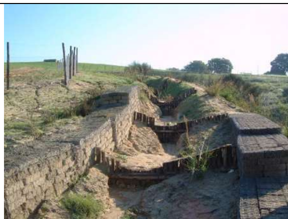
FOTO 20, 21: Piccolo bacino di laminazione sommitale protetto con argini in terra e fascina basale nella zona di raccolta, con gabbioni, sacchi di juta e palizzate trasversali nella zona a monte e d'innesto con il fosso di guardia - D. Dallari
