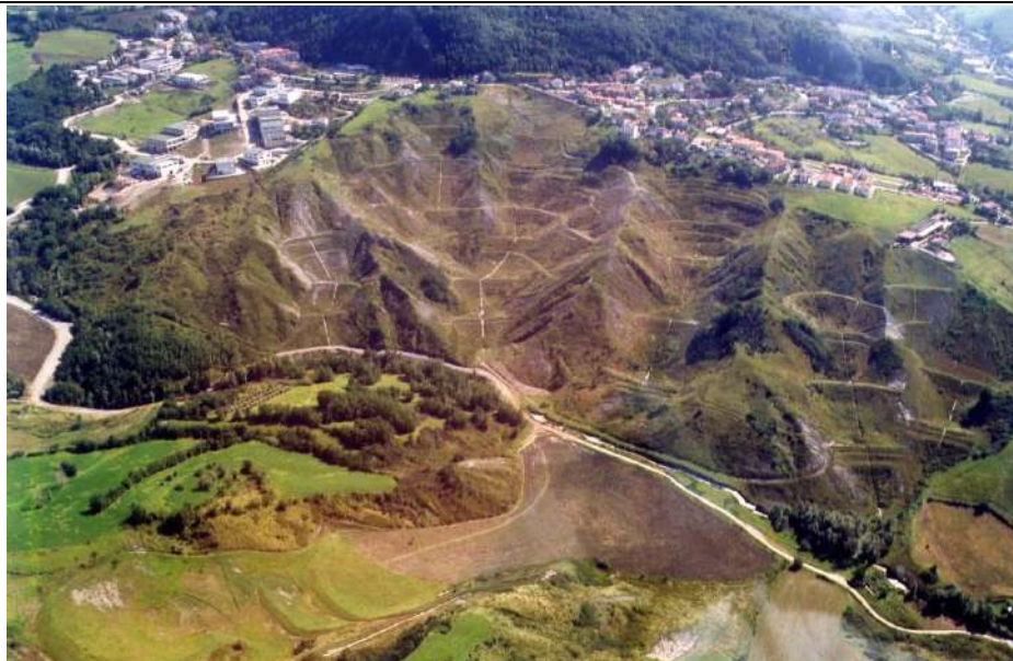
Foto 2: Vista frontale della bonifica del bacino di Fosso del Re dopo l'idrosemina (ottobre 2002) - Foto Archivi Dipartimento Territorio e Ambiente RSM
