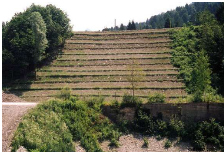
Foto 584: Metanodotto Malborghetto – Bordano (UD) Loc. Pontebba. Gradonate vive e canaletta con graticciata, giugno 2003 – Foto G. Sauli
