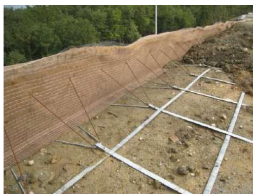
Foto 469 - TRV con rinforzi orizzontali in armature metalliche e stuoie in cocco come antierosivo. Si noti la terra vegetale appressata alle stuoie e reti esterne. (SP 73 Siena – Foto G. Sauli 2009)
