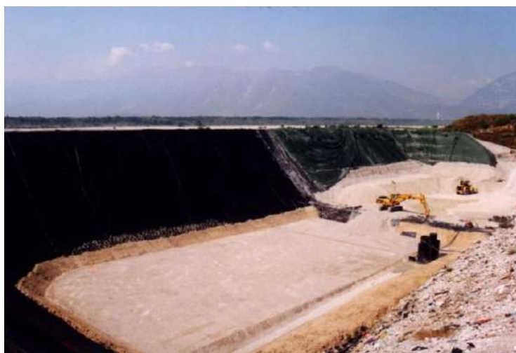
Foto 528 – Discarica di Maniago (PN) Loc. Cossana. Preparazione del fondo di discarica a fossa. Foto: G. Sauli - 2002
