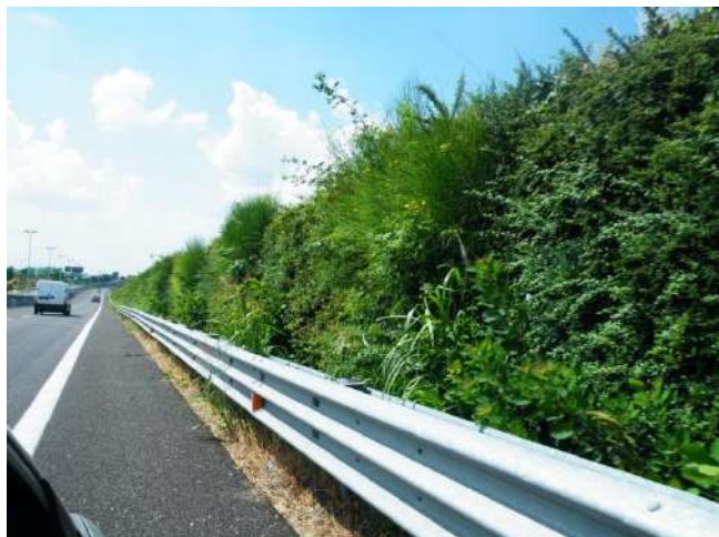
Foto 493 – Barriera antirumore in cls vegetata (Tangenziale di Mantova - Foto R. Santero)
