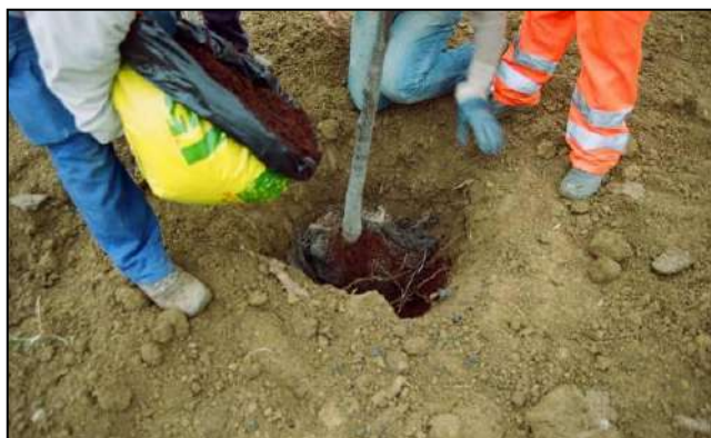
Foto 431 – Messa a dimora di albero in zolla con rincalzo di torba e terreno vegetale. (Foto G. Sauli)
