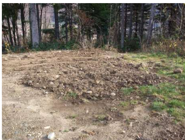
Foto 671: Base di un traliccio demolito con ricomposizione del suolo; Loc. Omegna (VB). (Foto G. Sauli, dicembre 2009)
