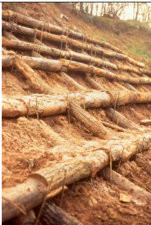
Foto 1: La grata durante i lavori novembre 1994 - P. Cornellini
