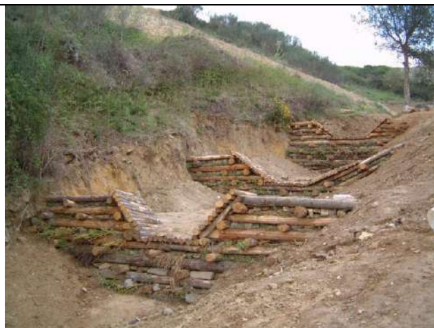
Foto 10: Briglie in legno e pietrame, con inserimento di salici e piantine radicate subito dopo la realizzazione e dopo 8 mesi - D. Dallari
