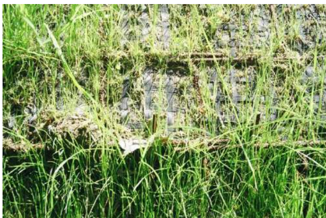
Foto 473 - Messa a dimora di talee di salice su TRV con griglie metalliche, reti sintetiche e stuoie nella sequenza dall'esterno verso l'interno (GVT - Foto G. Sauli 2009)
