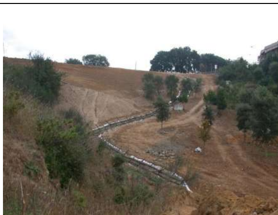
FOTO 4: Visione di una zona degli interventi nella prima fase di sagomatura delle superfici e di sistemazione del compluvio principale con canale in pietra e legno - D. Dallari
