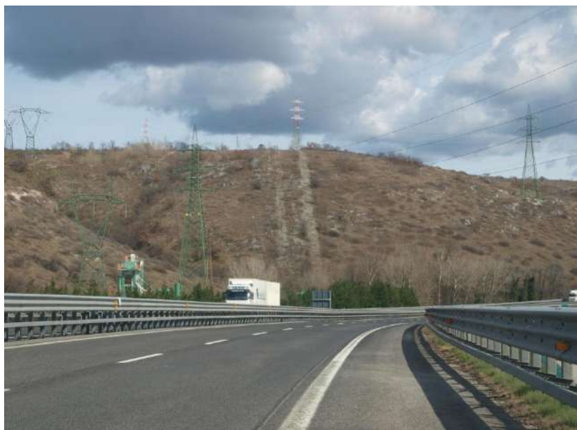
Foto 560: M. Sei Busi Monfalcone (GO) – Visibile il tracciato dell'oleodotto transalpino soggetto a pulizia periodica (a destra) parallelo al recente metanodotto inguinato (a sinistra) non soggetto a pulizia – Foto G. Sauli, 2010
