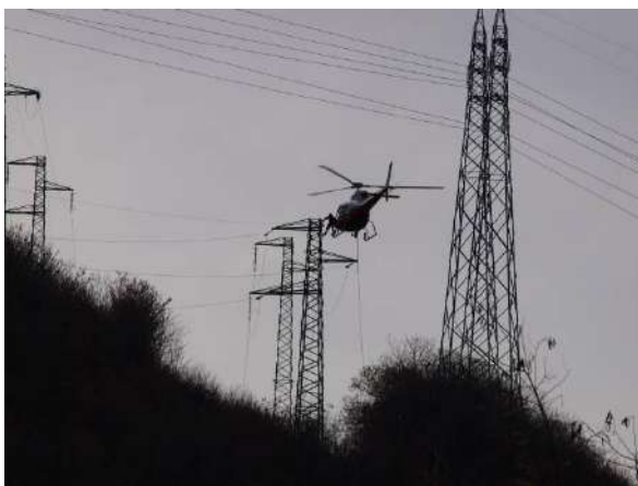
Foto 670: Lavori di demolizione con uso di elicottero sulla linea Loc. Omegna (VB). (Foto G. Sauli, dicembre 2009)
