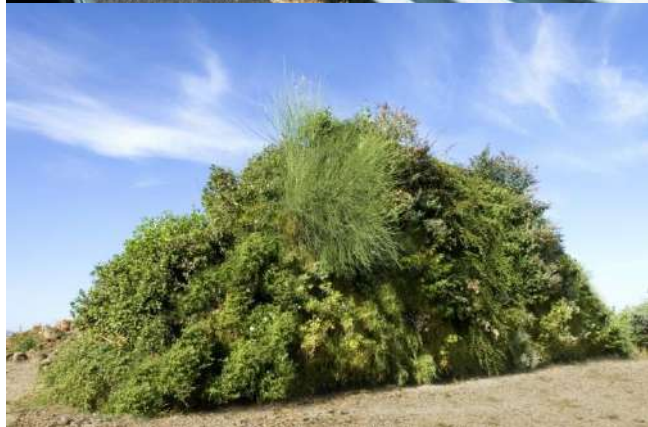
Foto 494 – Barriera antirumore vegetata ad arbusti in terrapieno compresso in struttura metallica. Campione di recente realizzazione con cura particolare per il suolo di riempimento (suolo tecnogenico) ed evidente successo dello sviluppo della vegetazione. (Foto G. Sauli)
