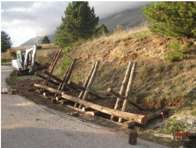
Foto 692: Costruzione palificata L'Aquila Parco Nazionale del Gran Sasso (AQ) 2009 durante i lavori Foto C. Crocetti
