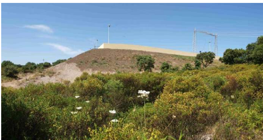
Foto 636: Stazione elettrica di Ittiri (SS), scarpate prima degli interventi a verde e sughereta e gariga a cisti dell'area circostante. (Foto G. Sauli, giugno 2011)
