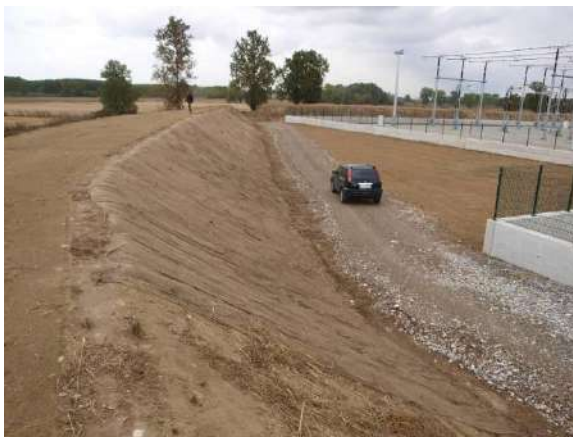
Foto 625: Nuova S.E. di Chignolo Po (PV). Completamento terrapieni di mascheramento con stuoie antierosive in juta. (Foto G. Sauli, estate 2011)
