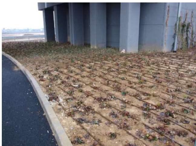
Foto 503 – Impiego di edera tappezzante con impianto di irrigazione a goccia all'ombra del viadotto (Viabilità d'accesso alla nuova zona commerciale di Villesse – GO) febbraio 2010. Foto G. Sauli
