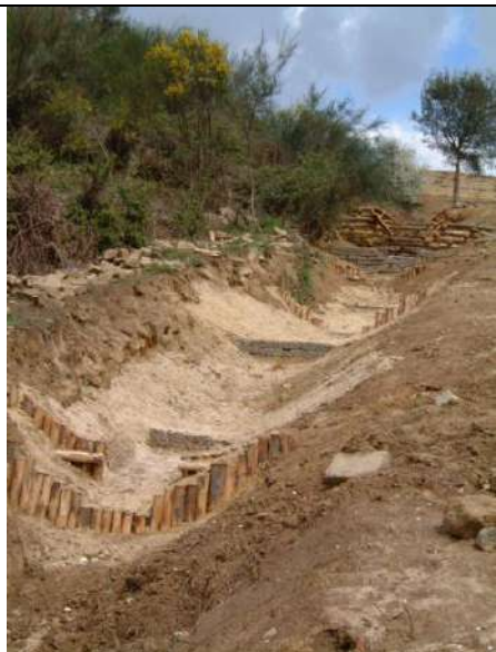
FOTO 18, 19: Opere trasversali quali briglie, soglie in gabbioni, palizzate doppie in legno realizzate per la protezione del compluvio principale nella zona a maggiore pendenza, alla fine degli interventi e dopo 8 mesi - D. Dallari
