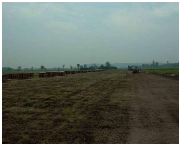
Foto 595: Pista di lavoro ripristinata – 2004 Foto Snamretegas
