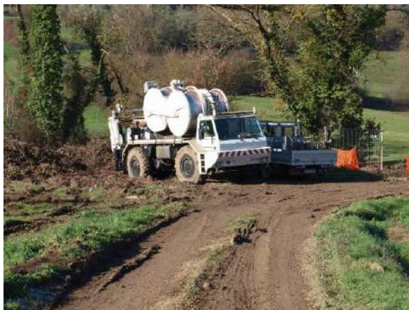
Foto 664: Postazione di lavoro per tesatura; S. Barbara (Scandicci, FI). (Foto G. Sauli, gennaio 2010)
