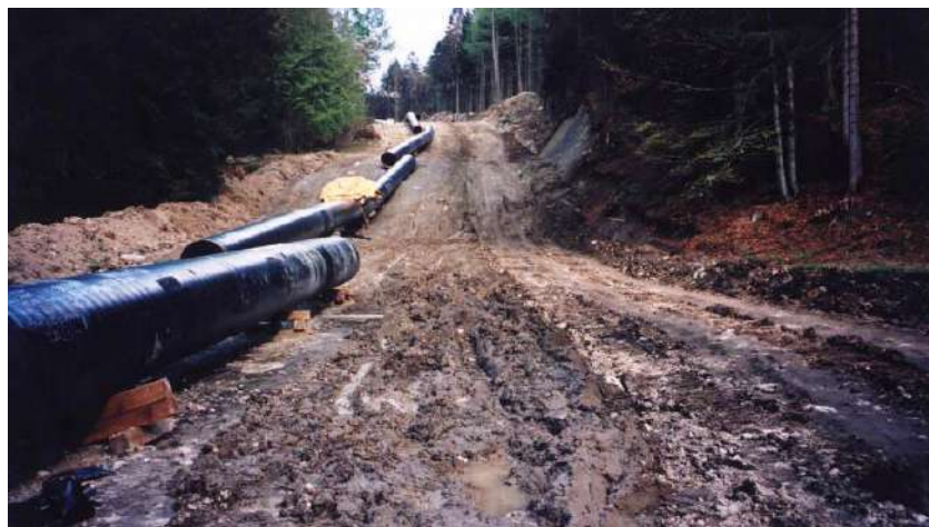
Foto 561: Metanodotto Malborghetto – Bordano (UD) Loc. canale Cialatta. Tracciato in zona boscata con ripristino previsto a prato, fase di cantiere, Posa delle tubature maggio 2002 – Foto G. Sauli
