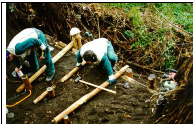
Foto 1: Operai L.S.U. in fase di realizzazione di una palificata Vesuvio sec. Menegazzi (ottobre 1999) - G. Menegazzi
