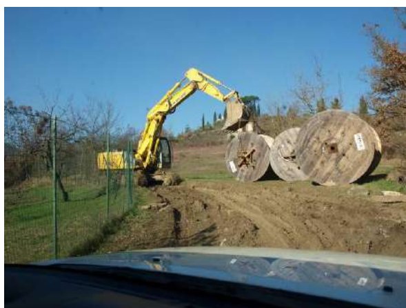
Foto 665: Trasporto dei conduttori tramite piste temporanee; S. Barbara (Scandicci, FI). (Foto G. Sauli, gennaio 2010)
