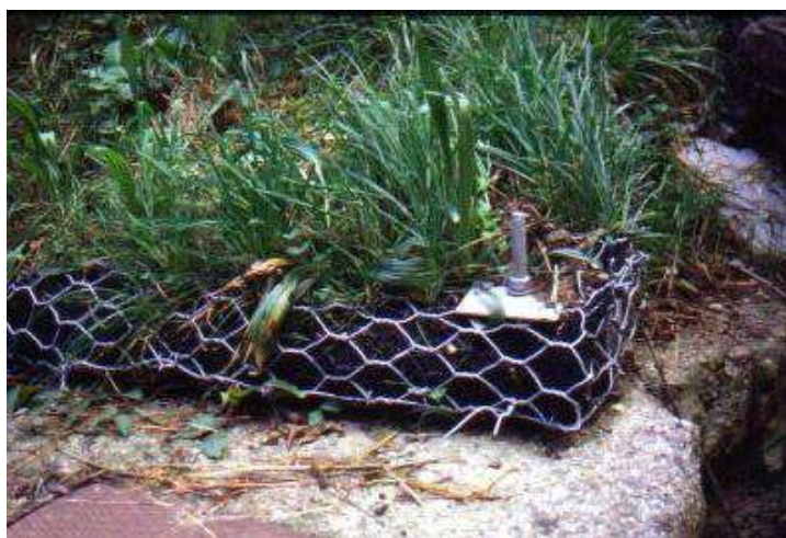
Foto 409: Rivegetazione versanti rocciosi, diga di Ridracoli, materasso verde, Foto: G. Sauli
