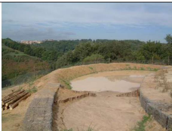
FOTO 20, 21: Piccolo bacino di laminazione sommitale protetto con argini in terra e fascina basale nella zona di raccolta, con gabbioni, sacchi di juta e palizzate trasversali nella zona a monte e d'innesto con il fosso di guardia - D. Dallari
