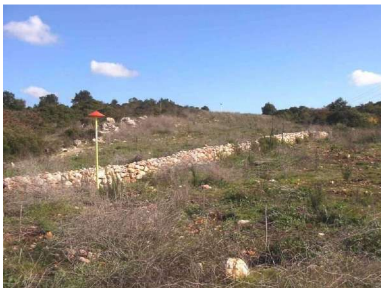
Foto 613: Risultato ad un anno dai lavori di rivegetazione
