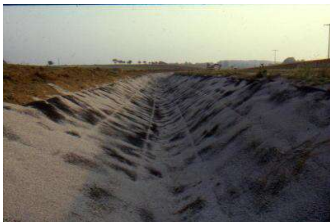
Foto 445- Canale autostradale in geostuoia tridimensionale sintetica seminata, intasata di ghiaino e bitumata in loco. Oltre che funzioni di scorrimento tali strutture verdi assolvono anche funzioni di infiltrazione con effetti benefici di filtrazione del particolato e ripascimento delle falde. (Germania – Foto G. Sauli)
