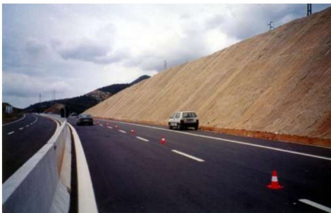
Foto 464 - Reti metalliche e stuoie organiche su scarpate in scavo in condizioni di forte aridità non sempre producono rivegetazione, pur mantenendo la funzione di stabilizzazione. (Sardegna SS 195 Pula – Foto G. Sauli fine anni '80)
