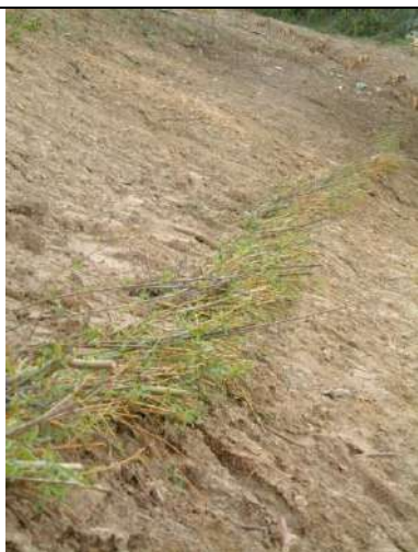
FOTO 9: Particolare realizzazione di gradonata viva rinforzata, con talee piantine radicate - D. Dallari
