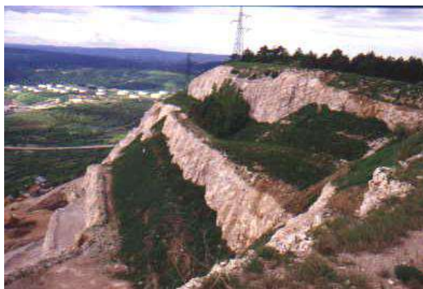
Foto 376: Rivegetazione mediante semine e piantagioni, Cava Scoria (TS), 1999 Foto: G. Sauli
