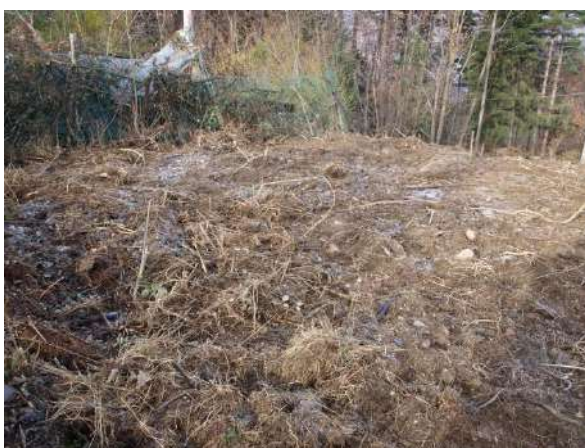
Foto 672: Base di un traliccio demolito con ricomposizione suolo; Loc. Omegna (VB). (Foto G. Sauli, dicembre 2009)
