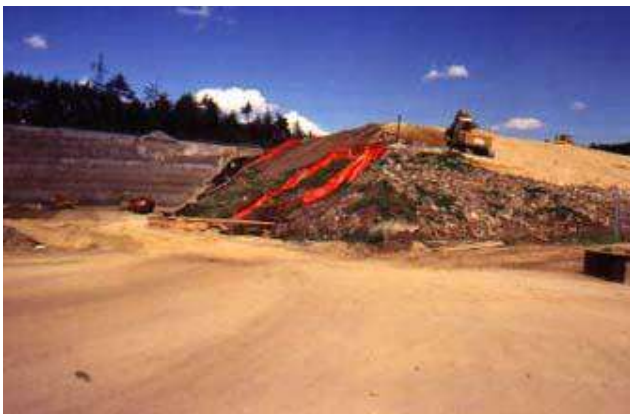
Foto 524 - Fase di ricoprimento con terreno vegetale del I° lotto. Discarica di RSU di Sciaves (BZ), Foto: G. Sauli
