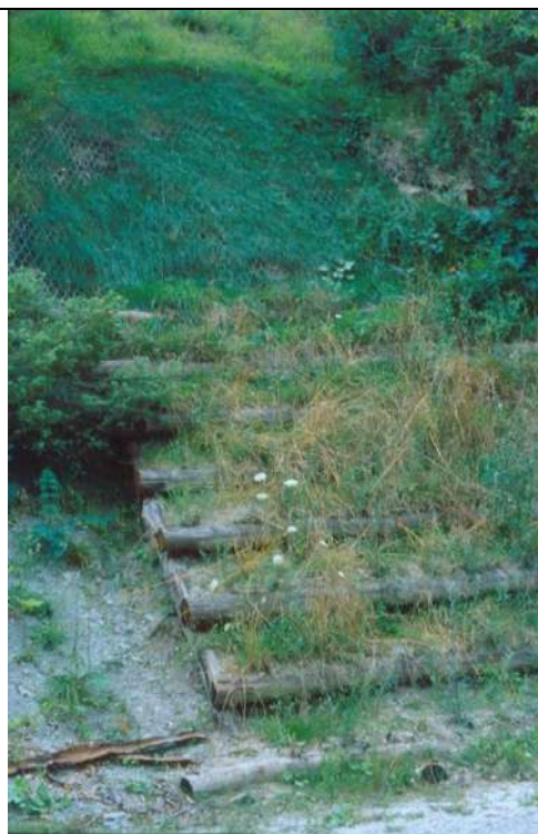
Foto 9: SP Tarugo agosto 2002 grata e rivestimento vegetativo - P. Giacchini
