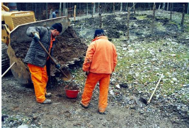
Foto 579: Metanodotto Malborghetto – Bordano (UD) Loc. canale Cialatta. Messa a dimora di alberi e arbusti con protezione in rete metallica a “isole” rinalzo delle buche con terra vegetale locale 21.11.’03 – Foto G. Sauli
