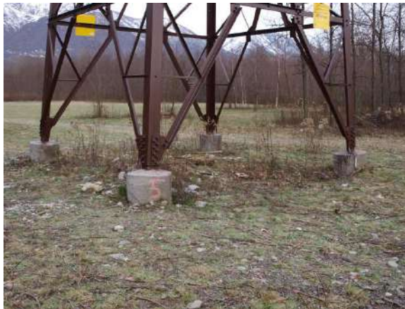
Foto 659: Nuova linea 132 kV loc. Pieve Vergonte (VB). L'ampio spazio sotto il traliccio consente l'eventuale accesso di mezzi agricoli. (Foto G. Sauli, dicembre 2009)
