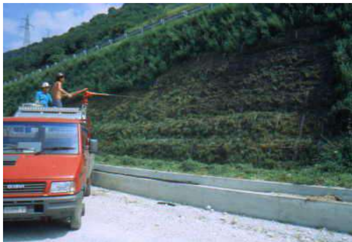
Foto 466 - Idrosemina di rinalzo su TRV (Autostrada V.Veneto - Pian di Vedoia – Foto G. Sauli 1989)
