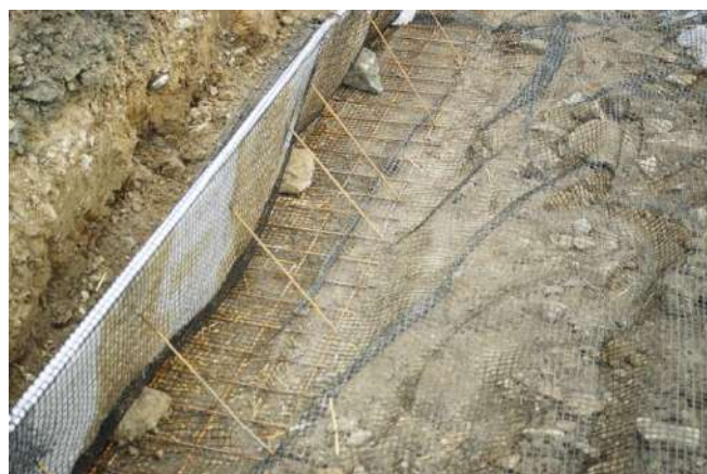
Foto 471 - TRV con armatura orizzontale in reti sintetiche (GVT loc. Domio – Foto G. Sauli 2008)
