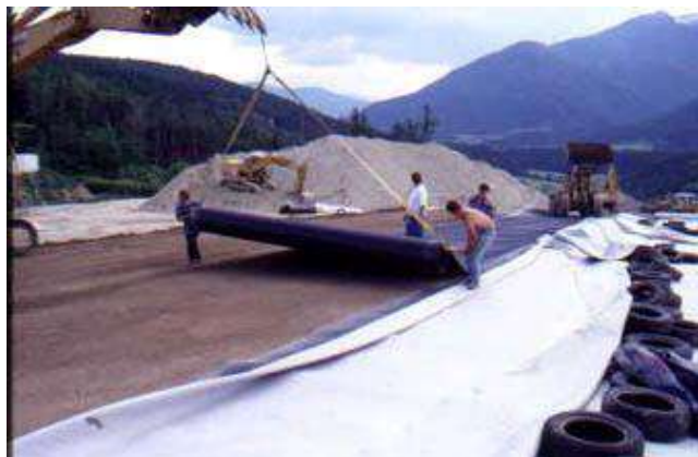
Foto 525 - Sigillatura e copertura superiore con geomembrane e non tessuti. Discarica RSU di Sciaves (BZ) Foto: G. Sauli
