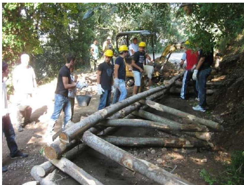
Foto 689: Palificata latina nei Cantieri didattici Corso Ingegneria Naturalistica Scuola Geometri Tallini Formia 2010 Foto P. Cornellini
