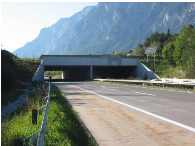
Foto 509 – Sovrappasso per orsi (Autostrada A2 presso Arnoldstein - Austria – Foto G. Sauli)
