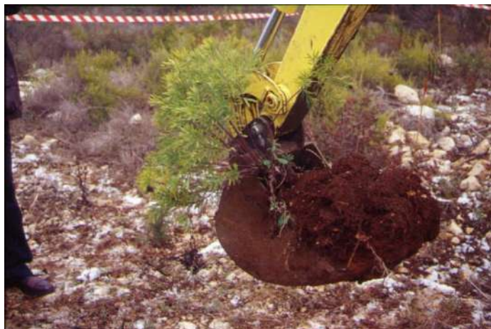
Foto 604: Metanodotto Bernalda – Brindisi, Loc. Massafra, lavori di trapianto di arbusti di gariga mediterranea (dicembre 2001) – Foto G. Sauli
