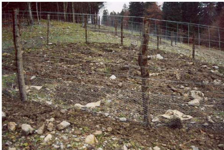
Foto 581: Metanodotto Malborghetto – Bordano (UD) Loc. canale Cialatta. Protezione a “isole”, particolare rete a maglia fitta antilepre. 21.11.’03 – Foto G. Sauli
