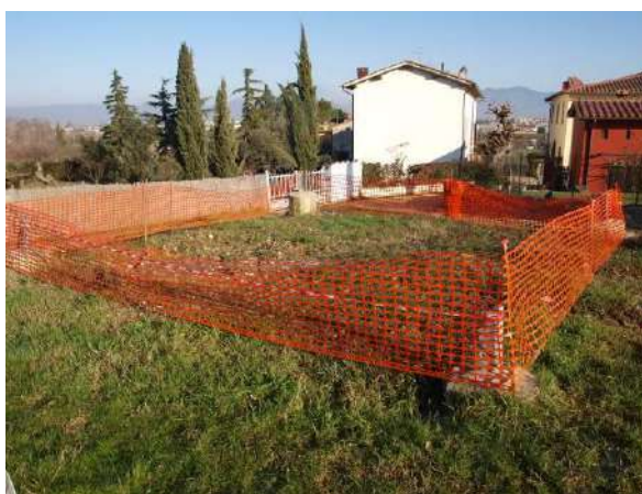
Foto 666: Minicantiere per la demolizione di un vecchio traliccio; S. Barbara (Scandicci, FI). (Foto G. Sauli, gennaio 2010)
