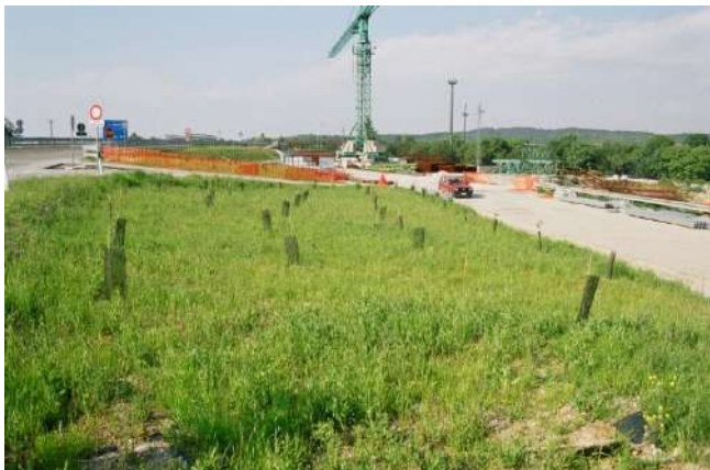
Foto 426 - Esempio di prerinverdimento di scarpate stradali si notino le reticelle antifauna a protezione degli arbusti (GVT Loc.Padriciano - Foto G. Sauli)
