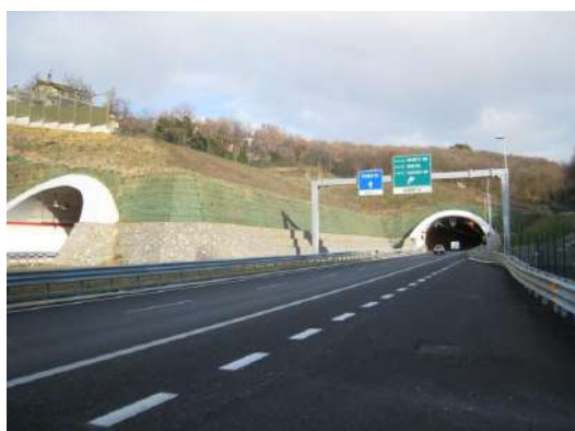
Foto 468 - L'uso di feltri sintetici come antierosivo nelle TRV non consente la crescita del cotico erboso (Galleria Rabuiese GVT-TS - Foto G. Sauli 2009)
