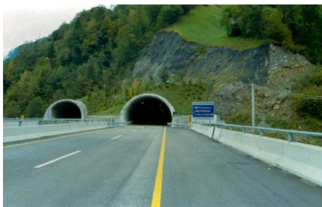
Foto 422 - Prolungamenti in galleria artificiale con rilevati rivegetati ad alberi locali (Autostrada A 23 galleria di Pontebba – Foto G. Sauli ottobre 1987)
