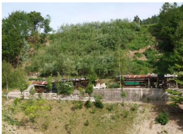
Foto 588: Metanodotto Malborghetto – Bordano (UD) Loc. Pontebba. Gradonate vive con canaletta e messa a dimora di arbusti. Ottime risultanze funzionali e naturalistiche dopo 7 anni anche in termini di biodiversità con costituzione di cespuglietti in zona boscata. Giugno 2010 – Foto G. Sauli
