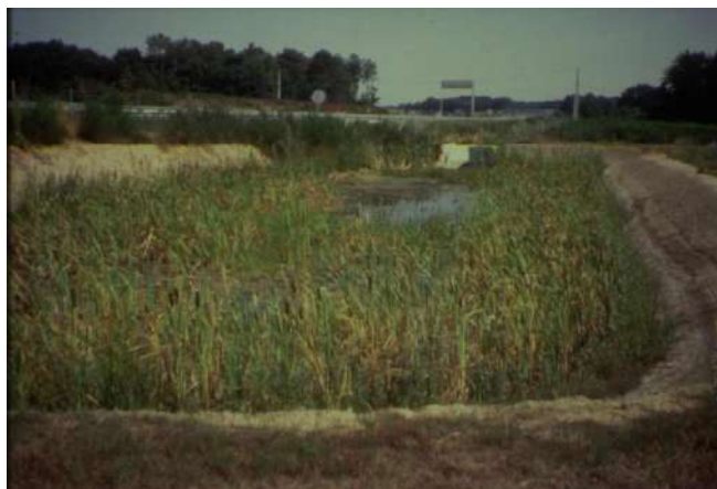
Foto 505 – Vasca di prima pioggia con funzione di fitodepurazione (Francia – Foto P. Cornellini)
