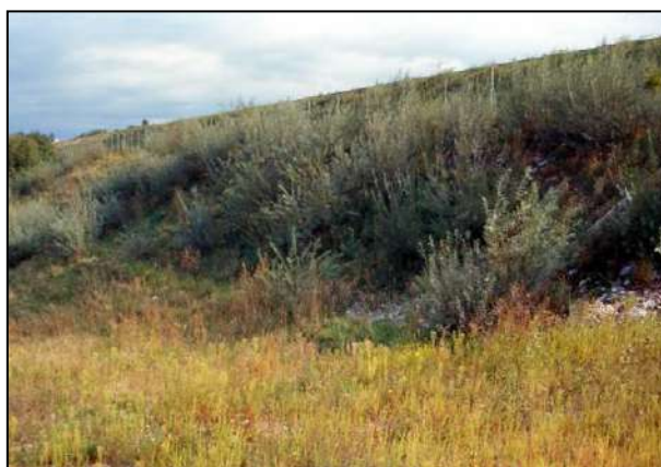
Foto 435 - Piantagione di arbusti autoctoni e talee di salici arbustivi pionieri ( Salix elaeagnos , S. purpurea ) a gradonata su rilevato autostradale su ghiaie calcaree da scavi privo di suolo vegetale Carso triestino Loc. Aurisina (GVT - TS) – Foto G. Sauli 1991
