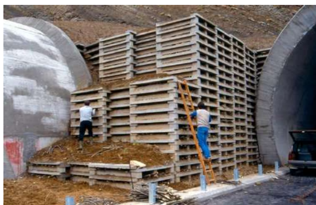
Foto 480 – Muro cellulare di sostegno di terrapieno tra gallerie. (GVT Servola TS – dicembre 1987. Foto G. Sauli)
