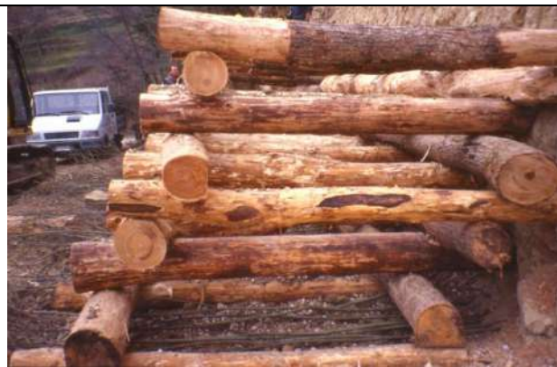
Foto 1: Struttura di una palificata viva doppia di consolidamento del piede della frana1 (marzo 2000) - P. Cornellini
