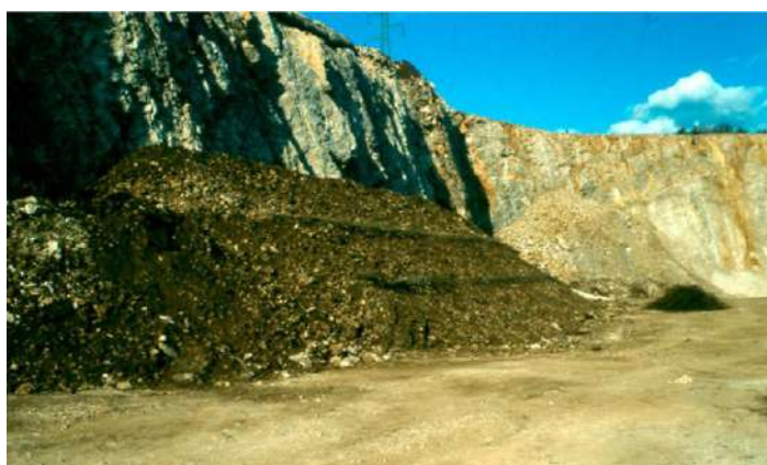
Foto 372: Cava Scoria (TS), inizio lavori di recupero con rilevati rivegetati, campione di prova, marzo 1984, Foto: G. Sauli
