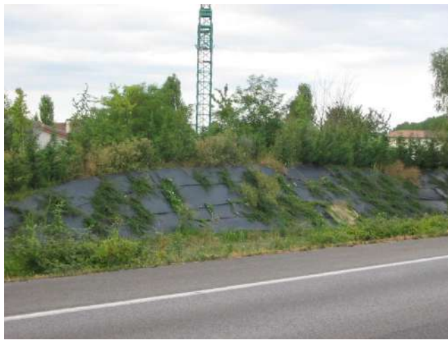
Foto 4335 – Impiego di teli pacciamanti a protezione di specie arbustive. (Foto G. Sauli)
