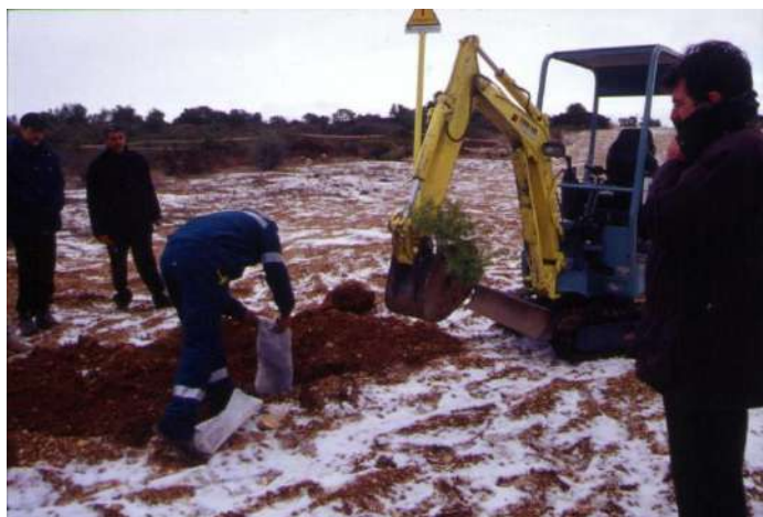
Foto 605: Metanodotto Bernalda – Brindisi, Loc. Massafra, lavori di trapianto di arbusti di gariga mediterranea (dicembre 2001) – Foto G. Sauli
