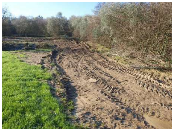
Foto 663: Piste di accesso ai minicantieri, da ripristinare a fine lavoro; S. Barbara (Scandicci, FI). (Foto G. Sauli, gennaio 2010)
