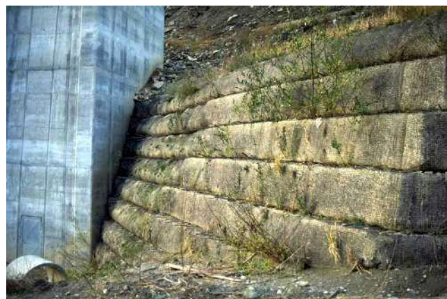
Foto 475 - TRV in reti sintetiche con talee di salice (autostrada del Frejus anni '80 - Foto P. Fantini)
