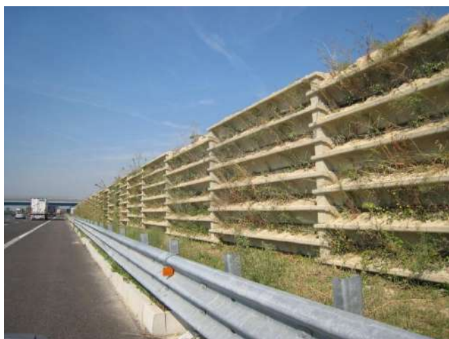
Foto 491 - Barriera antirumore in terrapieno compresso in cls vegetata (Passante di Mestre). Foto G. Sauli 2009
