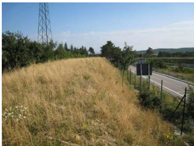
Foto 484 - GVT (TS) terrapieno vegetato di isolamento strada/Area di ricerca. Foto G. Sauli
