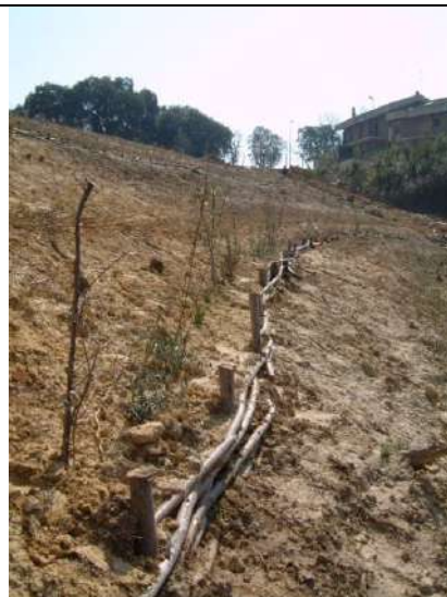
FOTO 8: Particolare di realizzazione di viminata morta con piantine radicate a monte - D. Dallari
