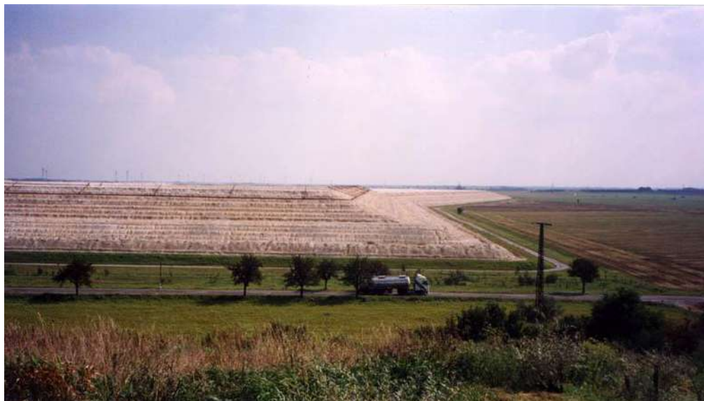
Foto 557: Discarica industriale di residui di lavorazione della soda, fase di deposito su morfologia a “collina”, Hannover (Germania) 2002, Foto: G. Sauli
