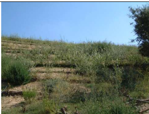
FOTO 15: Zona sistemata con gradonate, vimate e fascinate dopo 8 mesi - D. Dallari
