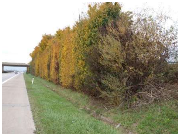
Foto 449 - Siepone a muro (Autostrada A1 – Austria – Foto G. Sauli 2009)
