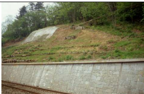
Foto 3: I lavori a aprile 1995 - F. Boccalaro
