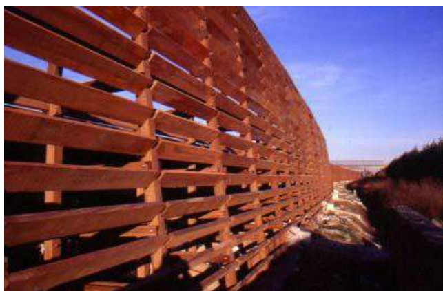
Foto 489 – Barriera antirumore in legno in costruzione (Autobrennero). Foto G. Sauli
