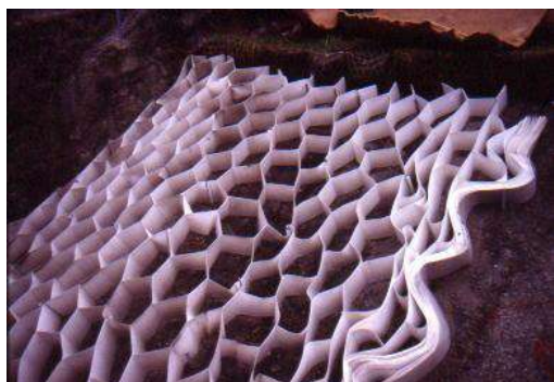
Foto 404: Rivegetazione versanti rocciosi, diga di Ridracoli, geocelle a nido d'ape – fase di costruzione Foto: G. Sauli
