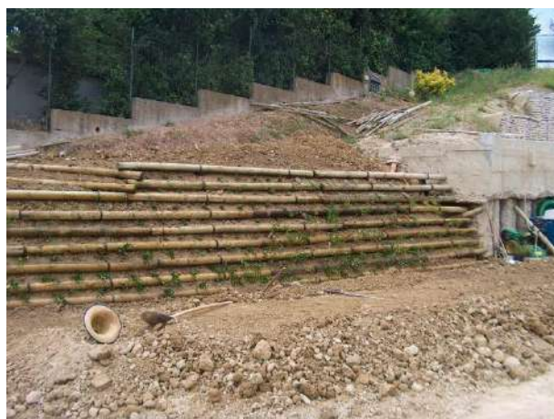
Foto 699: Idem a fine lavori Foto C. Crocetti
