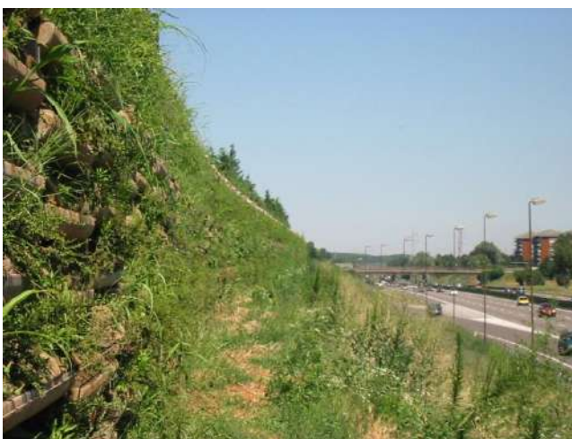
Foto 492 - Barriera antirumore in cls vegetata (Tangenziale di Torino - Foto R. Santero)
