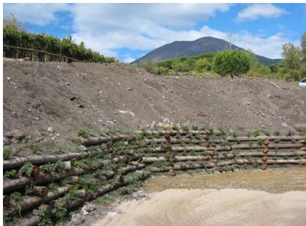
Foto 682: Palificata latina a lavori ultimati sotto il Vesuvio 2007 Foto P. Cornellini
