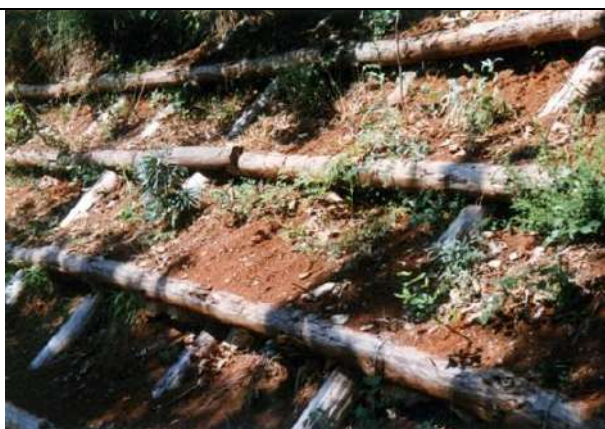
Foto 6: Riempimento con terreno vegetale
