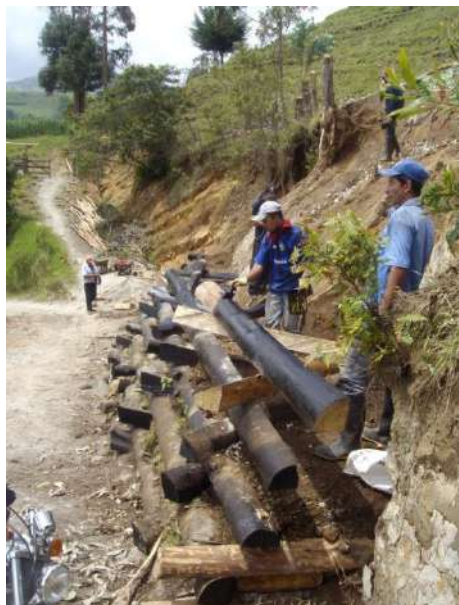
Foto 690 e Foto 691: Palificata Latina a Coconuco (Colombia) – 2011 Foto C. Crocetti
