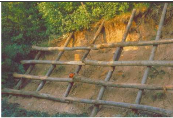
Foto 2: S. Anna- struttura della grata settembre 1999 - P.Giacchini
