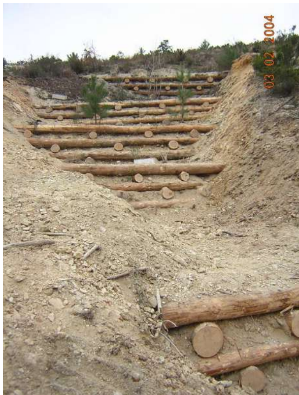
Foto 356: Consolidamento di solco d'erosione con palificate in legname di castagno, in fase di ultimazione – loc. Tosse, Spotorno (SV) - Foto U. Bruschini
