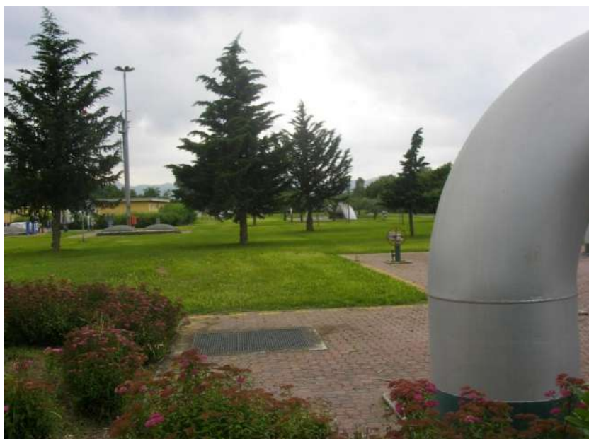
Foto 615: Area interna a prato e siepi ornamentali Centrale di Melizzano (BN) - Foto SNAM
