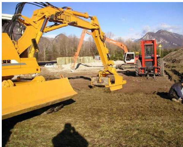
Foto 589: Taglio ed espianto delle zolle erbose – 2003 Foto Snamretgas
