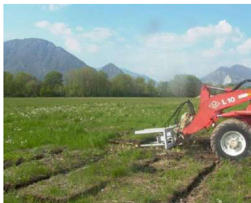
Foto 592: Prelievo delle zolle (Aprile 2004) Snamretgas
