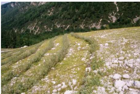
Foto 575: Metanodotto Malborghetto – Bordano (UD) Loc. Val di Gleris , Cordonate vive – Foto G. Sauli 2006 Foto 576: Situazione a giugno 2014
