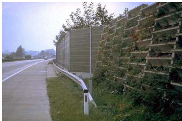
Foto 490 – Barriera antirumore in terrapieno compresso in cls vegetata (Austria anni '80). Foto G. Sauli
