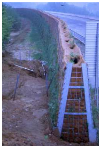
Foto 495 – Barriera antirumore vegetata ad arbusti autoctoni in terrapieno compresso in struttura metallica (Autostrada dei Trafori – Foto G. Sauli fine anni '80)
