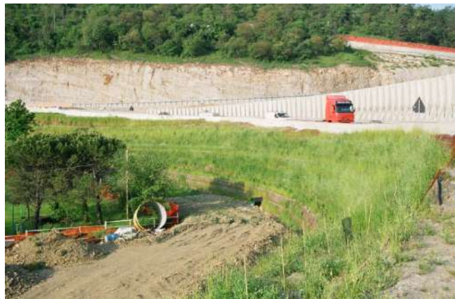
Foto 427 - Esempio di prerinverdimento: costruzione e rinverdimento di terre rinforzate verdi (GVT – curva di Cattinara – Foto G. Sauli)
