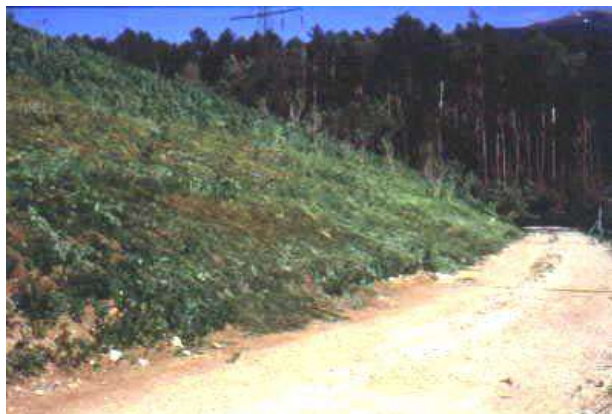
Foto 526 - Rivegetazione mediante semine, messa a dimora di arbusti e gradonate vive di salice. Discarica RSU di versante di Sciaves (BZ). Foto: F. Palmeri
