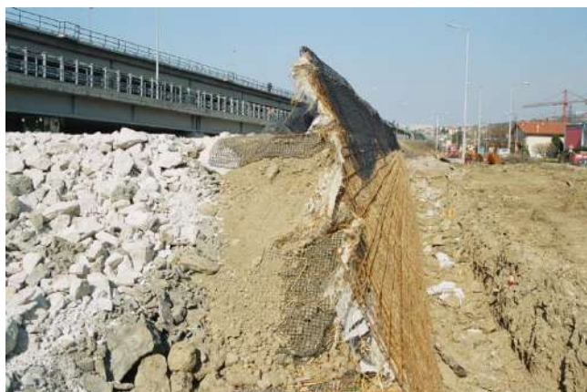
Foto 472 - TRV con armatura orizzontale in reti sintetiche e casseri esterni in griglie metalliche, reti sintetiche e stuoie organiche. Si noti la terra vegetale addossata alle stuoie e reti esterne (GVT loc. Domio – Foto G. Sauli 2008)
