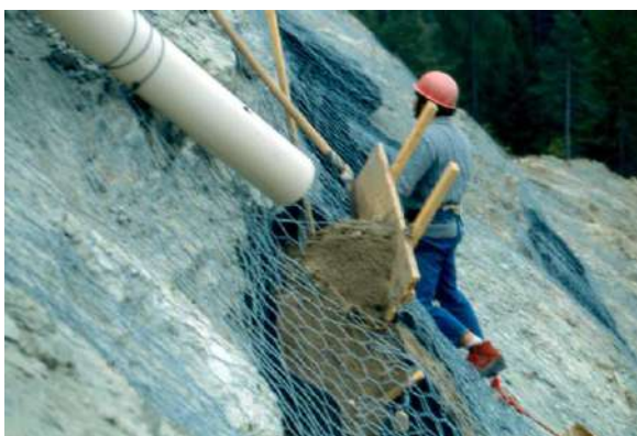
Foto 391: Riempimento tasche in rete con terreno sabbioso, Miniera di giustino, ottobre 1986 Foto: G. Sauli
