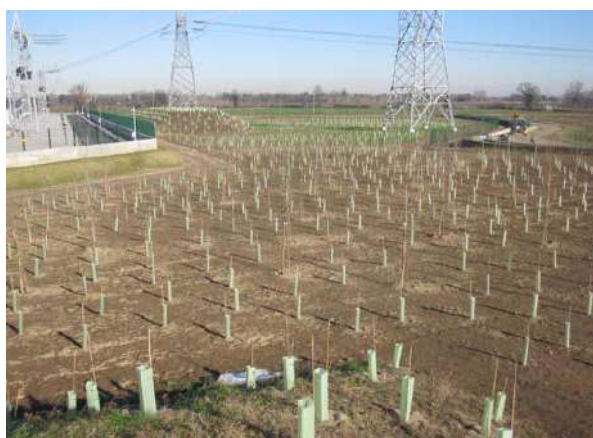
Foto 624: Nuova S.E. di Maleo (LO). Formazione di rilevati di mascheramento con utilizzo dei materiali di scotico misti a inerte di cava. (Foto G. Sauli, inverno 2011)
