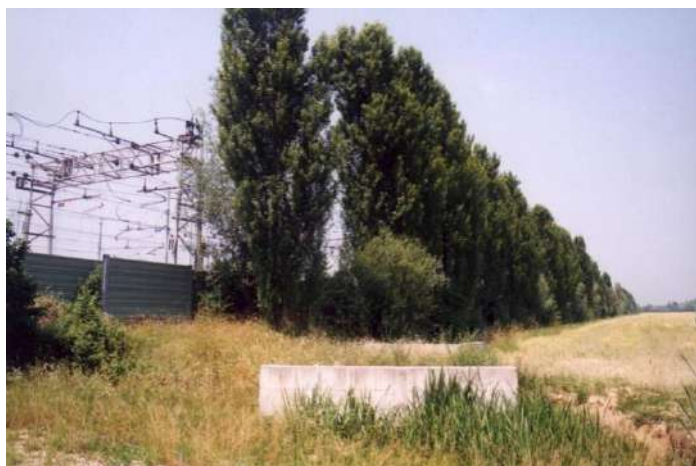
Foto 447 - Fascia boscata di 10 m di larghezza dopo 20 anni dalla realizzazione (scalo ferroviario di Cervignano del Friuli – UD – Foto G. Sauli)
