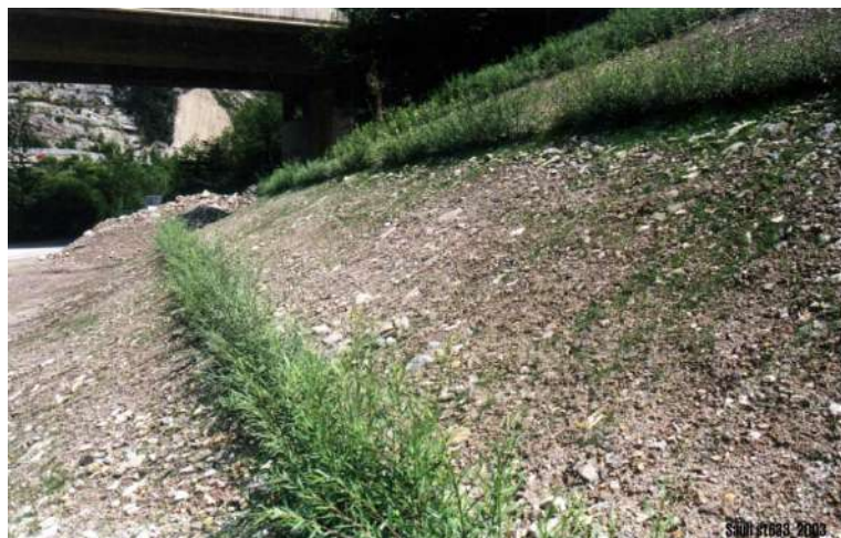
Foto 585: Metanodotto Malborghetto – Bordano (UD) Loc. Pontebba. Gradonate vive, giugno 2003 – Foto G. Sauli
