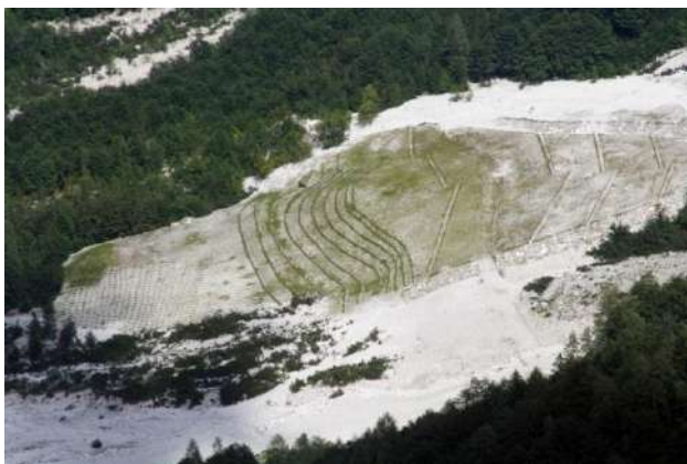
Foto 574: Metanodotto Panoramica degli interventi di IN sulla deponia – Foto V. Zago, luglio 2007
