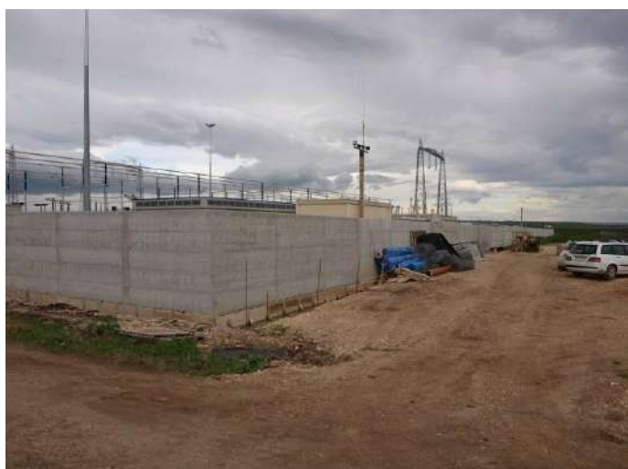
Foto 619: SE di S. Severo (FG) a servizio della Centrale a turbogas in costruzione, vista esterna del muro di recinzione in cls antincendio ed antiintrusione, febbraio 2010. (Foto G. Sauli)
