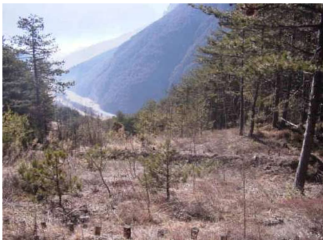
Foto 562: Tratto prima dei lavori: per il ripristino della seconda condotta (anni '80) si noti il maggiore impiego di conifere, che, a distanza di anni, presentavano ancora uno sviluppo non ottimale. - 2001 (Foto Snamretegas)
