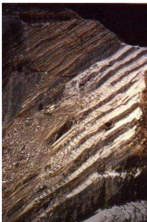
Foto 410: Ante operam, diga di Ridracoli in costruzione, Foto: G. Sauli
