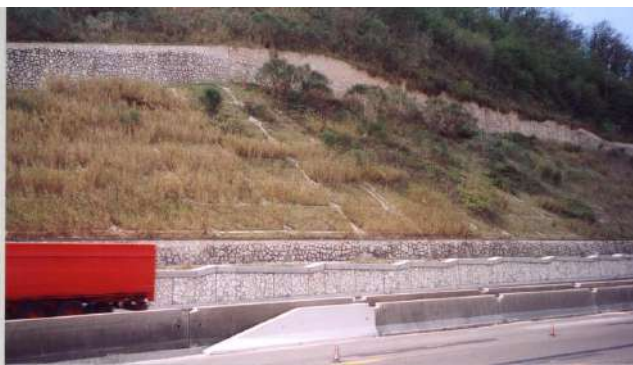
Foto 458 - Autostrada tratto Fiano-Orte stabilizzazione di scarpate in argilla soggette a franamento con mantellate in cls (Foto G. Sauli)
