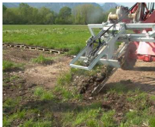
Foto 594: Riposizionamento delle zolle – 2004 Foto Snamretgas
