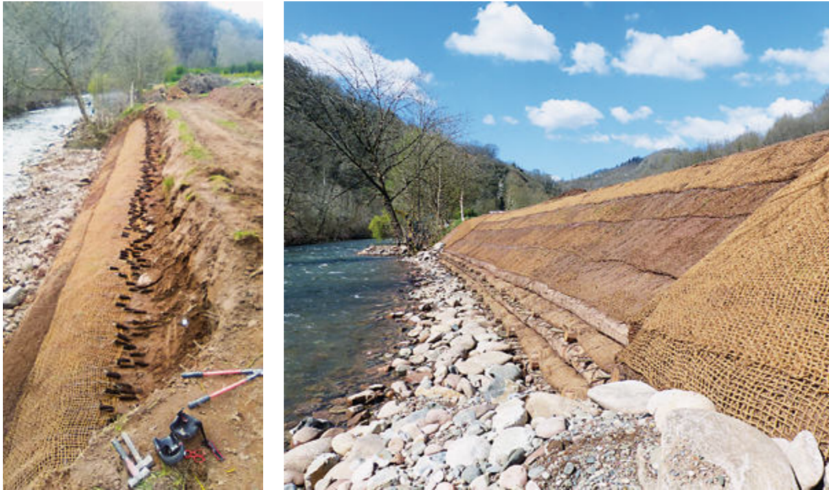
Colocación de la planta en alvéolo forestal e imagen de la obra terminada
