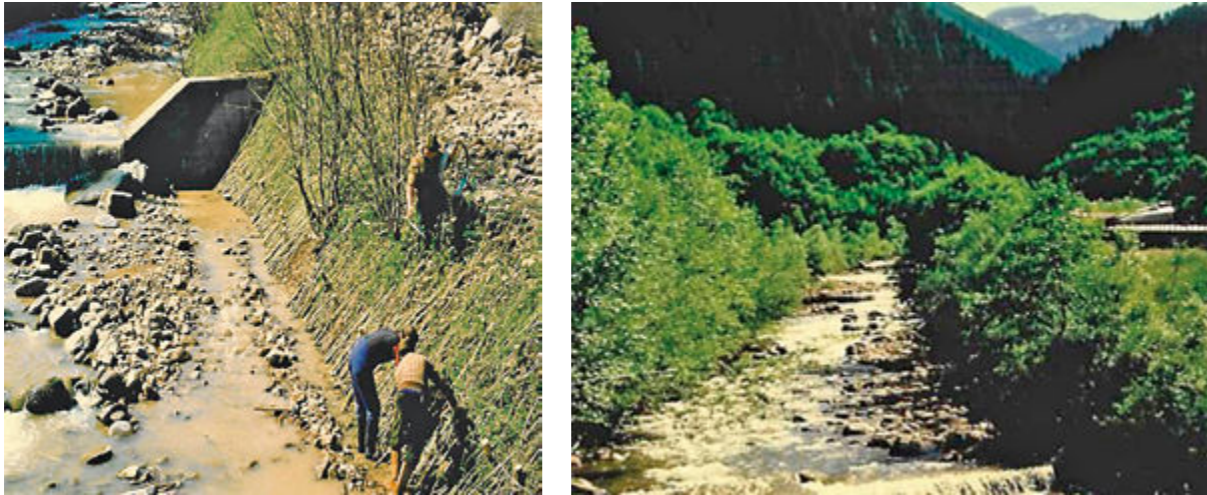
Regeneración de las márgenes mediante una estera de ramaje -Bolzano. Fuente: F. Florineth (1985-1995)
