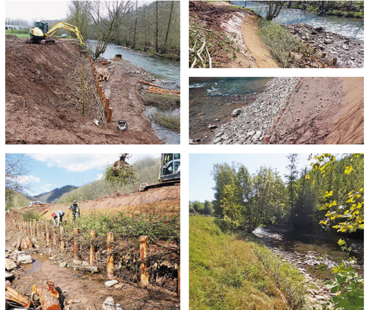
Colocación de las estacas en la línea de la orilla y de las estacas en el interior de la estructura, sujetando el material vivo y muerto alternando direcciones en cada estrato
