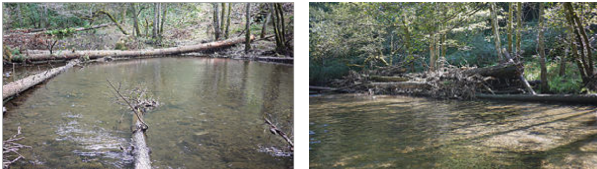
T660: Presa 4+220 apenas ejecutada y tras un año
