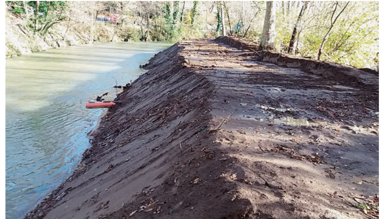
Retaluzado de talud
