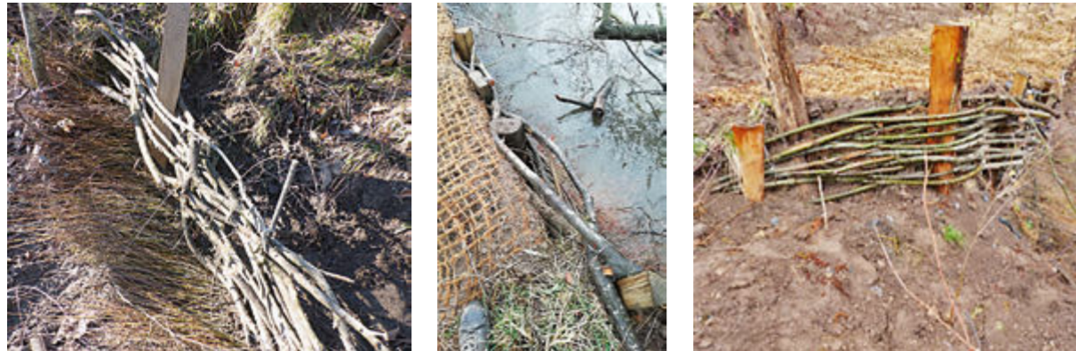
Detalle del trenzado y de las ramas antierosivas, colocación de malla para proteger el trenzado y detalle de terminación lateral
