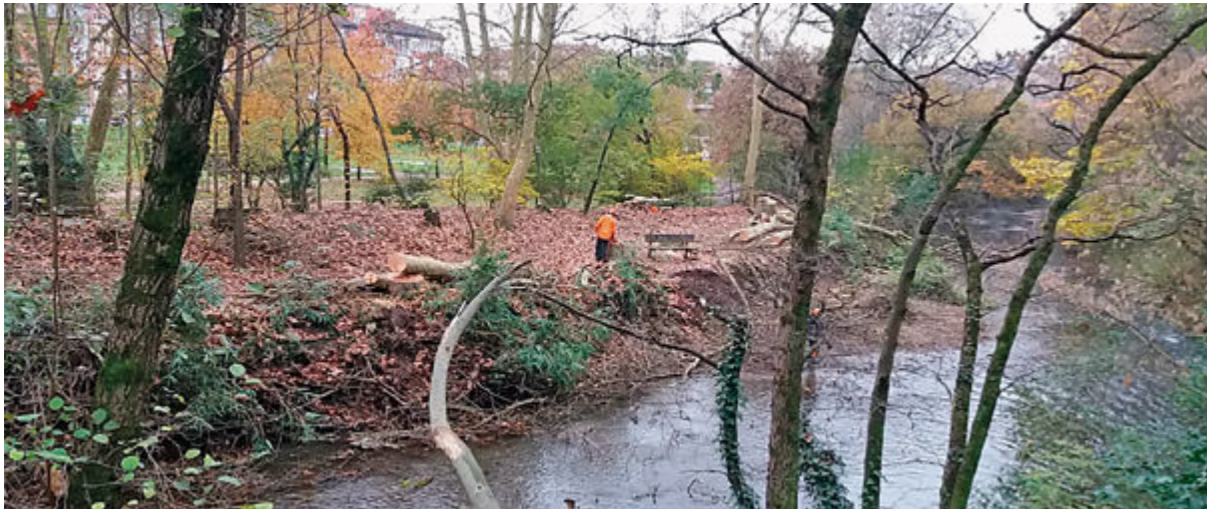
Eliminación del arbolado
