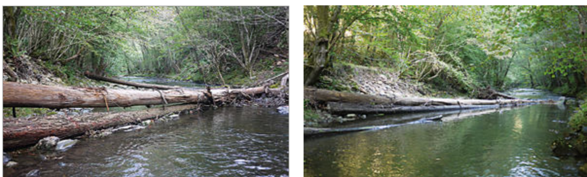
T200: Presa 7+205 apenas ejecutada y tras un año
