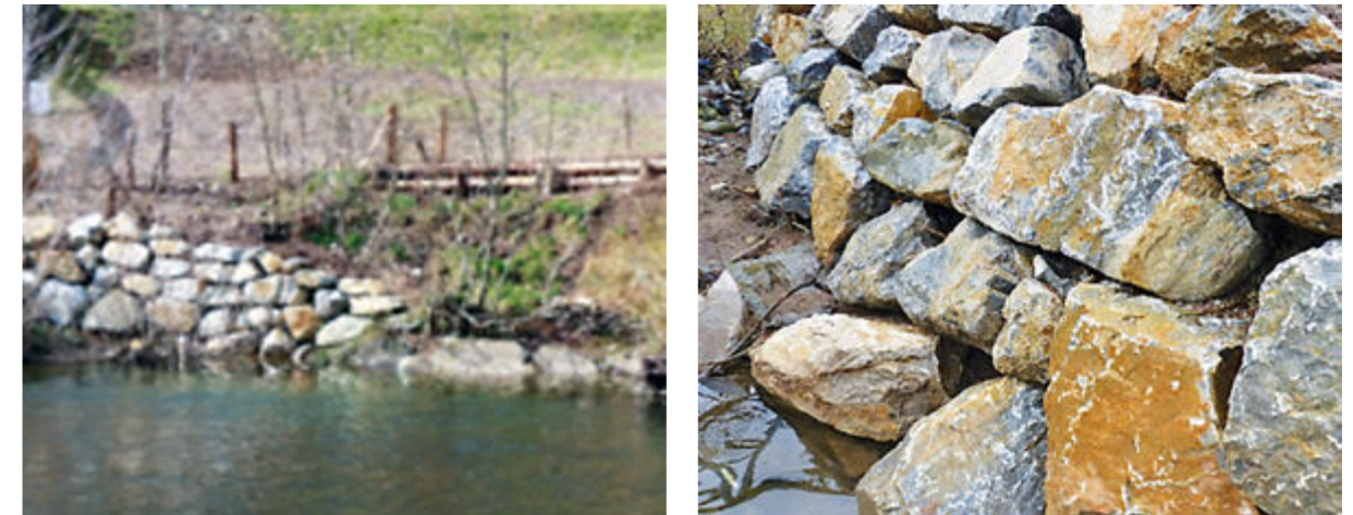
Imagen de la terminación de la escollera. Escollera vegetada
