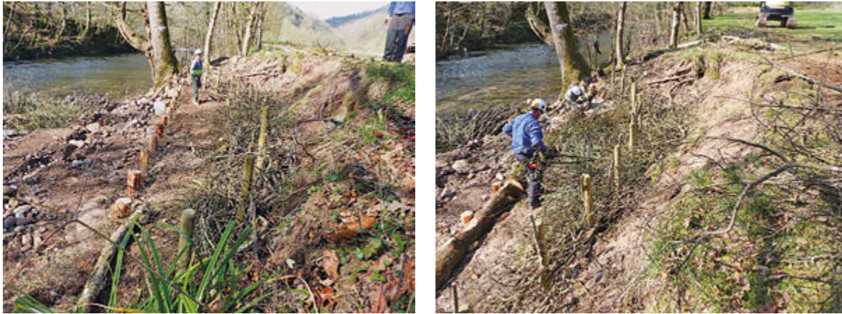
Colocación de material vegetal vivo y cubrimiento con piedra y áridos
