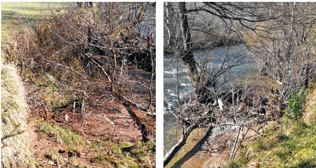
Aspecto inicial de la zona erosionada
