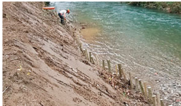
Ejecución de la estera de ramaje
