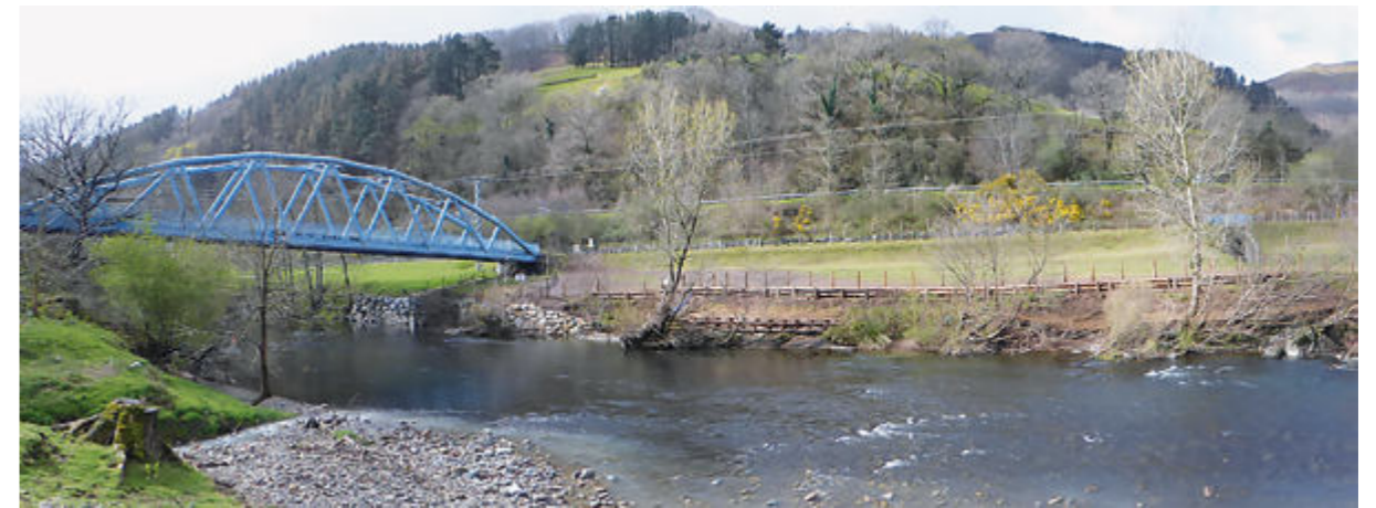
Imagen de la obra recién terminada
