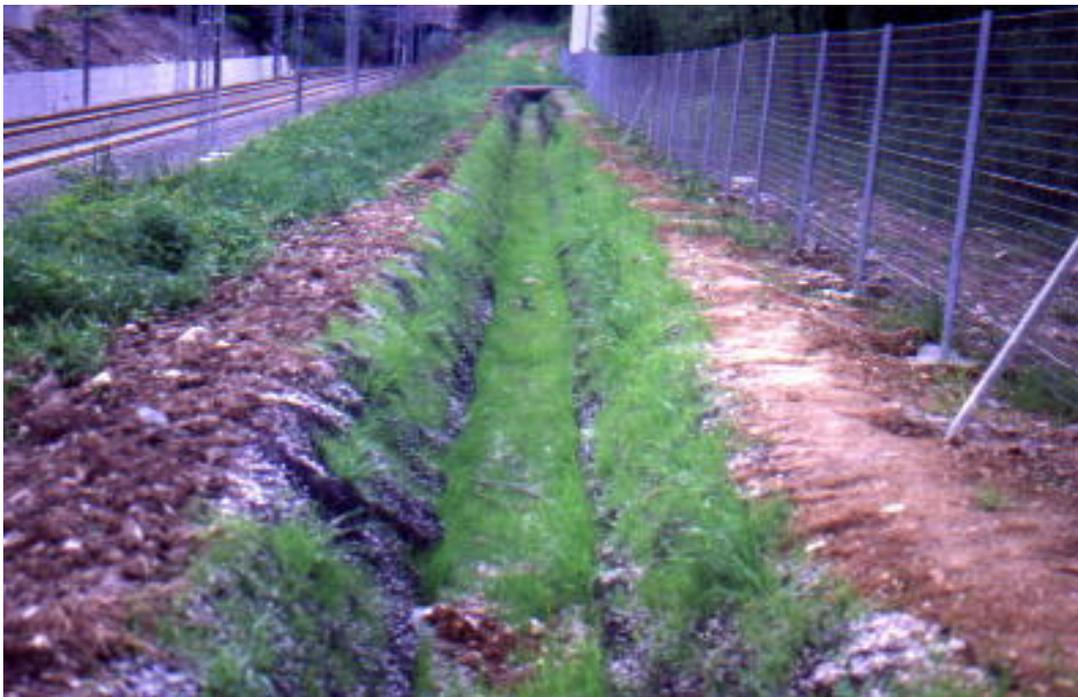
Canaletta in geostuoia tridimensionale sintetica bitumata, Ferrovie Pontebbana, imbocco I, San Leopoldo (UD), 2000
