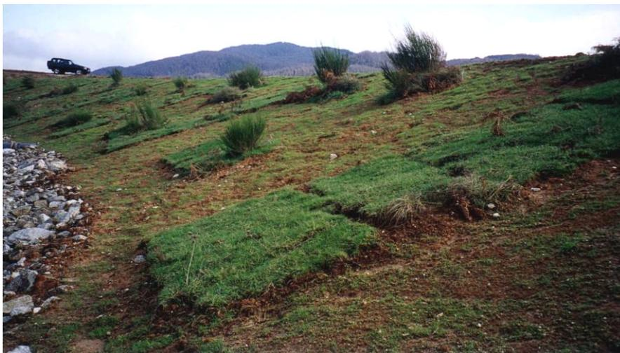
Foto 4: Rinaturalizzazione del paramento di un argine con trapianti di zolle ed ecocelle (giugno 2002) – G. Sauli
