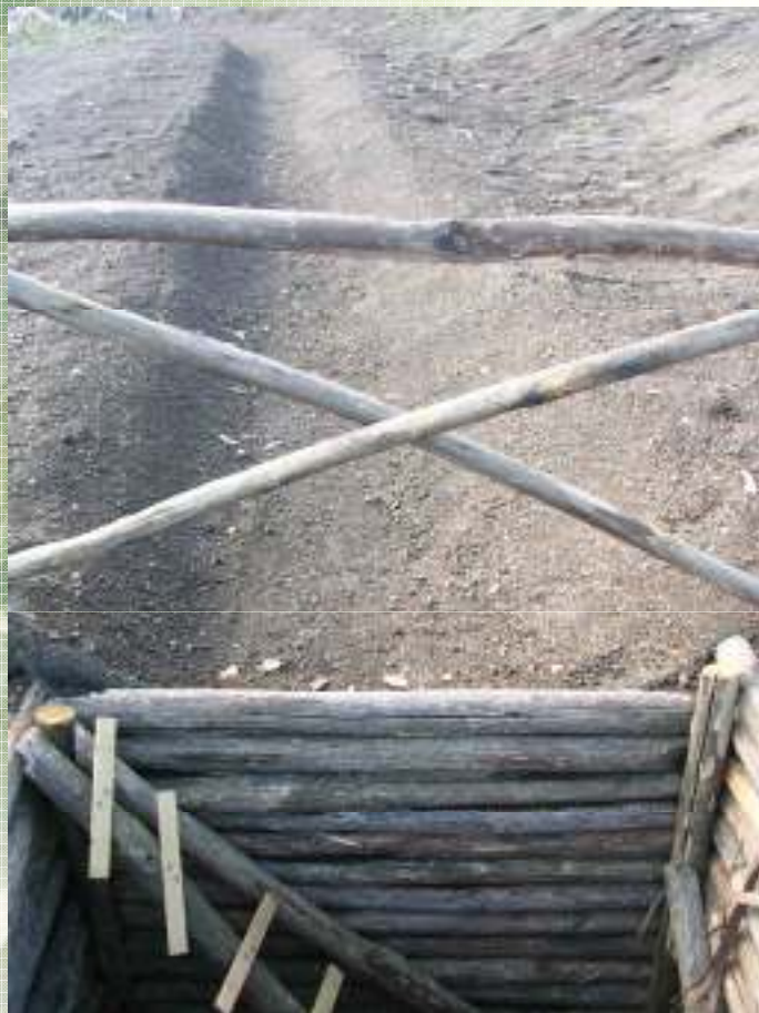
Canaletta rinverdata in fase di realizzazione e fosso di assorbimento
