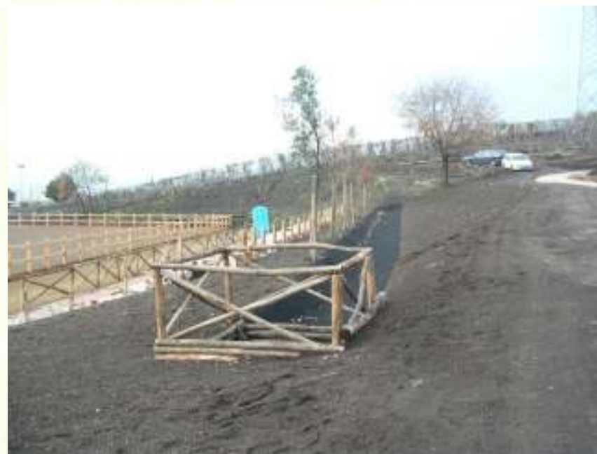
Canaletta rinverdita in fase di realizzazione
