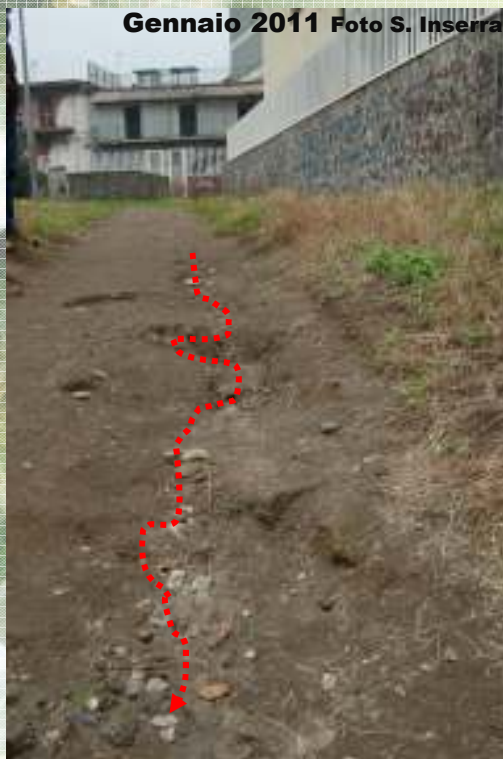
Erosione concentrata in approfondimento
