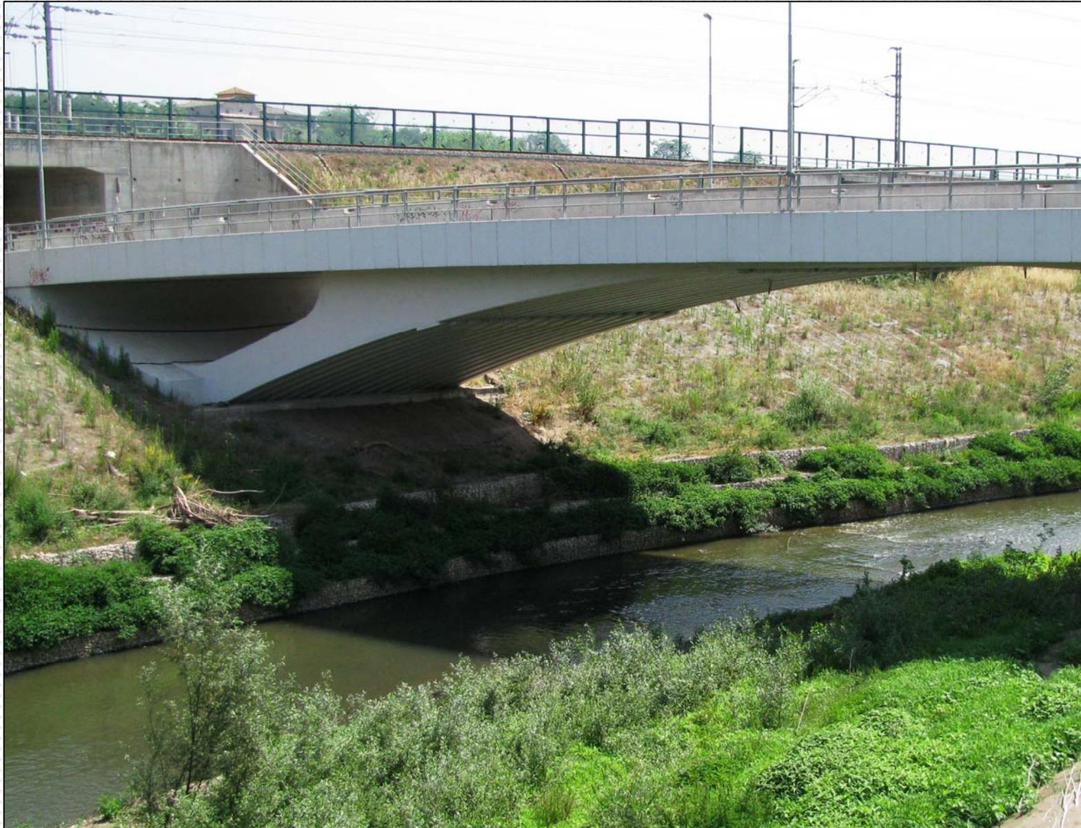
**Figura** - *Sistemazione di sponde del fiume Sacco al cavalcavia IV01 di Sgurgola con gabbioni e biostuoie (da F. Boccalaro, 2006)*
