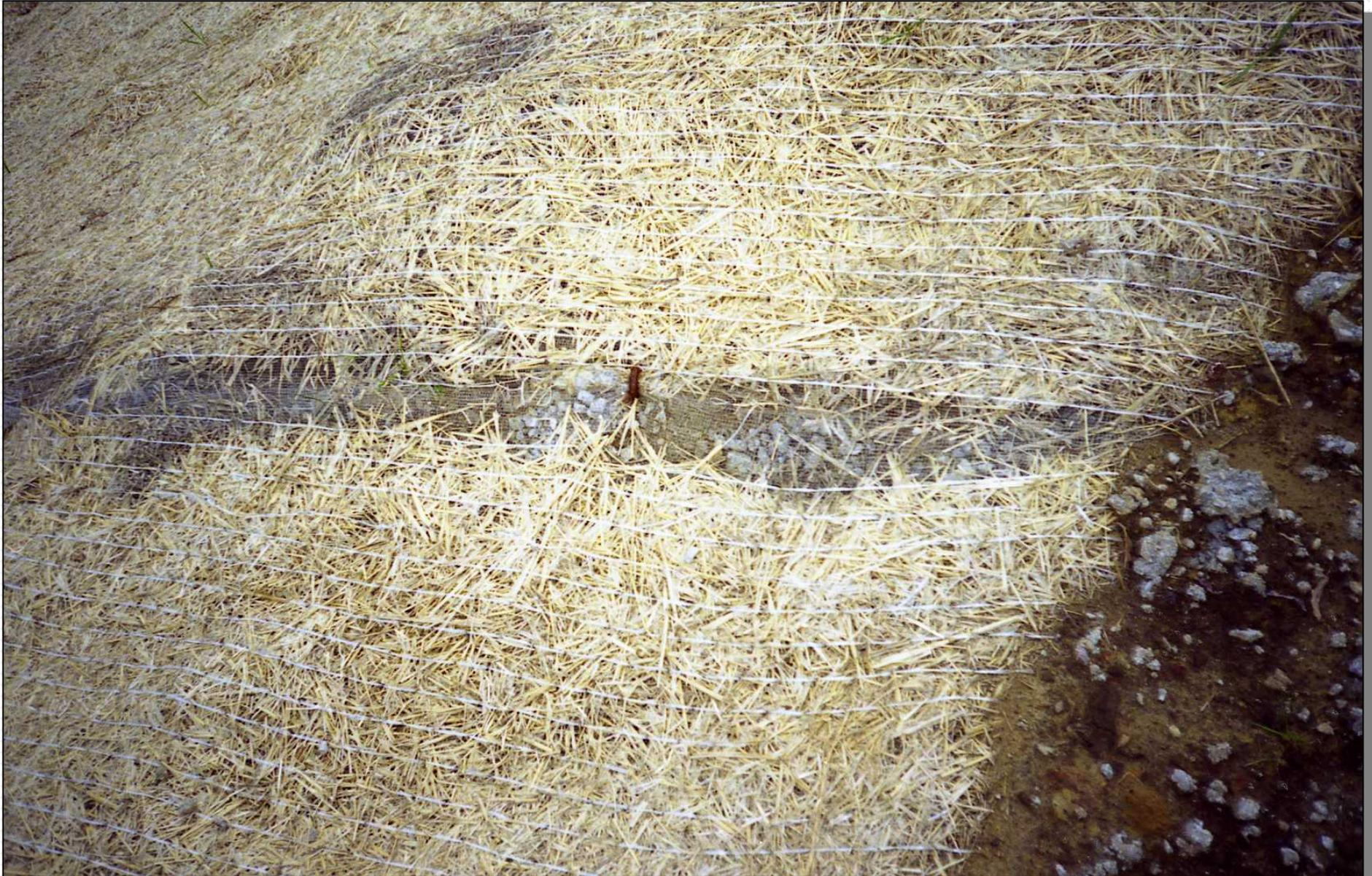
**Figura** - *Sistemazione di imbocco galleria naturale con biostuoia in paglia* (da F. Boccalaro, 2008)
