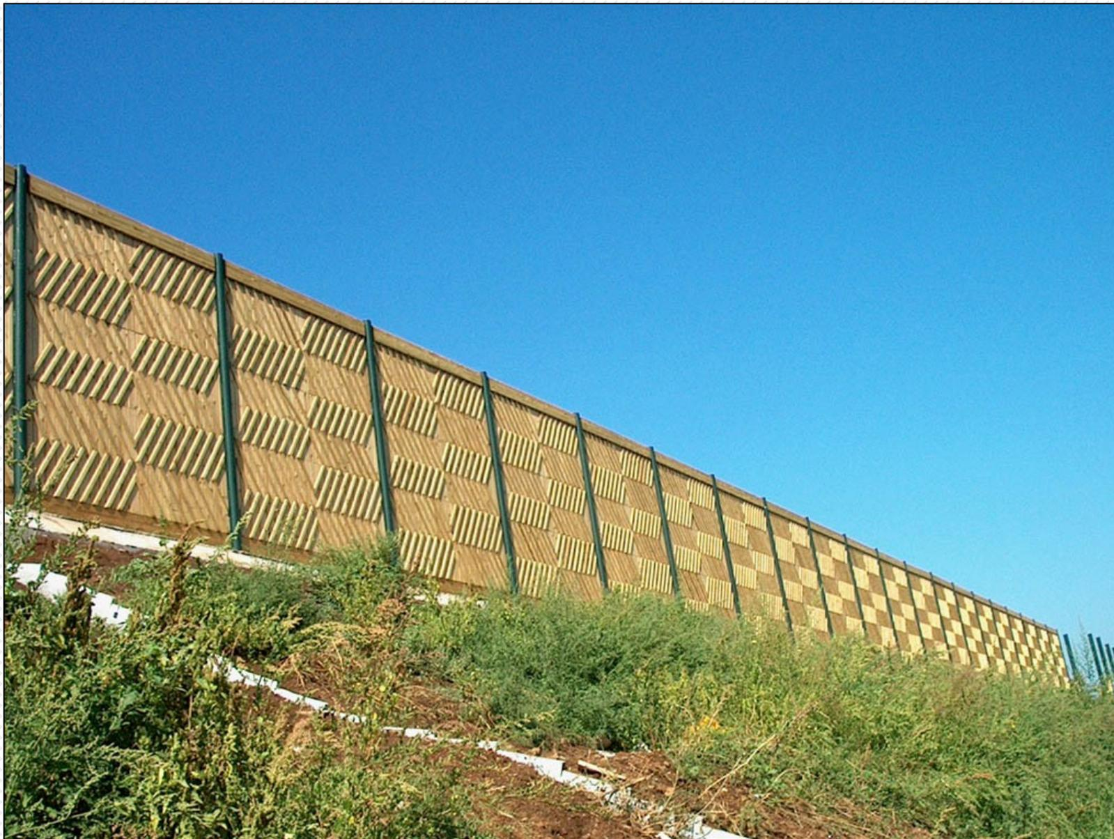
**Figura** - *Barriere in metallo e pmma* (da F. Boccalaro, 2006)
