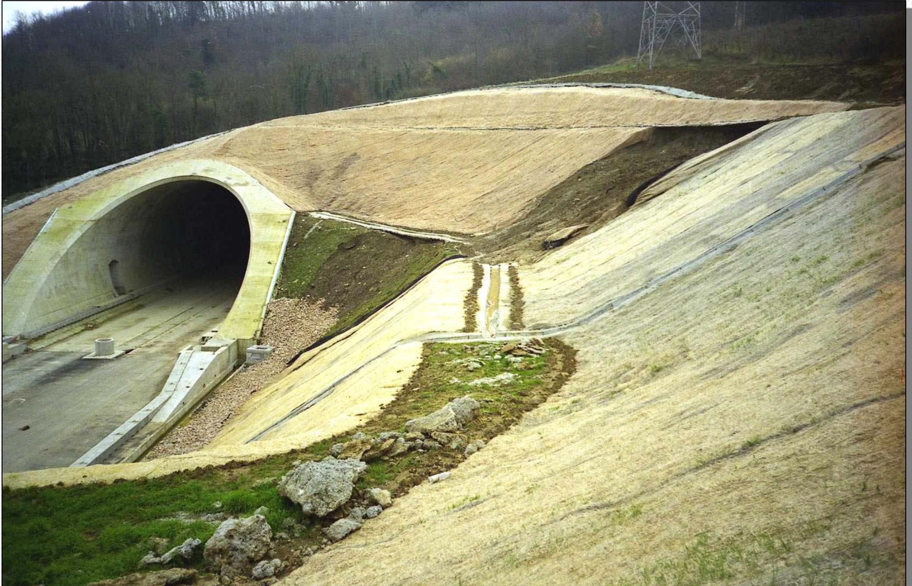
**Figura** - *Sistemazione di imbocco galleria naturale con biostuoia in paglia (da F. Boccalaro, 2000)*
