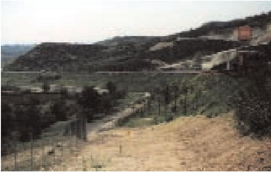
Foto 18.8 - Scarpata in rilevato, rinverditata 3a corsia Autostrada Orte-Fiano Settembre 2002 - Foto G. Sauli.
