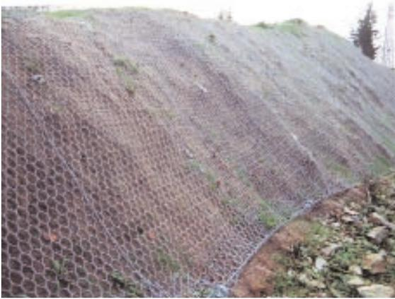
Foto 18.32 - Scarpata in roccia arenacea a 45° con rivestimento vegetativo in rete metallica e stuoia organica. Stazione FS Tarvisio - Boscoverde. Foto G. Sauli - 2000
