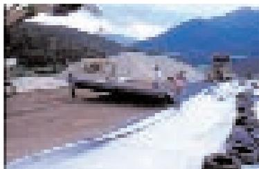
Foto 17.3 - Sigillatura e copertura superiore con geomembrane e non tessuti. Discarica RSU di Sciaves (BZ) - Foto: G. Sauli
