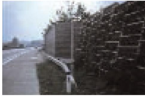
Foto 18.69 - Muro cellulare rinverdito. Austria. Foto G. Sauli
