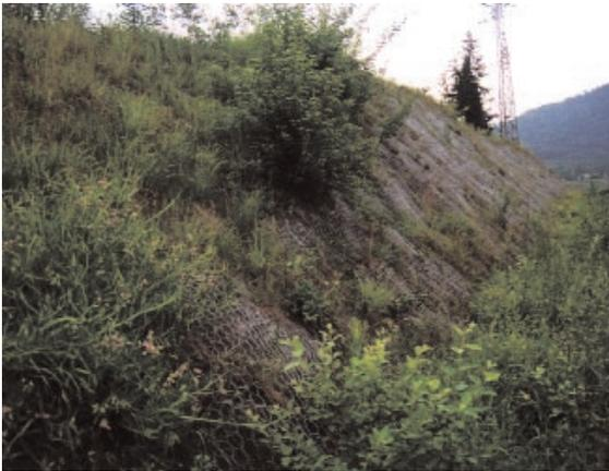
Foto 18.33 - Scarpata in roccia arenacea a 45° con rivestimento vegetativo in rete metallica e stuoia organica. Stazione FS Tarvisio - Boscoverde. Foto G. Sauli - Giugno 2003
