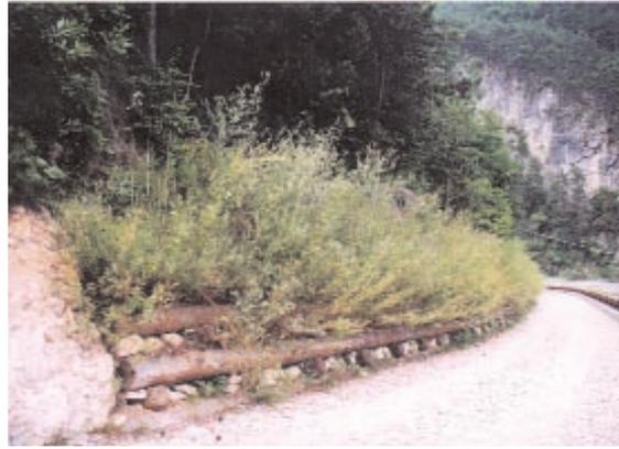
Foto 18.50 - Sostegno scarpata stradale in zona montana, con palificate vive in legname e pietrame, rinverdite con talee di salice. Pista laterale di servizio Loc. Ponte di Muro (UD). Foto V. Zago - 2002
