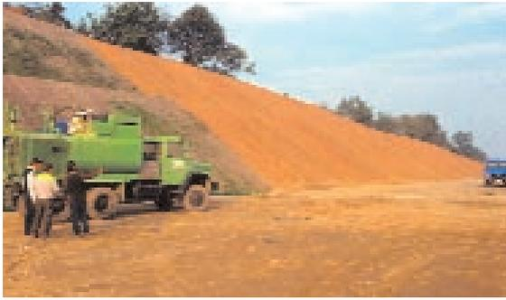
Foto 18.30 - Rivestimento antierosivo con stuoia in cocco. Autostrada dei Trafori. Ottobre 1988 - Foto G.Sauli
