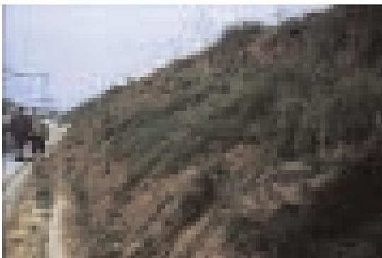
Foto 18.34 - Scarpate in trincea in argilla stabilizzate con sola idrosemina. Arezzo - Ferrovia direttissima Firenze-Roma. Foto P. Cornelini
