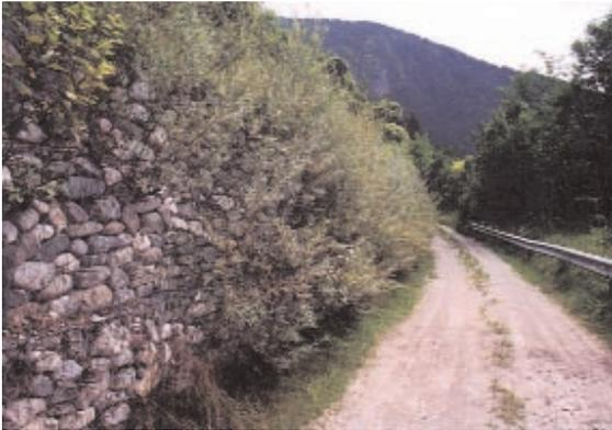
Foto 18.49 - Sostegno scarpata stradale in zona montana, con gabbionate rinverdite con talee di salice, inserite durante la costruzione, sino a toccare il terreno retrostante. Pista laterale di servizio Loc. Moggio (UD) Foto V. Zago - 2002
