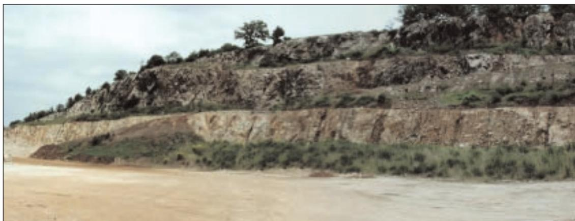
Foto 2a - Situazione attuale: si notano le sistemazioni del fronte a gradoni, i riporti di terreno di scoperta e vegetale, l'attecchimento di essenze arbustive ed erbacee, nonché, in parte il trattamento di invecchiamento delle alzate dei gradoni superiori
