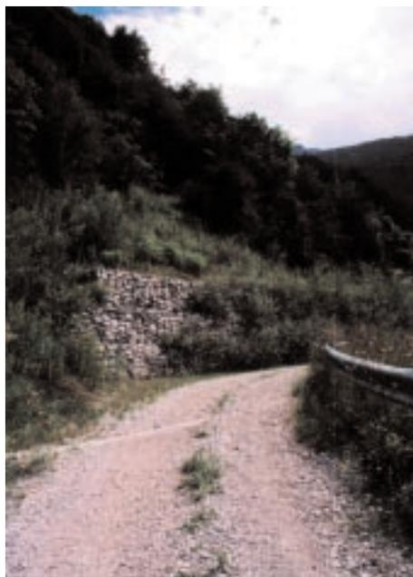
Sostituzione di muro in CLS con gabbionate rinverdate
