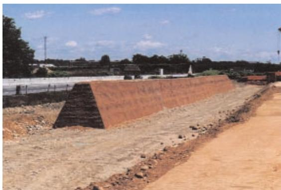
Foto 18.64 - Terrapieno antirumore in doppia terra rinforzata verde. Ferrovia Alta velocità To-MI presso Novara Maggio 2003. Foto Maccaferri
