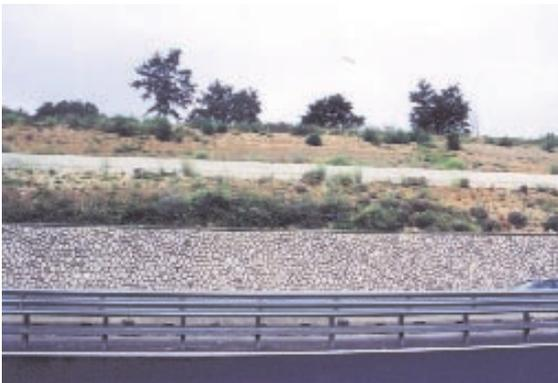
Foto 18.20 - Interventi strutturali di consolidamento di una scarpata in trincea in frana in micropali e muro in cls. Raccordo Roma nord - Foto G. Sauli
