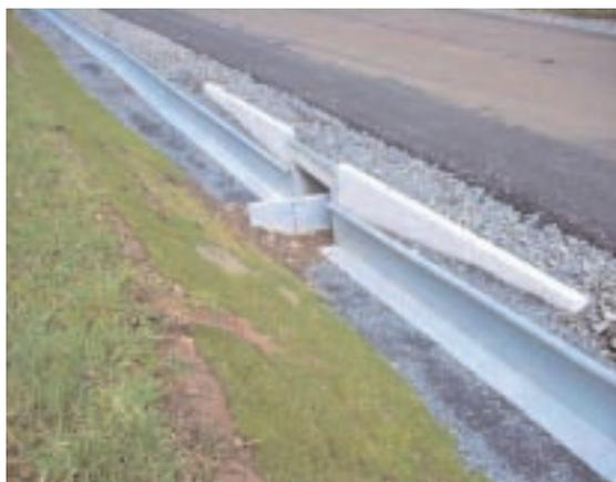
Foto 18.89 - Particolare provvedimento di svio. Foto Maibach
