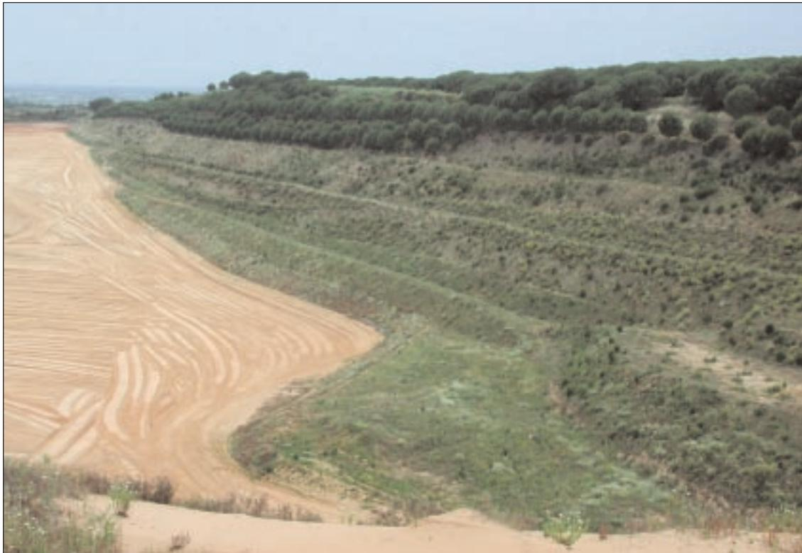
Foto 4a - Situazione attuale: vista delle scarpate recuperate (la coltivazione prosegue nel piazzale di base)
