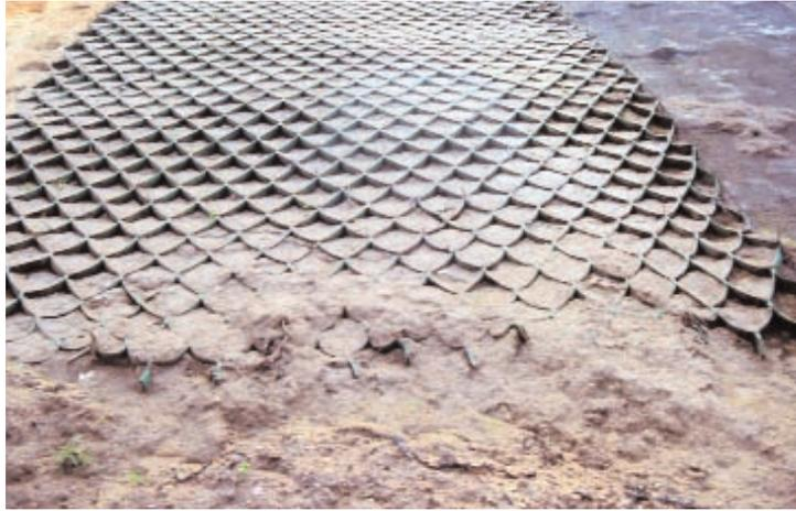
Geocelle in materiale sintetico su rilevato
