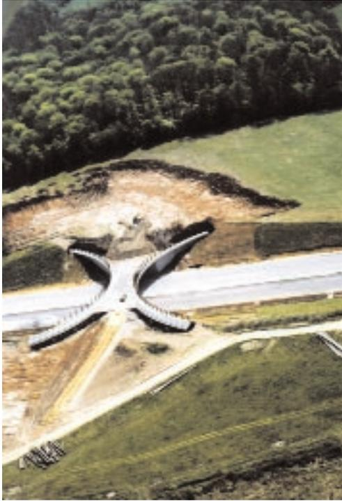
Foto 18.83 - Ponte per attraversamento di ungulati con invito a "imbuto". Lussemburgo 1990
