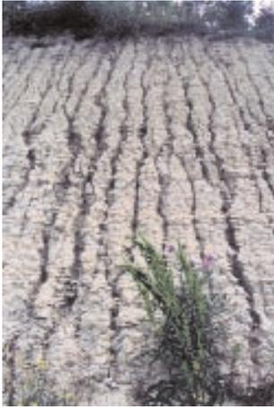
Foto 18.19 - Inizio di solchi di erosione su scarpate non rivegetate in trincea in litologia sciolta. Foto G. Sauli - 3° corsia Autostrada Orte-Fiano
