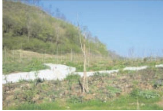
Foto 18.17 - Rivegetazione area boscata rilevato galleria Pileggi. Ben visibile un fosso di guardia realizzato in cls al posto di geostuoia tridimensionale bitumata inerbita prevista nel progetto 3a corsia Autostrada Orte-Fiano. Foto P. Cornelini
