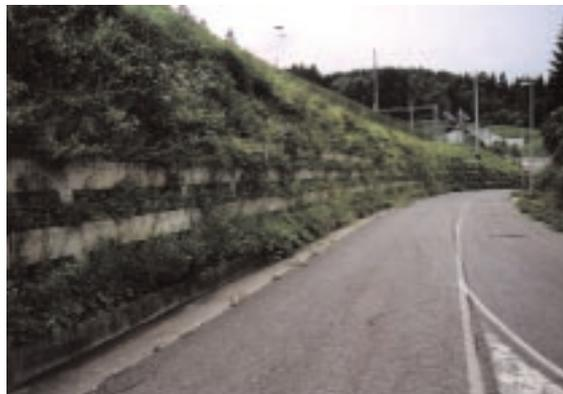
Foto 18.46 - Muro cellulare rinverdito. Stazione di Tarvisio Boscoverde (UD). Giugno 2003 - Foto G. Sauli
