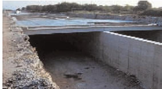
Foto 18.80 - Copertura artificiale di trincea per continuità faunistica. Loc. Prosecco (TS). Superstrada Trieste-Lisert - Foto G. Sauli
