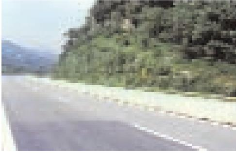
Foto 18.48 - Muro verde in terra armata rinverdito. Autostrada de Trafori Loc. Invorio. Foto G. Sauli - 1998
