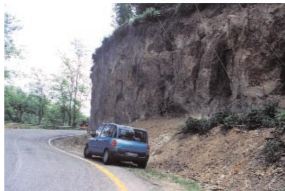
Foto 18.38 - Scarpata in roccia verticale, rivestita in rete metallica. S.S. per Bagnoregio (VT). Foto G. Sauli
