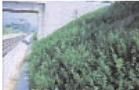
Foto 18.36 - Scarpate in trincea in argilla stabilizzate con rivestimento in rete metallica e stuoia organica dopo insuccesso del trattamento con sola idrosemina. Arezzo - Ferrovia direttissima Firenze-Roma
