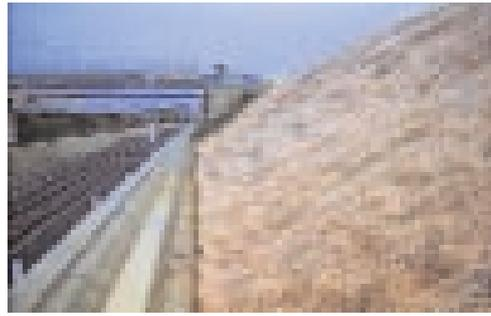
Foto 18.35 - Scarpate in trincea in argilla stabilizzate con rivestimento in rete metallica e stuoia organica dopo insuccesso del trattamento con sola idrosemina. Arezzo-Ferrovia direttissima Firenze-Roma
