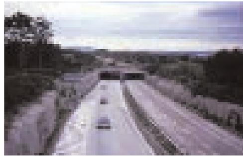
Foto 18.81 - Galleria artificiale rivegetata con funzione di sovrappasso per ungulati in zona carsica. Superstrada Trieste-Lisert Foto. G. Sauli
