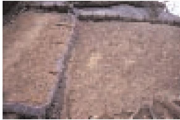
Foto 16.42 - Rivegetazione versanti rocciosi, diga di Ridracoli, geocelle a nido d'ape – fase di riempimento con terra vegetale
