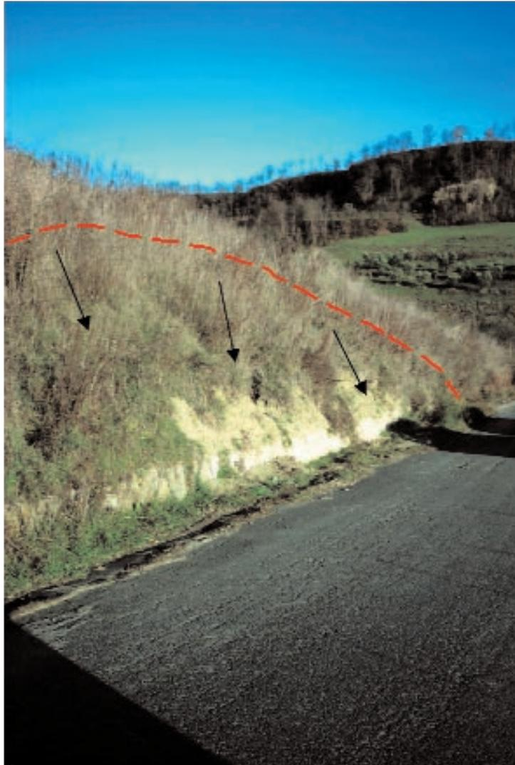
Scarpata ante-operam con linea di frattura e direzione del movimento franoso
