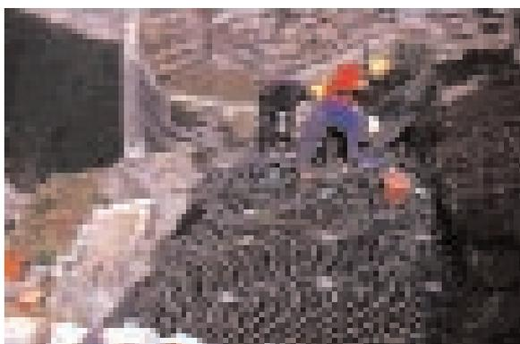
Foto 16.45 - Rivegetazione versanti rocciosi, diga di Ridracoli, rivestimento a materasso in opera
