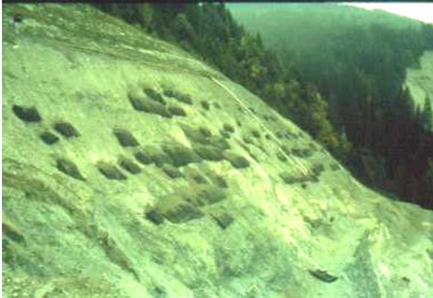
Foto 2: Miniera di Giustino durante i lavori – Foto G. Sauli
