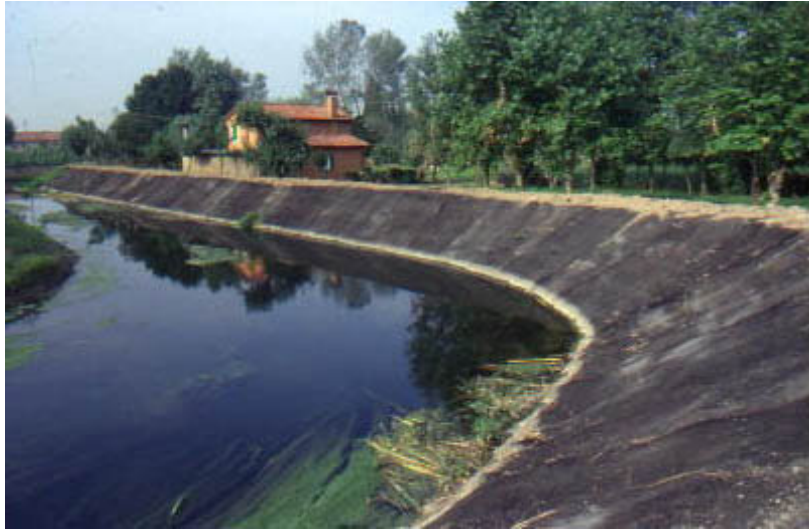
Foto 1: Rivestimento in geostuoia in nylon tridimensionale prebitumata e rinverdata, Fiume Zero, Mogliano Veneto (TV) 1988.
