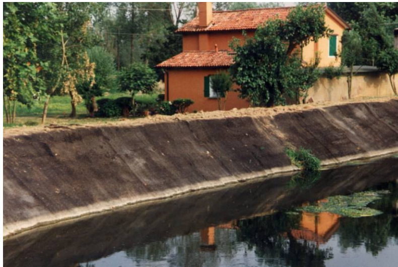
Foto 2: Rivestimento in geostuoia in nylon tridimensionale prebitumata e rinverdata, Fiume Zero, Mogliano Veneto (TV) 1988.
